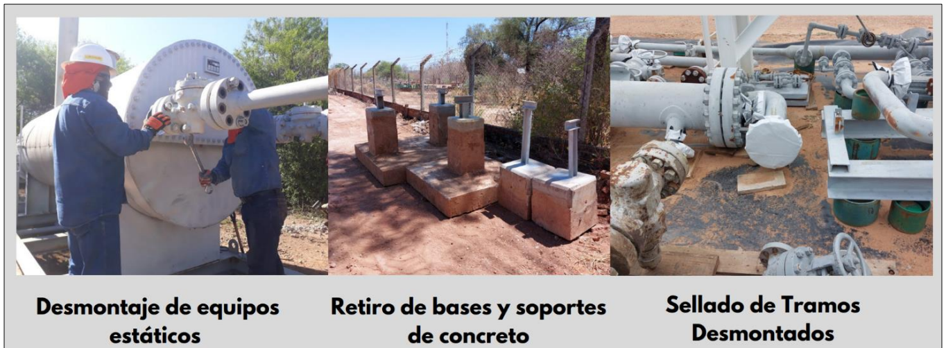
FIGURA 2 Desmontaje de Bases
