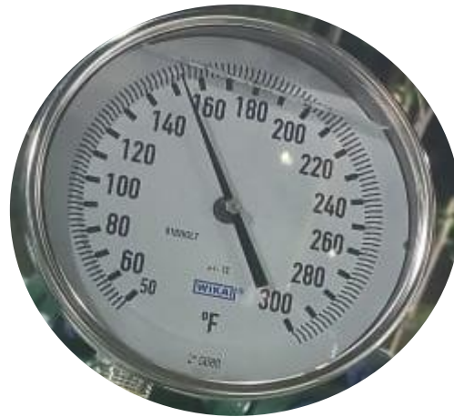
Figura 41.- Temperatura de la mezcla del fluido de los Pozos Huataracu 8-28-29
