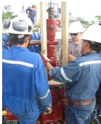
Figura 7: Instalación de la base de la unidad LRP
