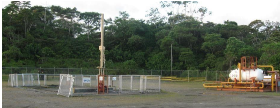
Nota 21: Foto del pozo BS-14
