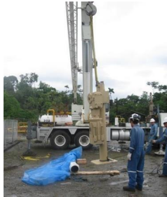
Figura 9: Izaje de la unidad
