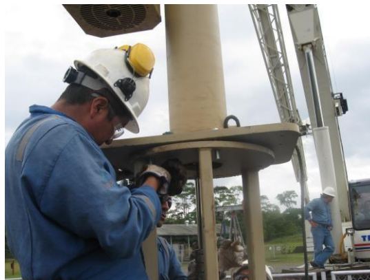
Figura 10: Ajuste y fijación de la unidad LRP sobre la base.
