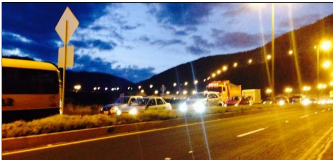
Figura 9. Tramo de la Vía Guayllabamba-Quito al atardecer
