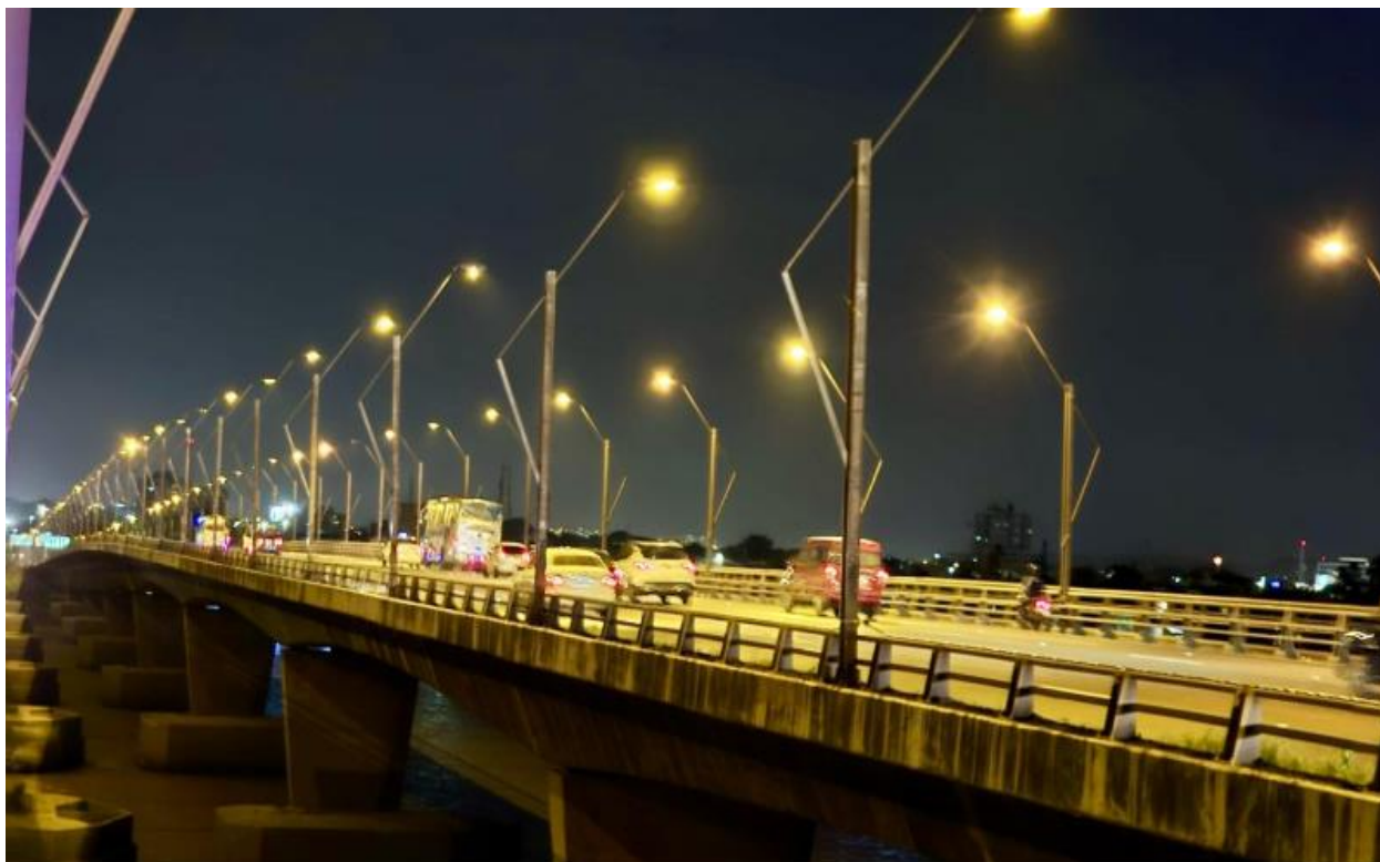
Figura 6: Puente de la Unidad Nacional Fuente: CNEL EP
