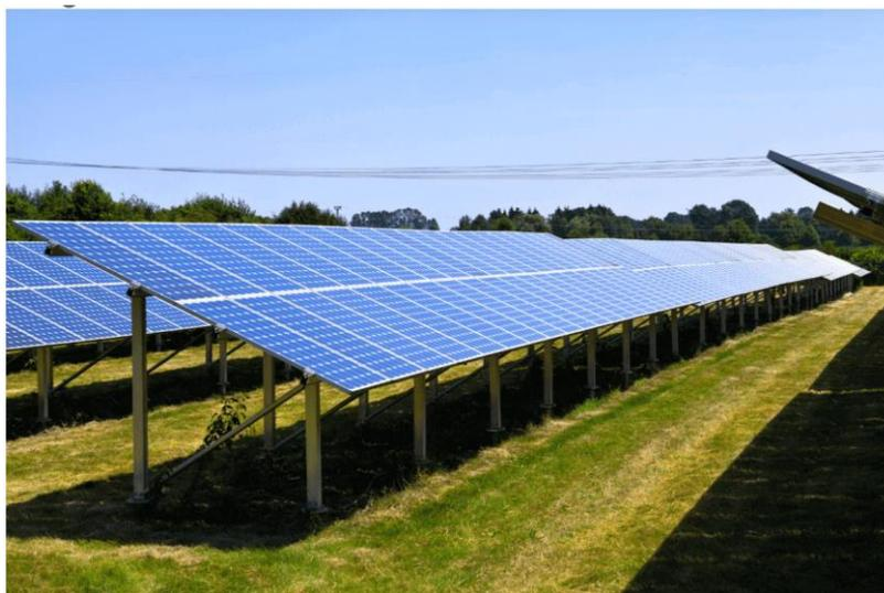
**Figura 12:** Ubicación de las Estructuras para paneles solares a 15° de inclinación
