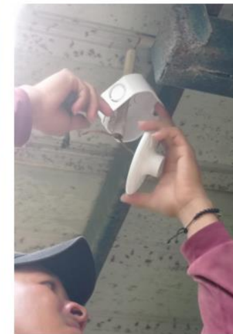
Reemplazo de caja octagonal y rosetón
