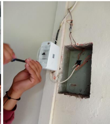
Reemplazo de breaker termomagnético
