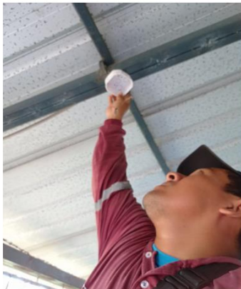
Reemplazo de caja octagonal
