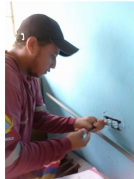
Limpeza de los pemos del toma corriente
