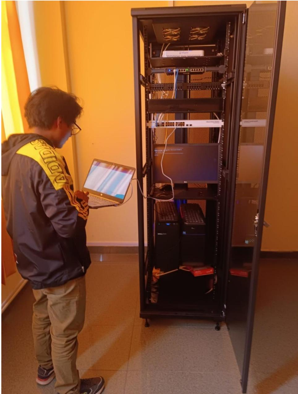
Ilustración 10: Configuración de Switch Mikrotik CSS 326-24G-2S+RM
