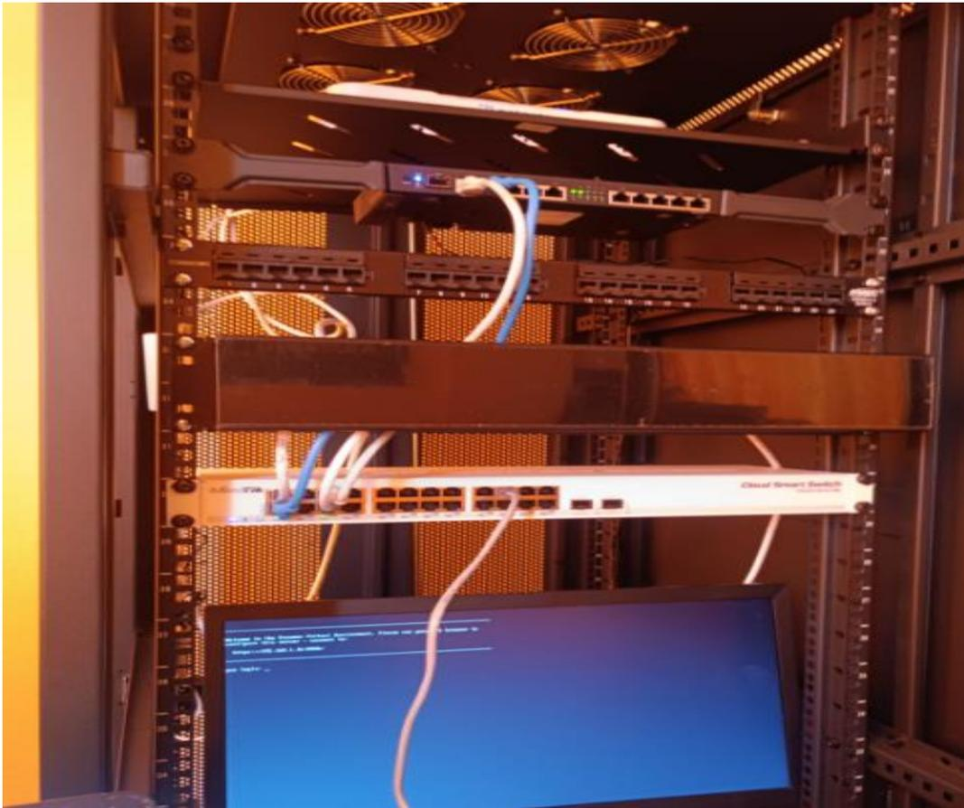
Ilustración 21: switch montado dentro del rack
