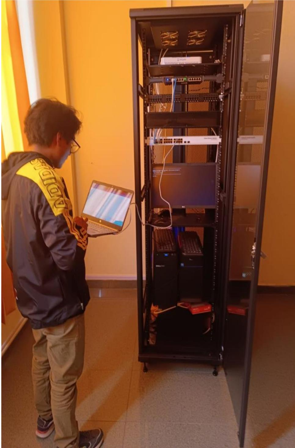
Ilustración 23: Configuración de Switch Mikrotik CSS 326-24G-2S+RM
