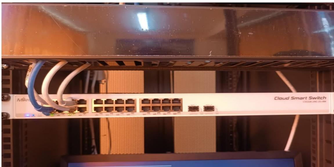
Ilustración 9: switch montado dentro del rack
