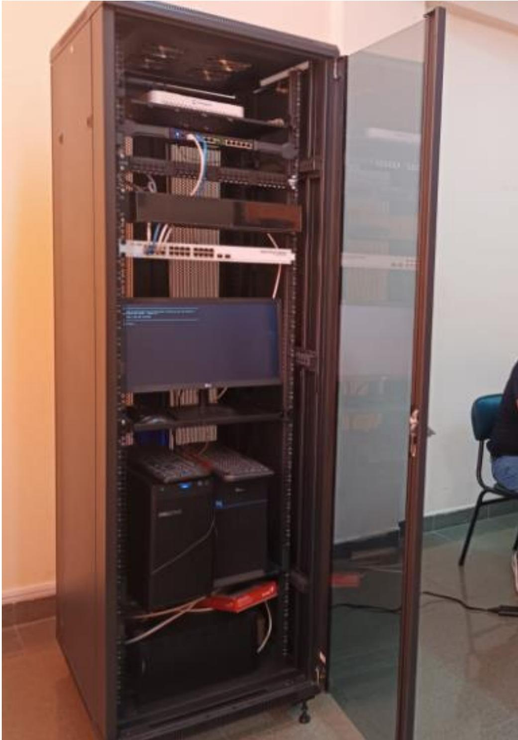
Ilustración 22: switch montado dentro del rack
