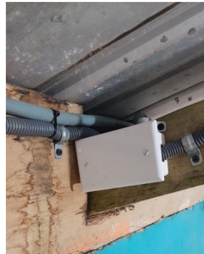
Figura 28 Distribución de circuitos a través de cajas de paso
