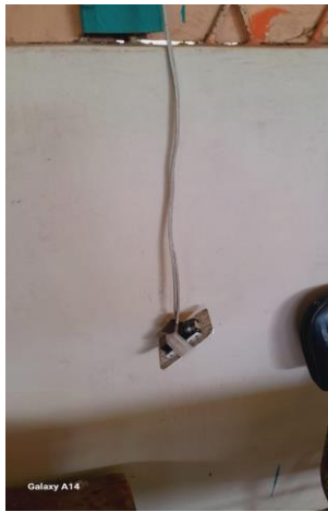
Figura 26. Instalación de tomacorrientes empotrados y sobrepuestos.
