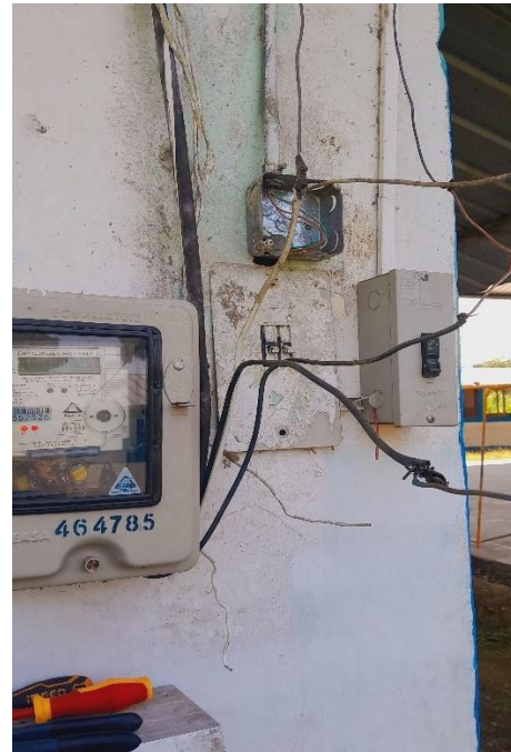
Cajas térmicas en mal estado sin funcionamiento y cableado a la intemperie
