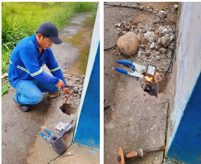
Figura 29. Instalación de puesta a tierra
