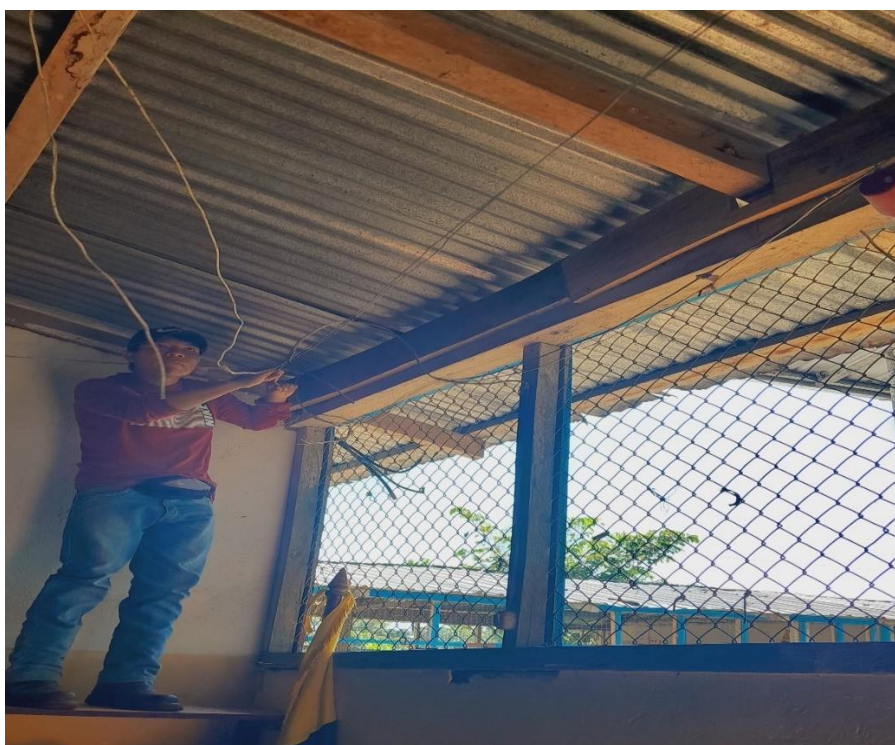
Desmantelación de conductores de circuitos existentes en mal estado
