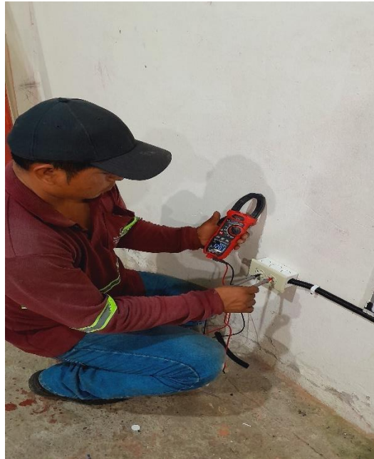
Medición en los tomacorrientes instalados
