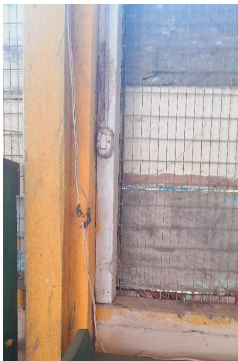
Cableado e interruptor en mal estado de los circuitos de iluminación sin canalización.
