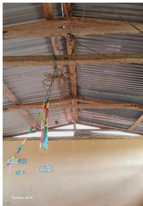
Cableado e interruptor en mal estado de los circuitos de iluminación sin canalización.
