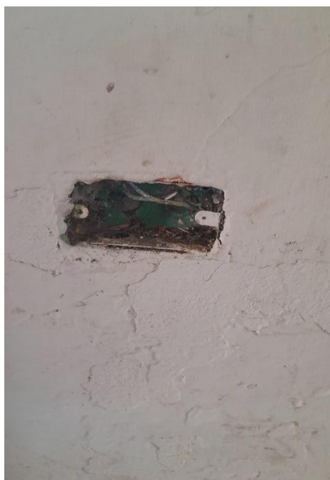
Tomacorrientes sin canalizaciones deteriorados por falta de mantenimiento
