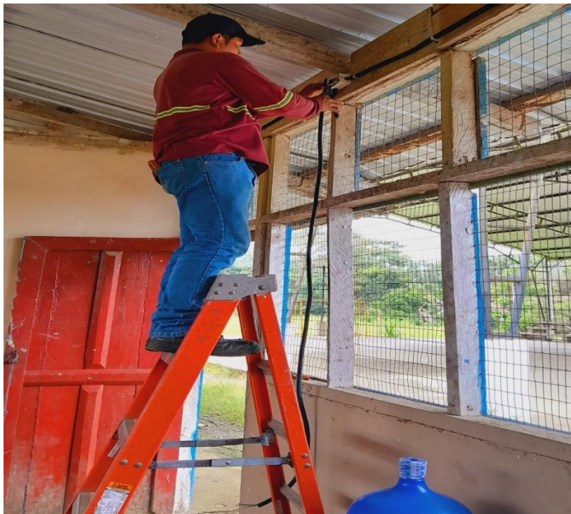
Instalación de caja de paso
