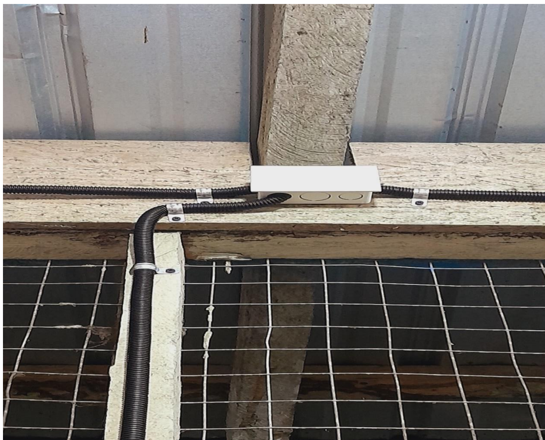
Instalación de caja de paso para división de circuitos
