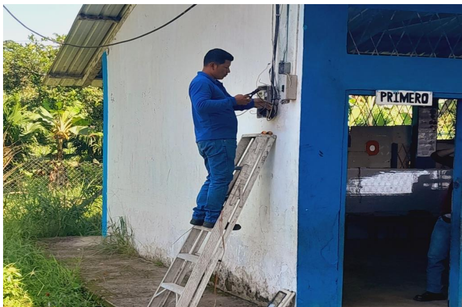
Desconexión de conductores existentes desde el medidor
