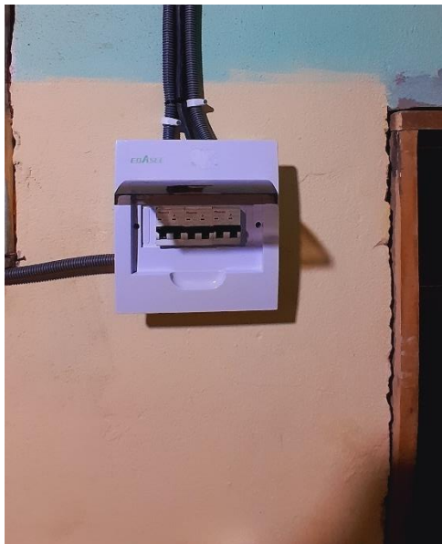
Instalación de 2 cajas térmicas tipo rioldin en cada bloque
