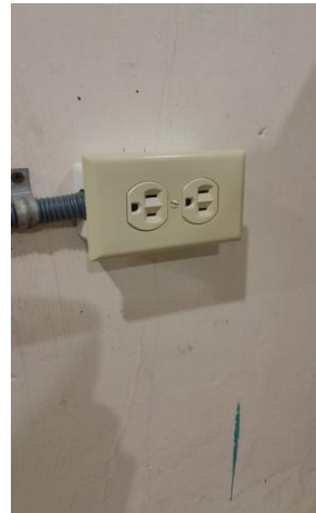
Figura 26. Instalación de tomacorrientes empotrados y sobrepuestos.
