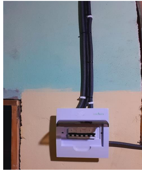
Figura 25 Tablero principal 1 centro de carga.
