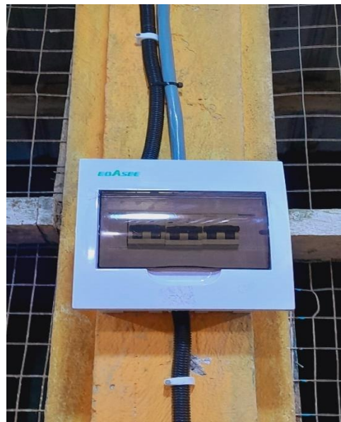
Instalación de 2 cajas térmicas tipo rioldin en cada bloque
