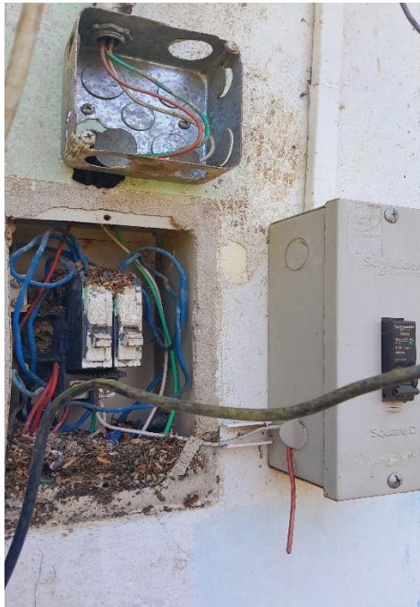
Cajas térmicas en mal estado sin funcionamiento y cableado a la intemperie
