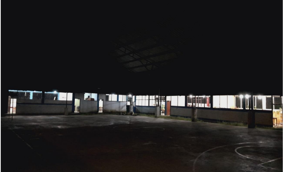
Iluminación de los 2 bloques de todas las aulas desde los exteriores de la escuela
