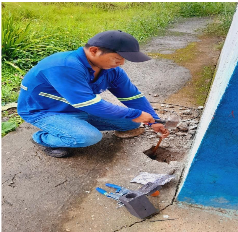
Instalación de puesta a tierra
