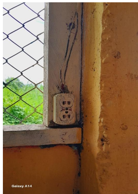
Tomacorrientes sin canalizaciones deteriorados por falta de mantenimiento
