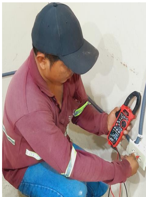
Figura 27 Medición de voltaje en los tomacorrientes inicial 111V y actual 120 V
