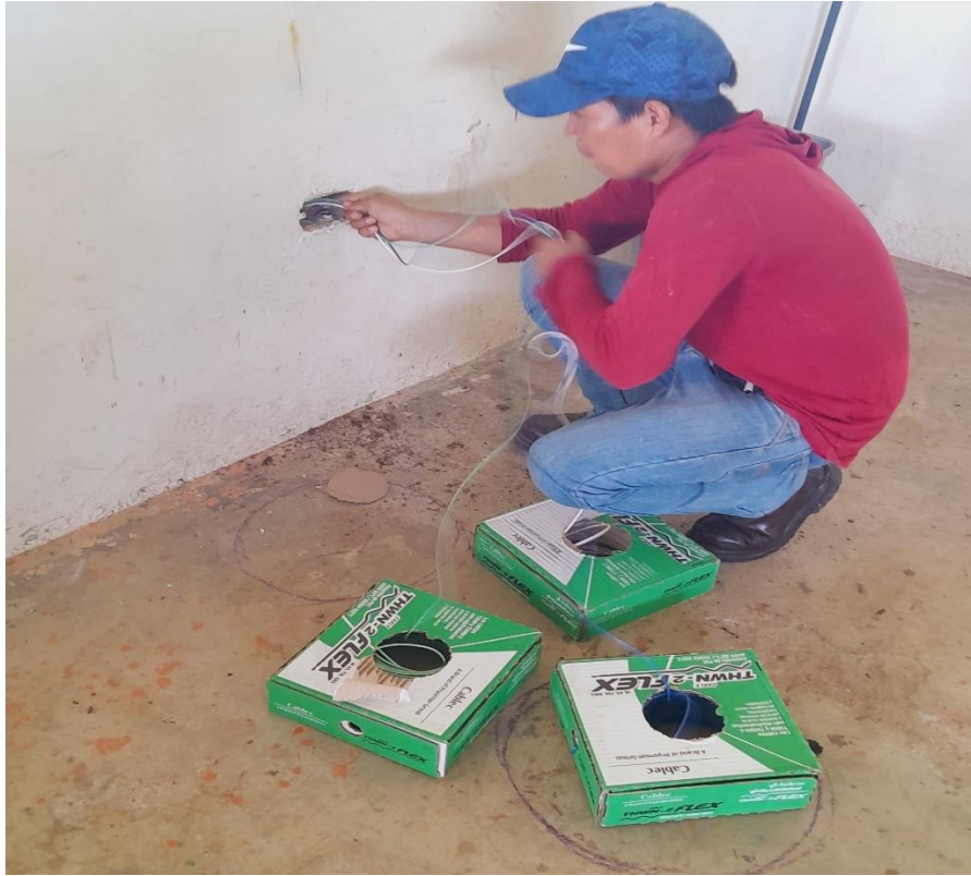
Cableado de conductores para instalación tomacorrientes
