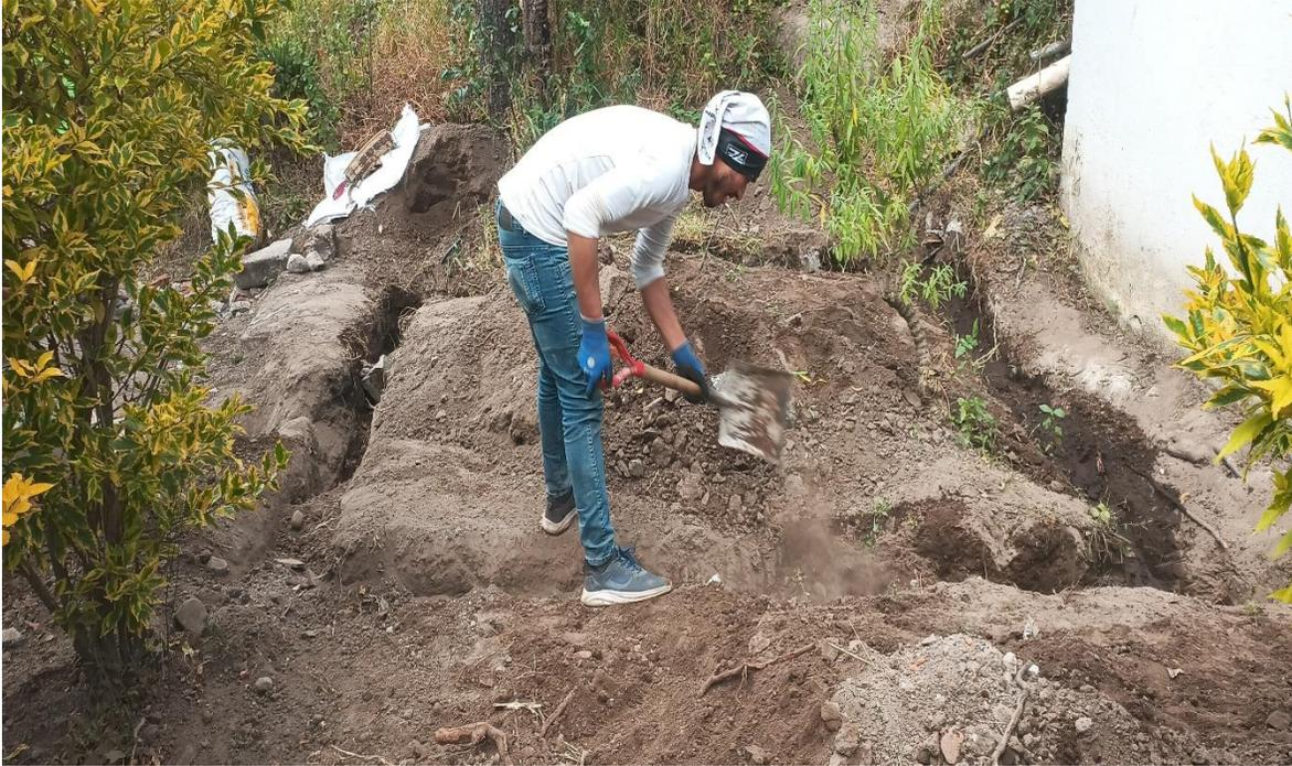
Figura 51: Relleno y compactación de zanja
