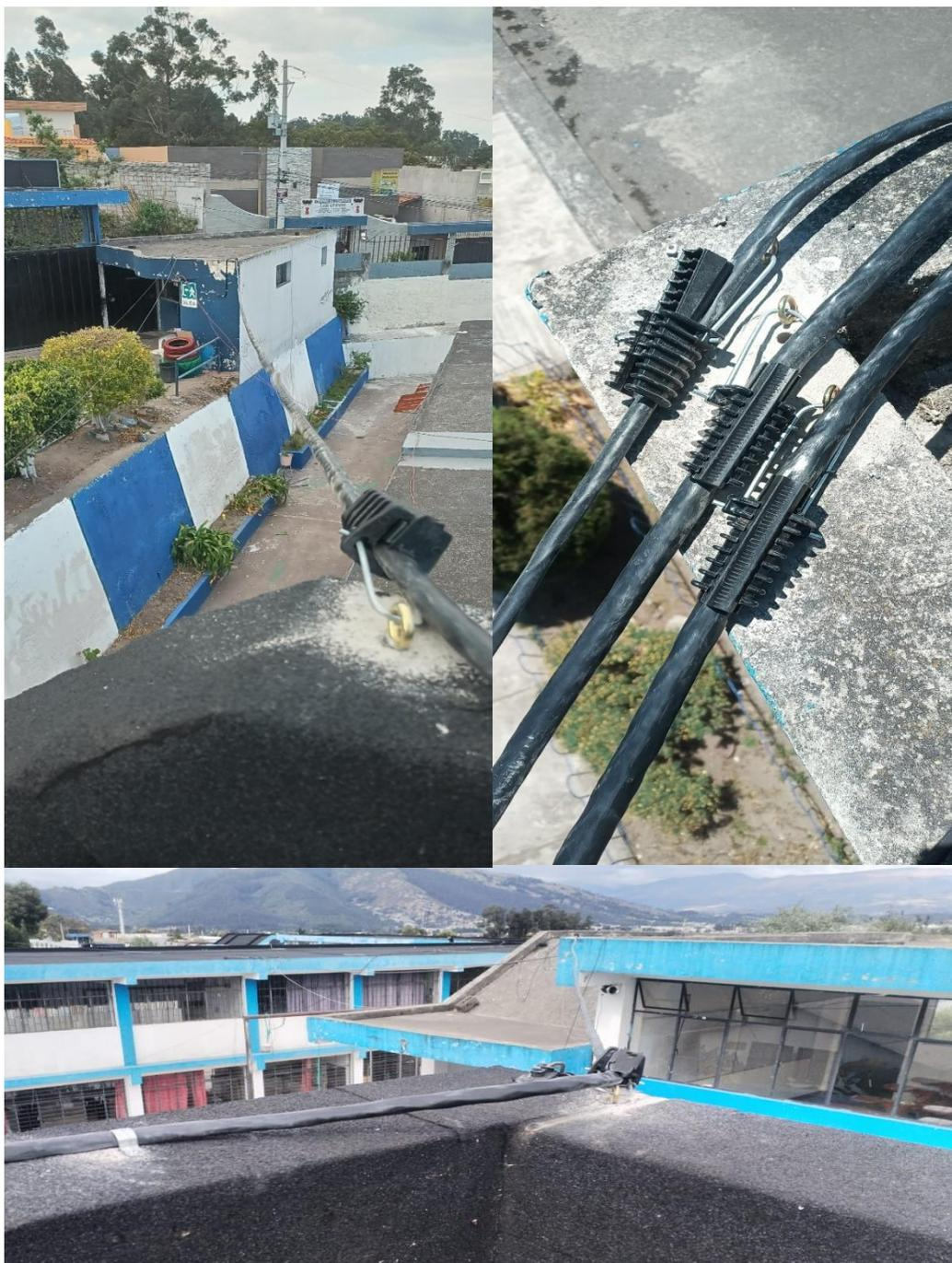
Figura 41: Anclaje de acometidas
