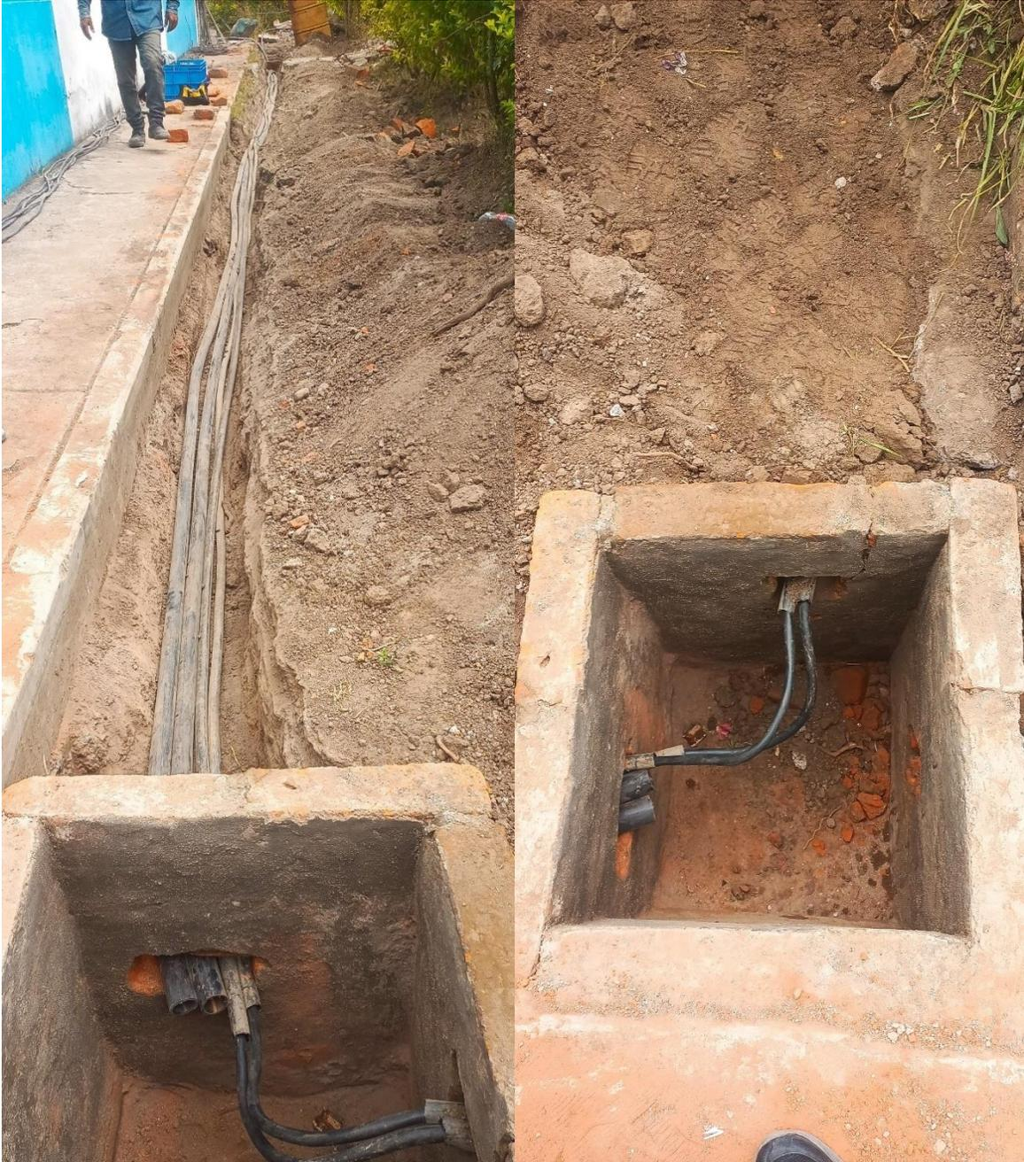
Figura 34: Tendido de ductos
