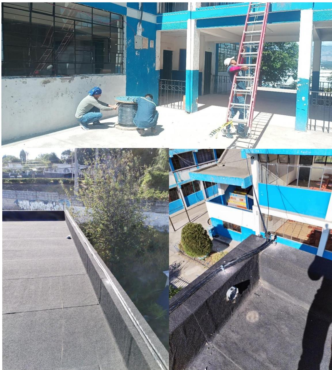
Figura 40: Instalación acometidas aéreas
