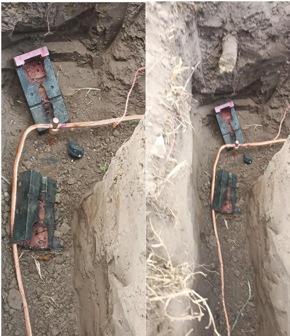
Figura 50: Suelda exotérmica
