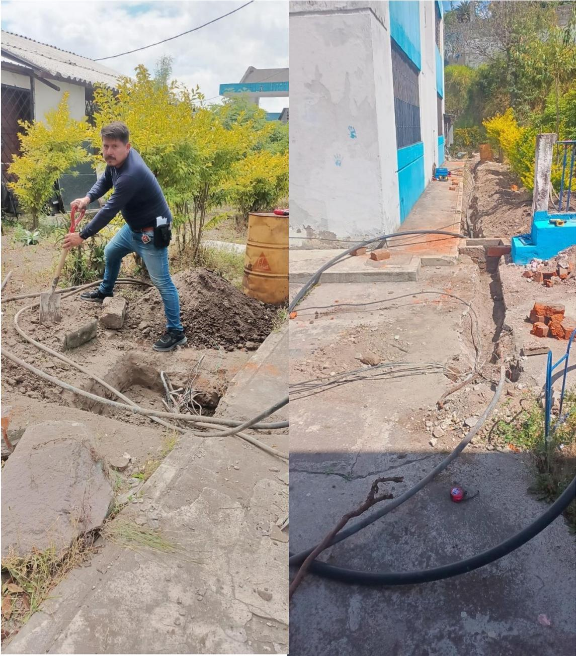
Figura 33: Apertura de zanja para SPT
