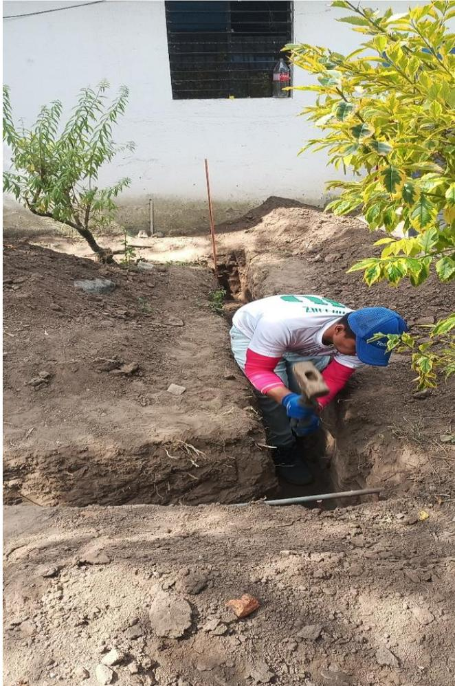
Figura 49: Excavación de zanja
