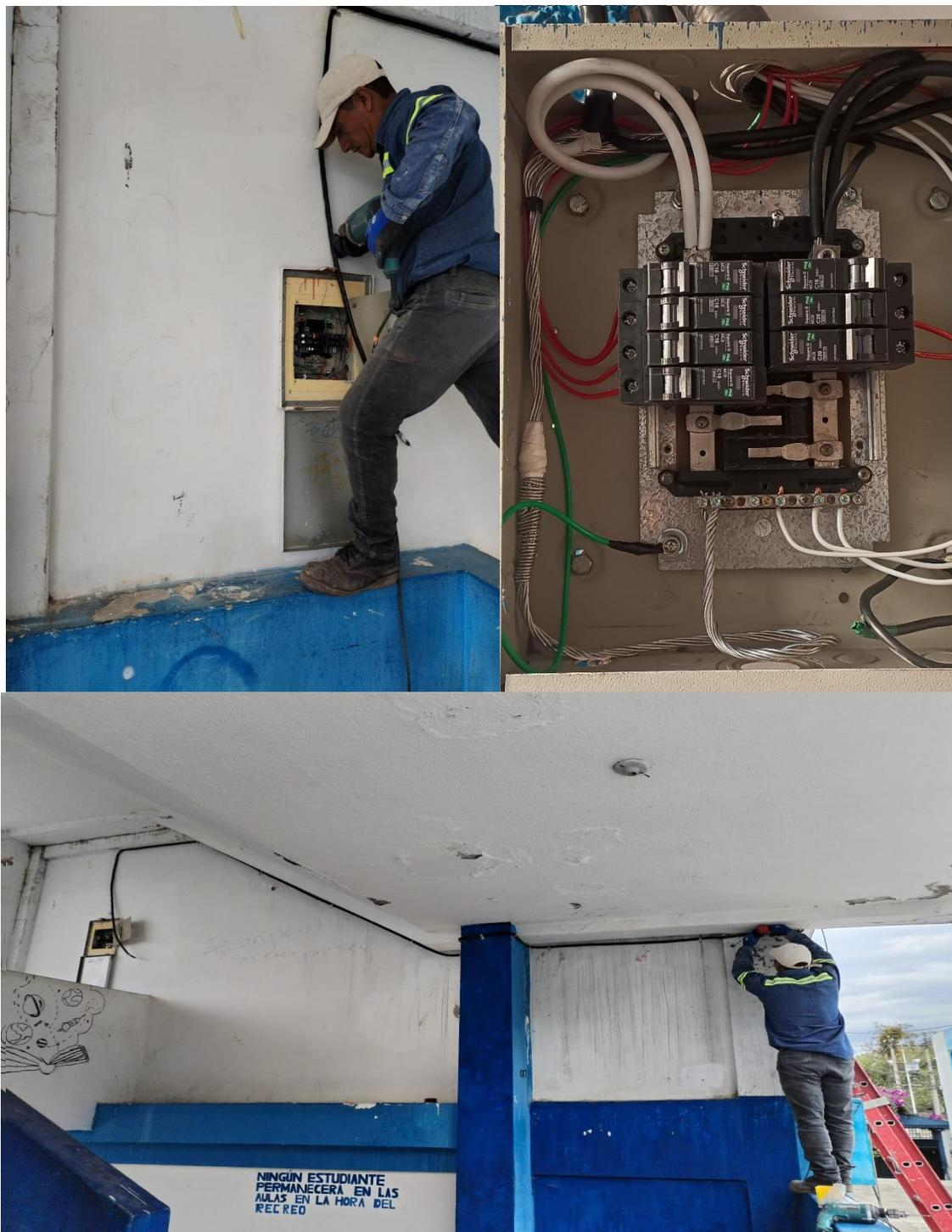
Figura 42: Conexión centro de carga
