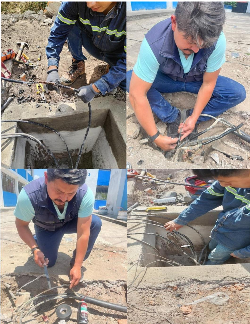
Figura 37: Mantenimiento y revisión de tendido existente
