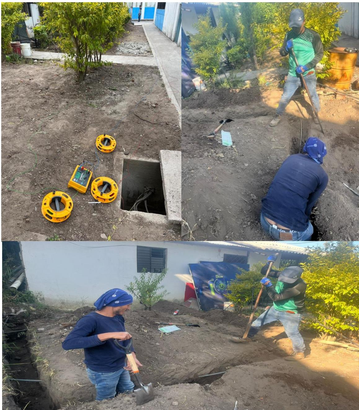
Figura 48: Proceso constructivo del S.P.T.
