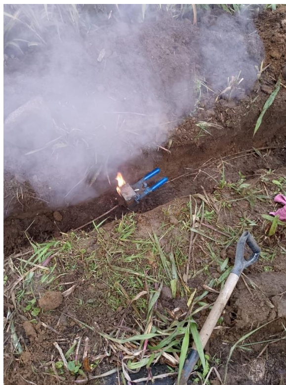
Preparación del suelda exotermica
