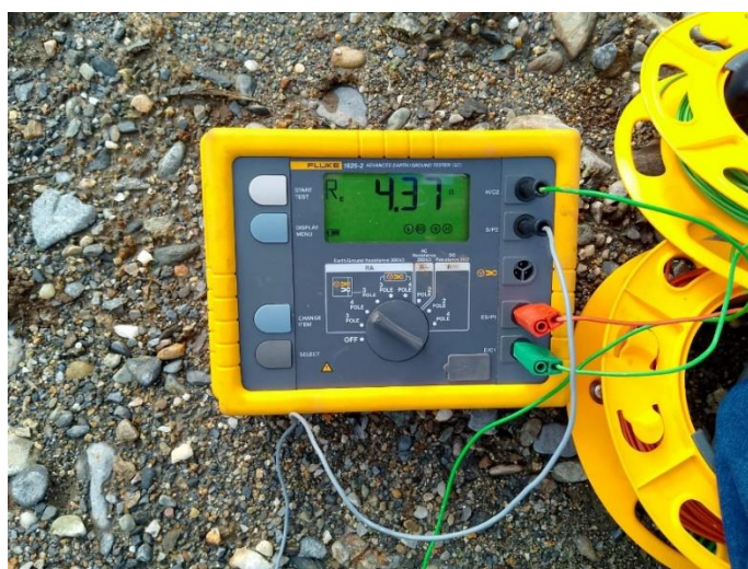
Resistividad adecuada del sistema a tierra
