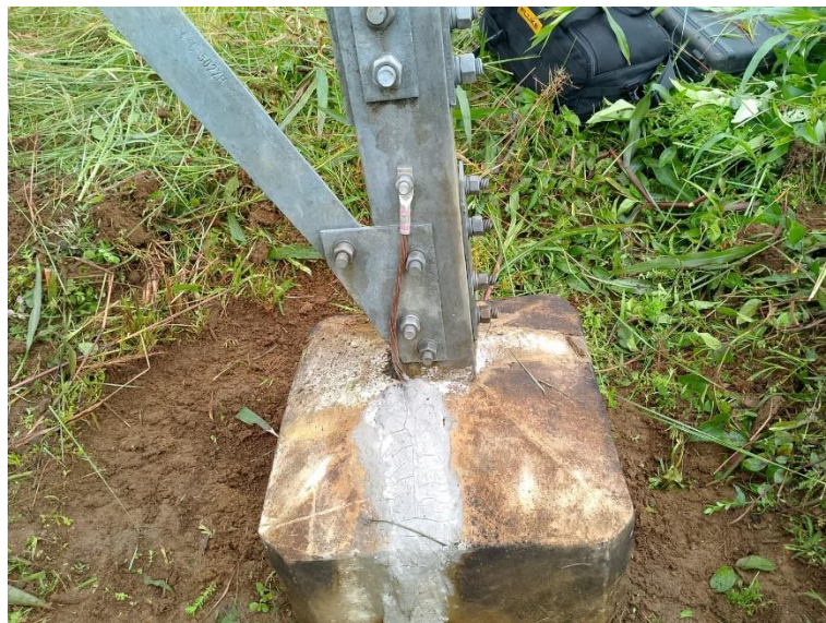
Cubrimiento del cable a tierra
