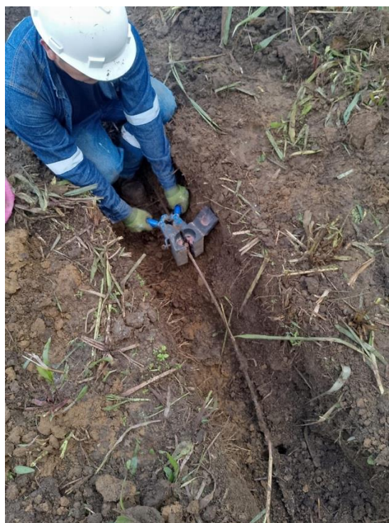
Preparación del suelda exotérmica
