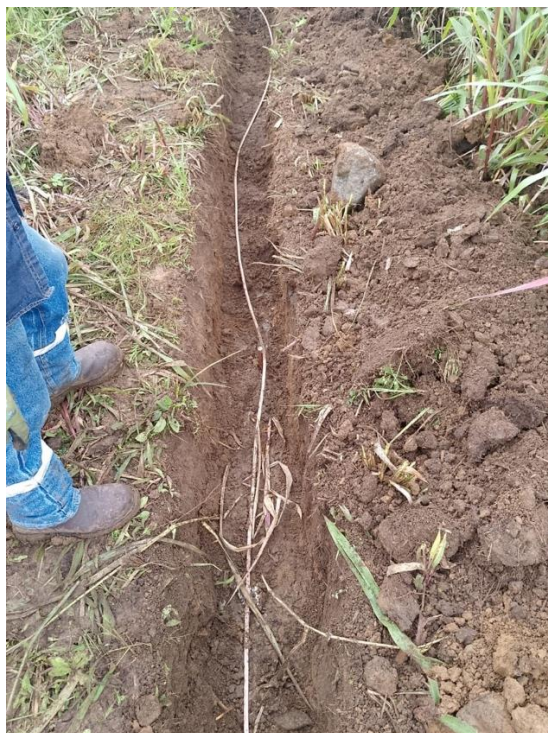
Preparación para suelda varilla - cable
