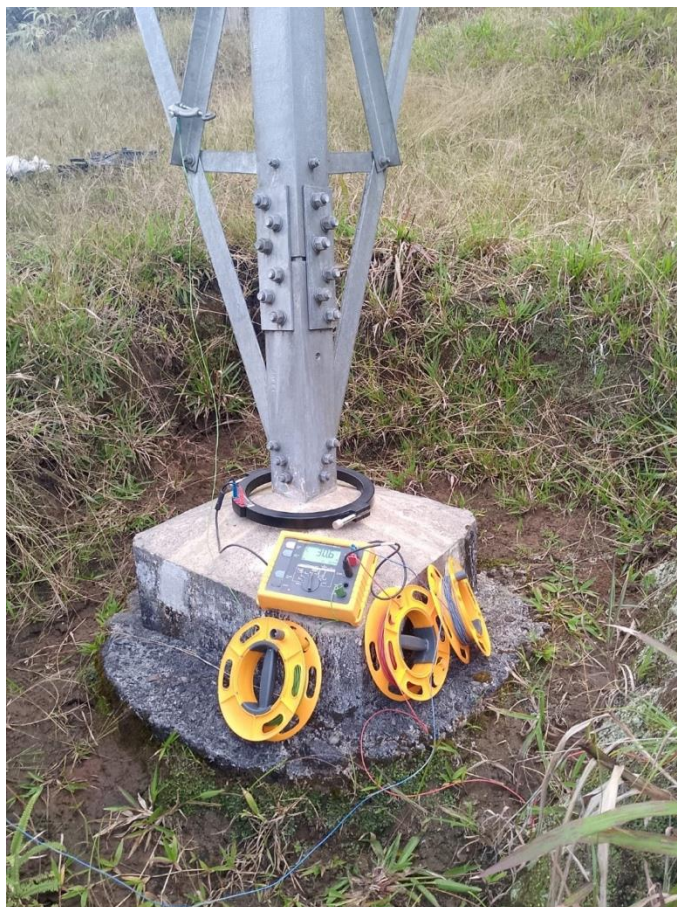
Verificación de la resistividad del sistema a tierra
