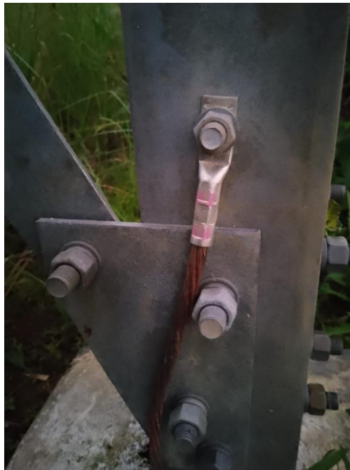
Machinado del terminal de puesta a tierra
