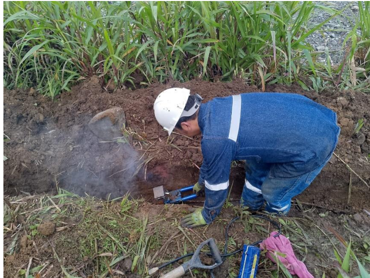
Preparación para suelda varilla – cable
