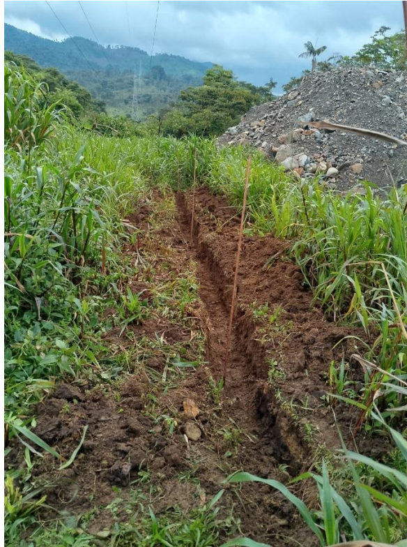
Figura 18. Verificación de sistema de puesta a tierra en sitio.
