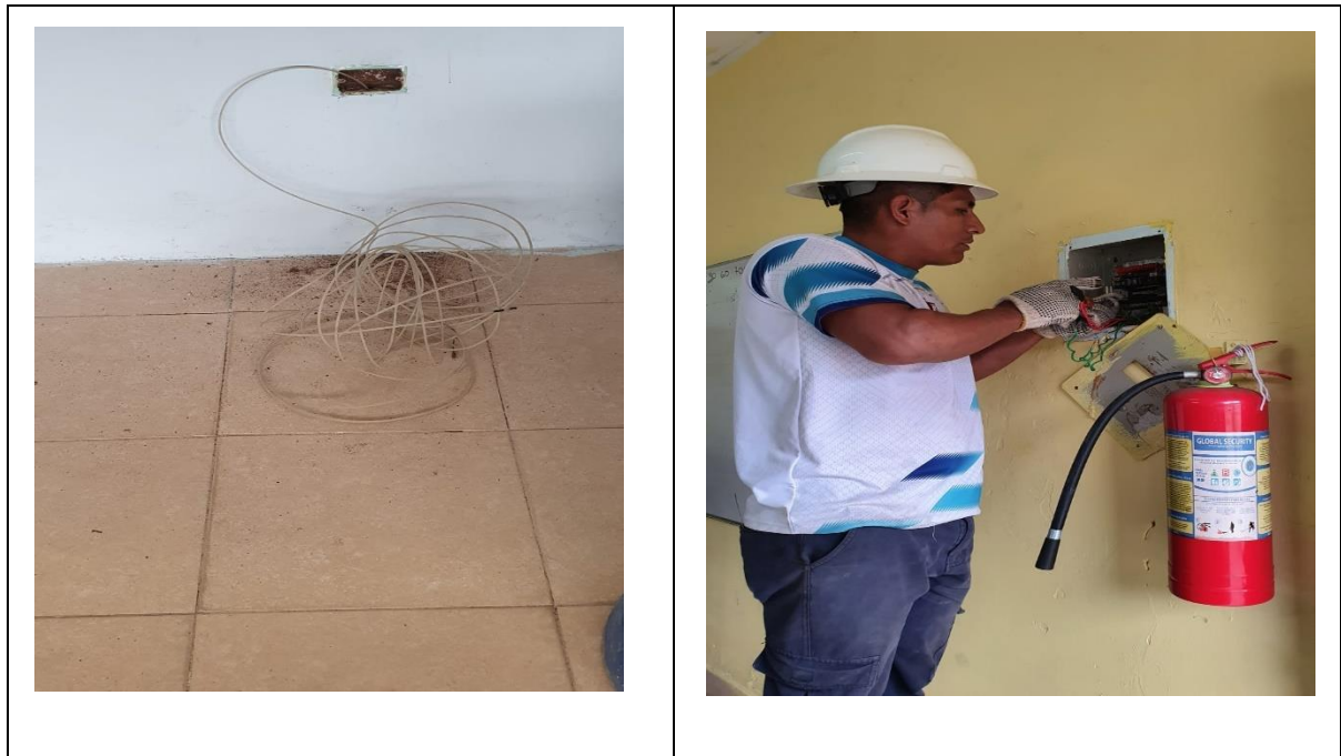
Figura. 26.-Adecuación de tomacorriente
