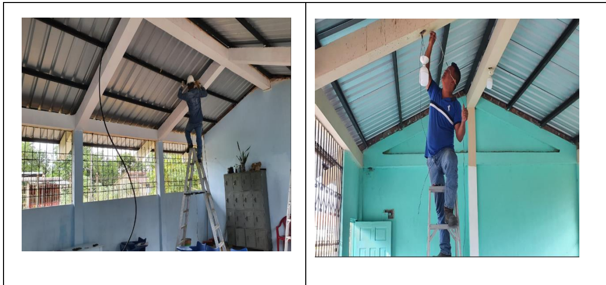
Figura 19.- Conductores eléctricos de la escuela.
