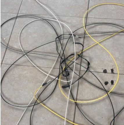
FIGURE 25: RETIRO DE CABLE #12 USADO PARA ILUMINACION
