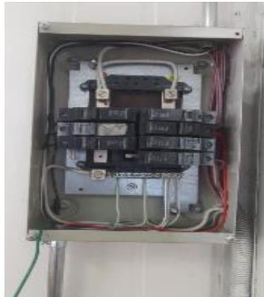
FIGURE 60: CAJA TERMICA DE LAS AULAS YA EXISTENTE CON ANTERIORIDAD
