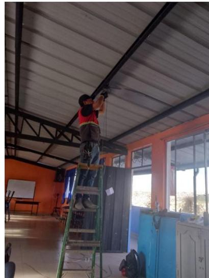
FIGURE 27: NUEVO CABLEADO PARA LUMINARIAS
