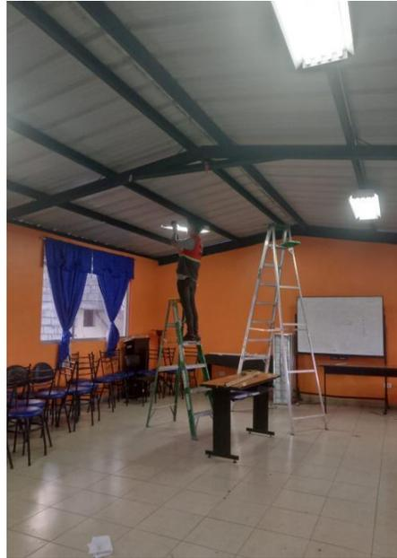
FIGURE 29: INSTALACIÓN NUEVAS LUMINARIAS
