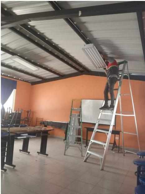
FIGURE 32: INSTALACIÓN NUEVAS LUMINARIAS
