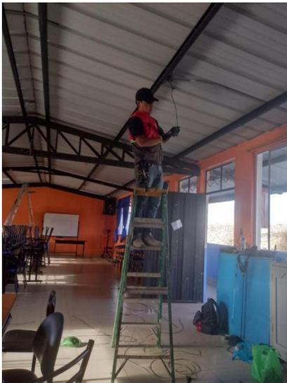
FIGURE 28: NUEVO CABLEADO PARA LUMINARIAS
