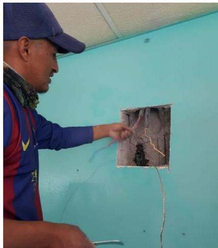
*Figura 36., Cableado para la caja térmica.*
