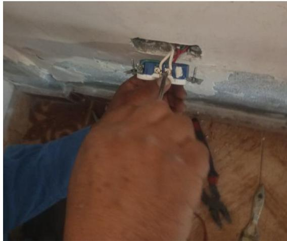
*Figura 40., Conexión de tomacorriente.*
