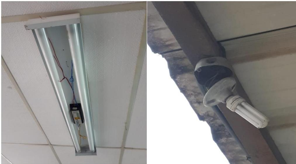
*Figura 33., Luminarias mal instaladas y peligrosas.*
