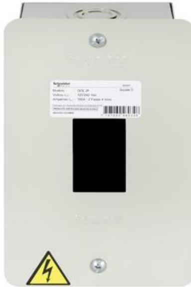
Figura 10., Tablero QOL bifásico de 2 circuitos.
