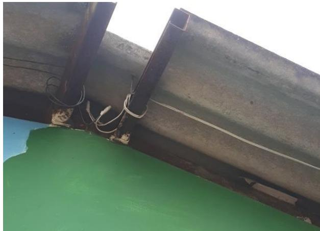
*Figura 31., Cableado fuera de ductos de protección.*
