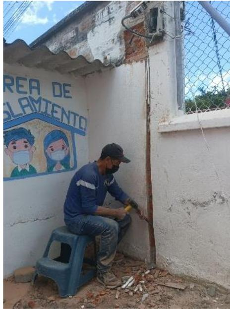
*Figura 34., Rozas para la tubería.*
