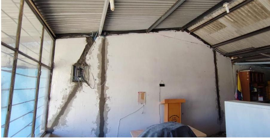
**Figura 31.** Se presenta luego de empotrado la tubería de la acometida y de CC 1 a la derecha y el plano correspondiente.
