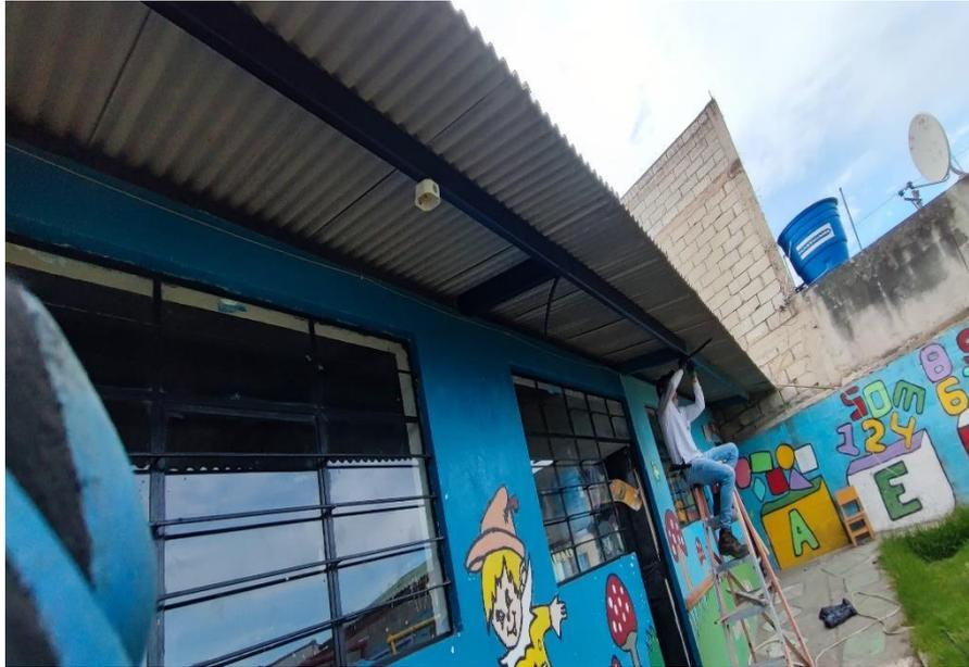
**Figura 35.** *Instalación de la tubería aérea para el circuito de iluminación del Corredor 2*
