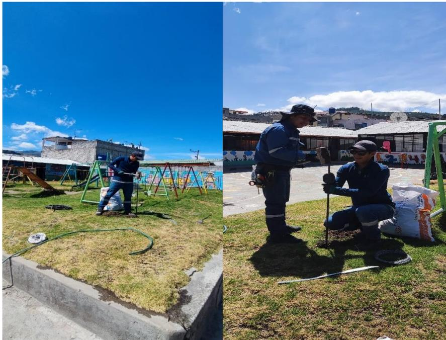
**Figura 43.** Preparación e Instalación de electrodo adicional para la medición de tierra.
