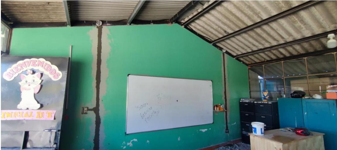
**Figura 37.** *Instalación de los cajetines para los toma corrientes en el aula 2.*
