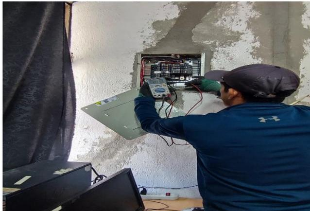
**Figura 32.** Verificación de conexiones una vez ya realizada la Instalación Eléctrica de CC 1 y sus Protecciones.
