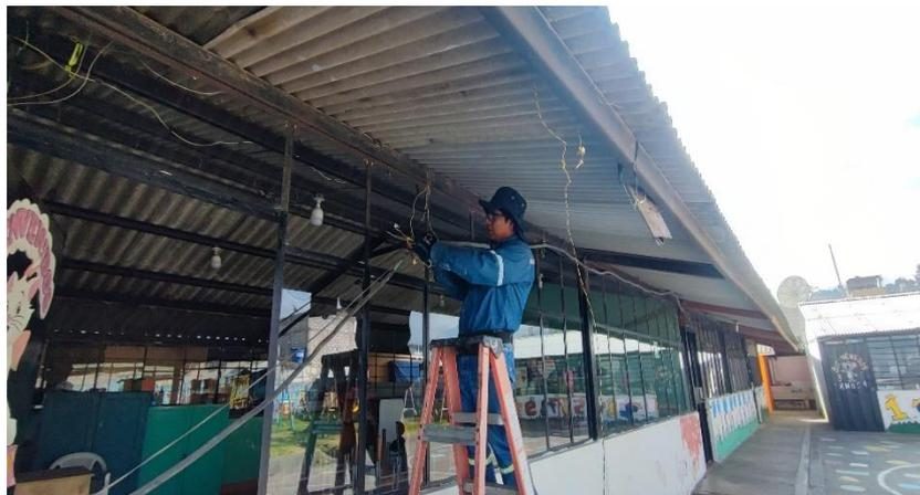
**Figura 34.** Instalación de la tubería aérea para el circuito de iluminación del Corredor 1
