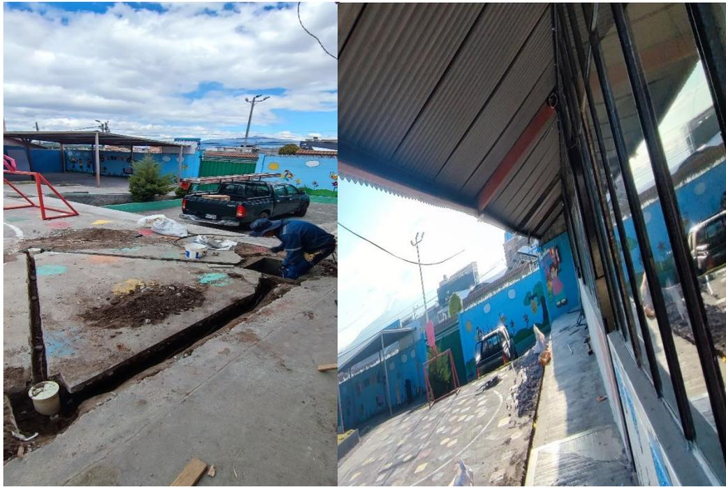
**Figura 33.** Muestra la excavación para el soterramiento de la acometida secundaria para CC 2 y la malla de puesta a tierra.
