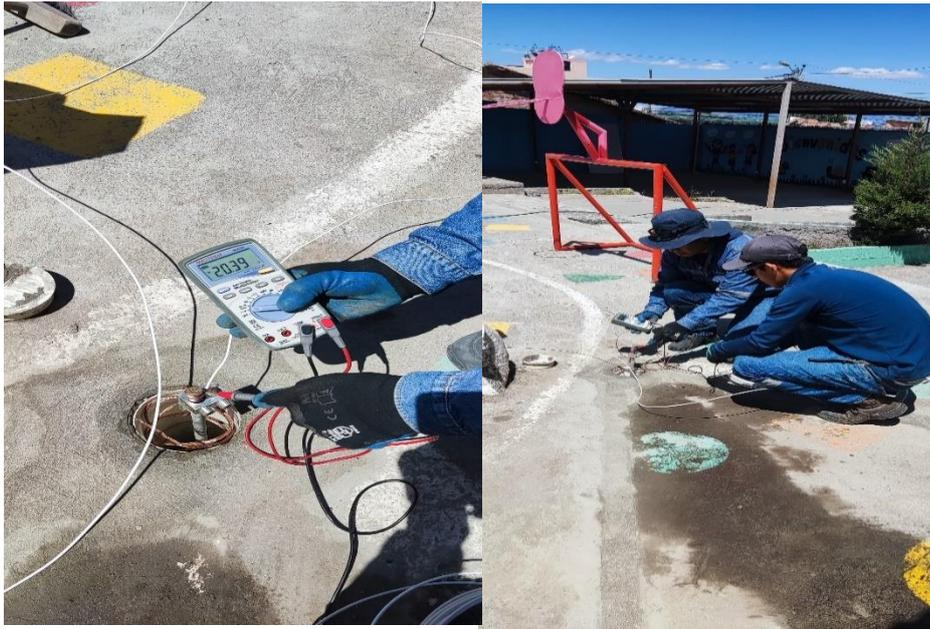
**Figura 44.** Medición del sistema de puesta a tierra encontrando un valor de 21,86 Ohm lo cual cumple la norma del Código NEC U.S.A. literal 100.
