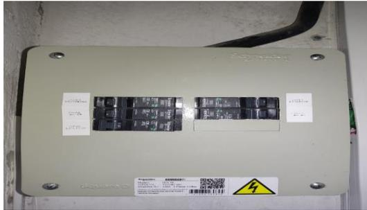
Figura 44. Distribución de energía rediseñada
