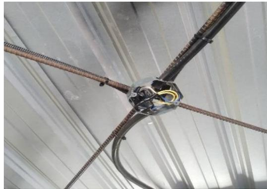
Figura 26. Instalación de cajas de revisión
