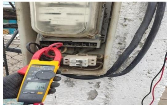
Figura 48. Equilibrio de cargas en fases principales en medidor
