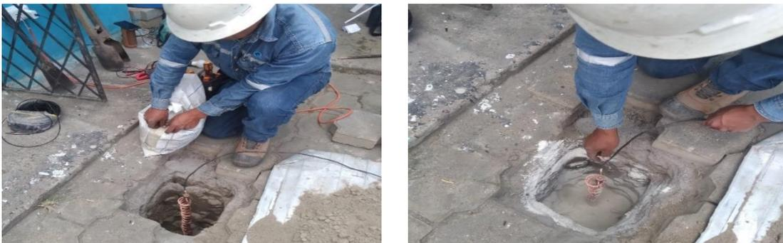
Figura 34. Preparación del suelo con diferentes elementos
