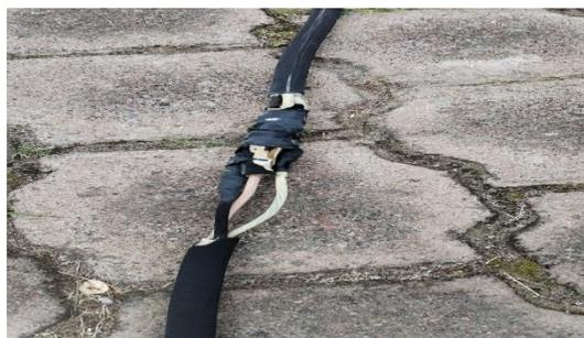
Figura 15. Cable de suministro ubicado entre el medidor y el panel de distribución.
