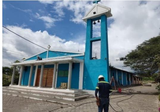
Figura 25. Cambio de la línea de acometida
