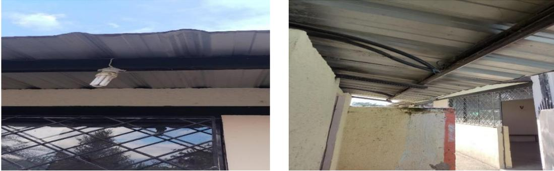
Figura 14 .Manguereado encontrado sin las debidas cajas de revisión o de paso
