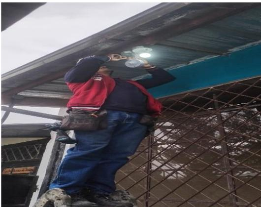
Figura 28. Instalación de sensores de movimiento
