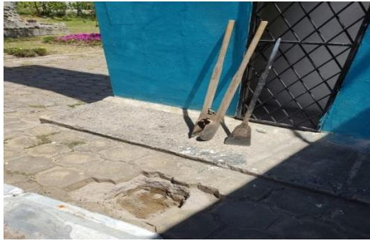
Figura 33. Excavación para el montaje de puesta a tierra
