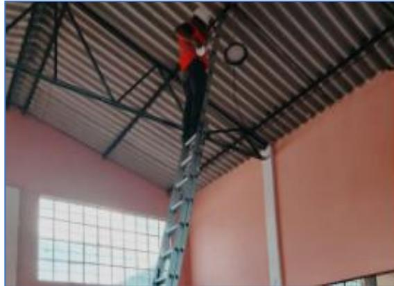
*Figura 35 Desmontaje de lámparas, ductos y cajas en mal estado.*
