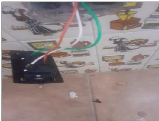
*Figura 40 Instalación de tomacorrientes nuevos.*
