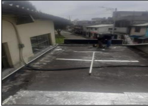
*Figura 41* Instalación de tuberías y cableado del alimentador.
