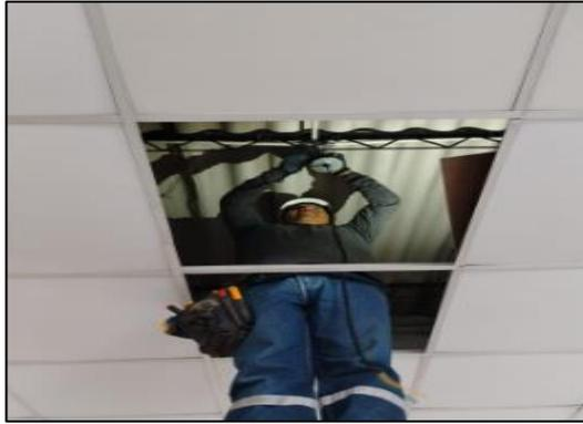
*Figura 39 Colocación de los cableados nuevos.*
