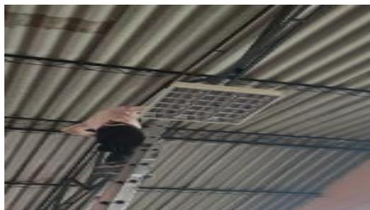
*Figura 34 Desmontaje de lámparas ductos y cajas en mal estado.*
