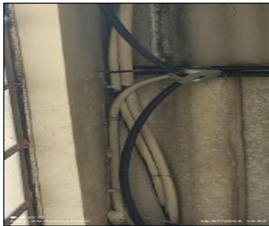
*Figura 33 Ductos y cajas en mal estado*
