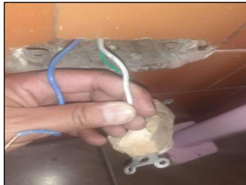
*Figura 38 Retiro de tomacorrientes en mal estado.*
