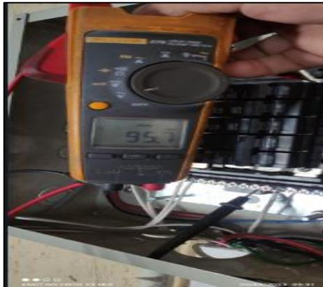
*Figura 46 Medida de voltaje en el tablero principal*
