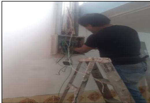
*Figura 43 Armado de tablero de distribución.*
