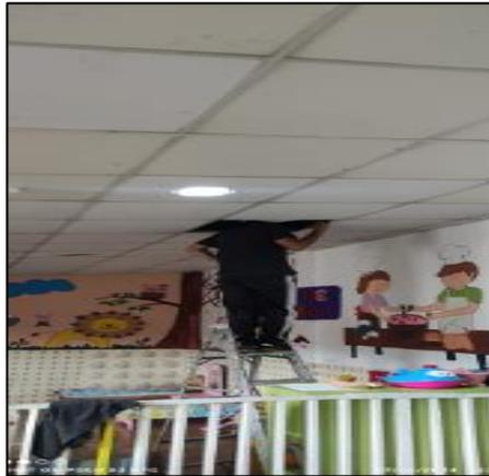
*Figura 29 Remoción de cielo falso y retiro de lámparas y cableados existentes.*
