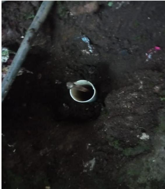
En la fotografía se muestra la colocación del molde para realizar la suelta exotermica, entre la varilla a tierra y el conductor, ya que debe haber una solida conexión no existía y se realizó la instalacion
