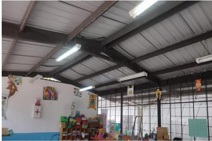
**Figura 12 Iluminación existente en 2do de básica**
