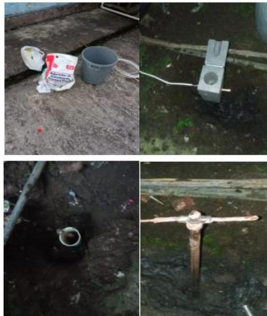
Figura 30 Instalación de Varilla a Tierra
