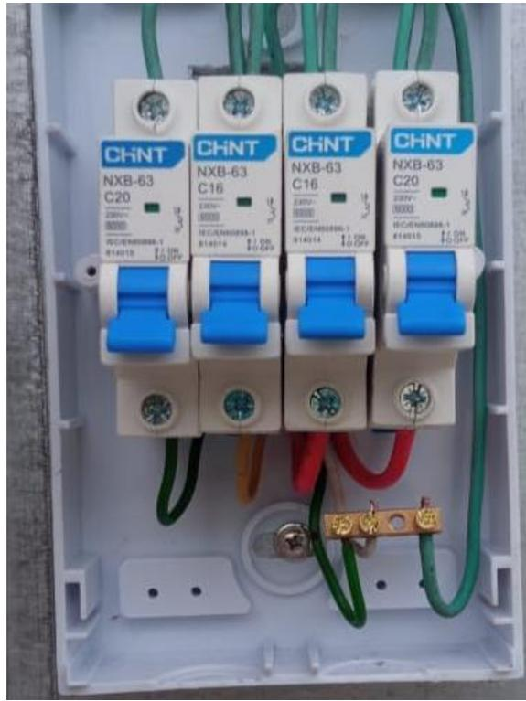
**Figura 32** Instalación de centros de carga
