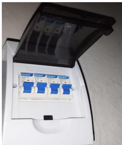
**Figura 40 Centro de carga con protecciones dimensionadas**
