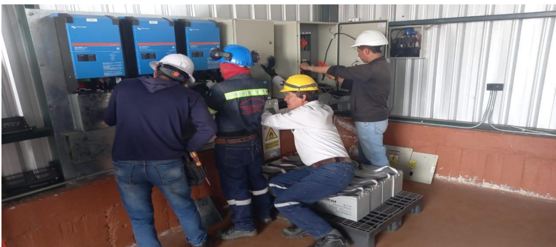
Figura 31.- Ejecución de mantenimientos en los equipos electrónicos. Fuente: Propia
