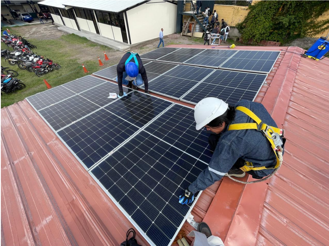
Figura 30.- Ejecución de limpieza de paneles Fotovoltaicos Fuente: Propia
