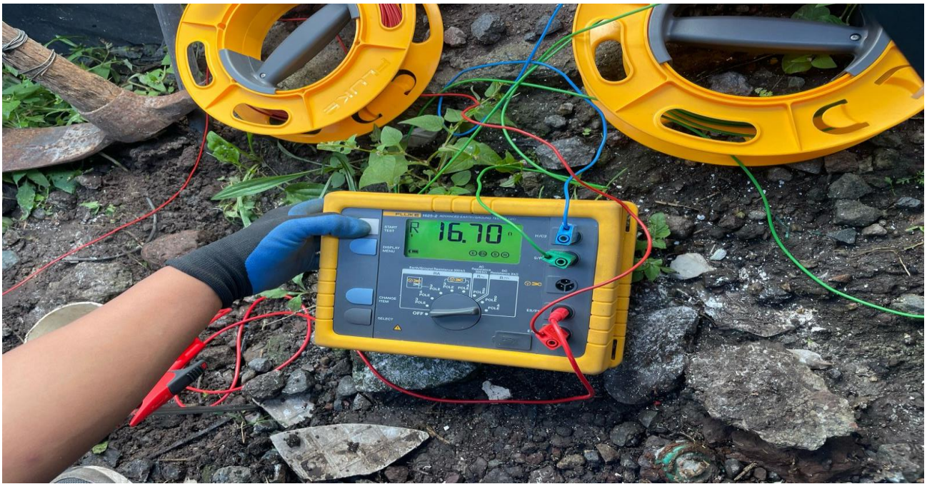
Figura 41.- medición de la resistividad del suelo a 1 metro de distancia de la pica principal. Fuente: Propia
