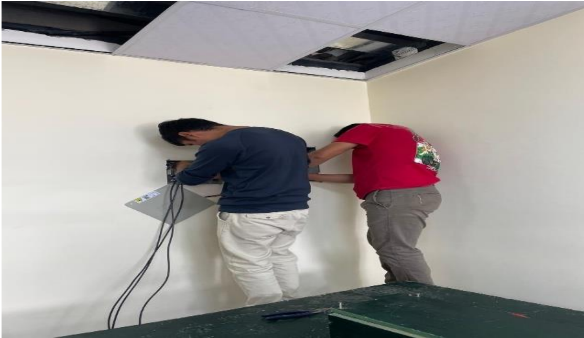
Figura 40.- Instalación de Acometidas a las distintas Cajas Térmicas Ubicadas en los Talleres. Fuente: Propia
