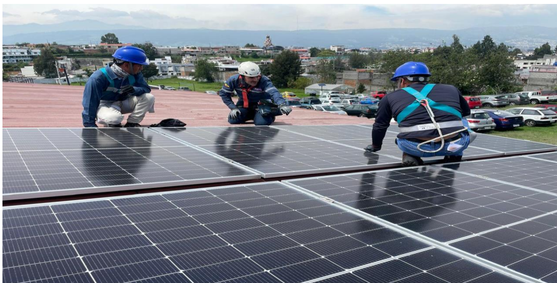
Figura 28.- Ejecución del mantenimiento fotovoltaicos con la empresa J3M Fuente: Propia
