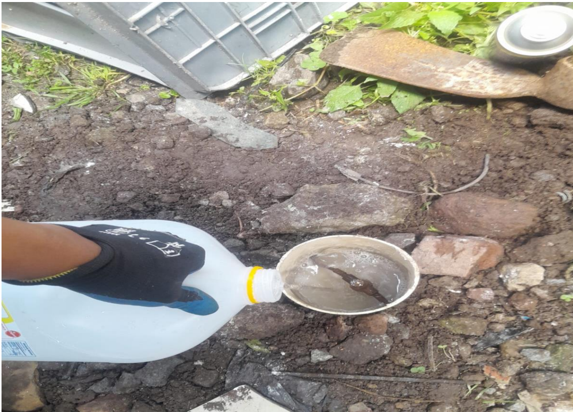
Figura 45.- Colocación del Agregado Electrolítico Solido. Fuente: Propia
