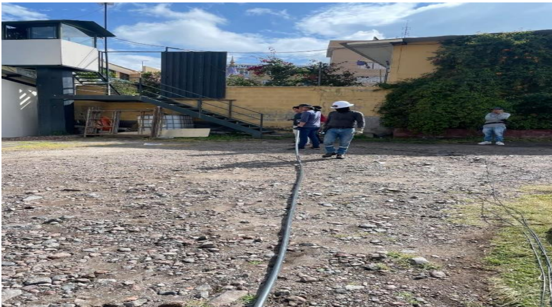
Figura 37.- Tendido de Cableado y Manguereado, para llevar la nueva Fuente: Propia
