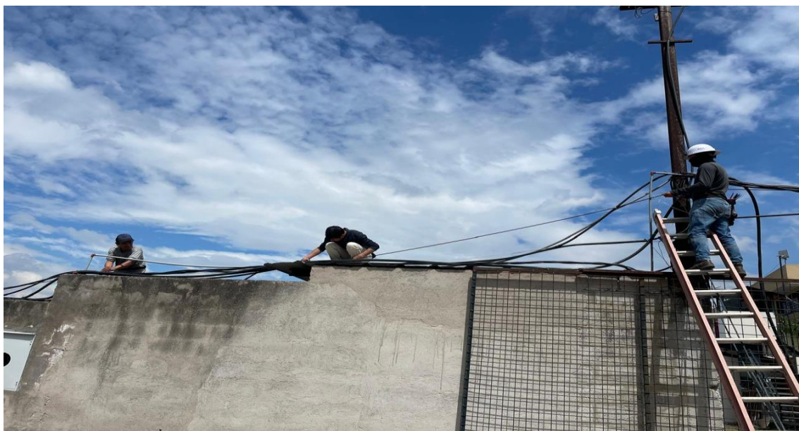
Figura 39.- Instalación Aérea de la Acometida nueva Fuente: Propia
