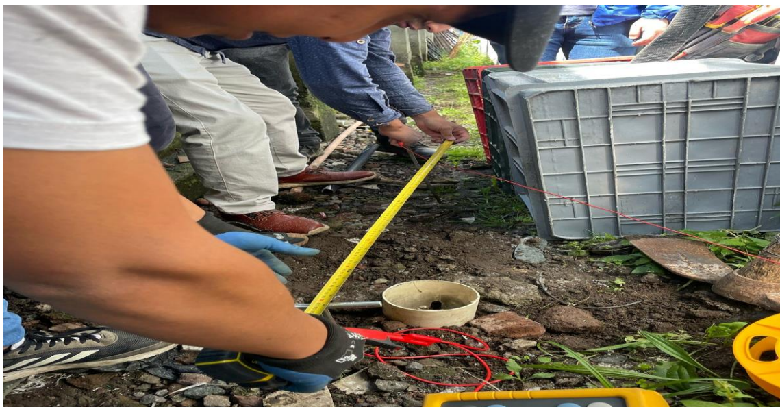
Figura 42.- Valor obtenido en el telurómetro de la resistividad del suelo a 1 metro. Fuente: Propia
