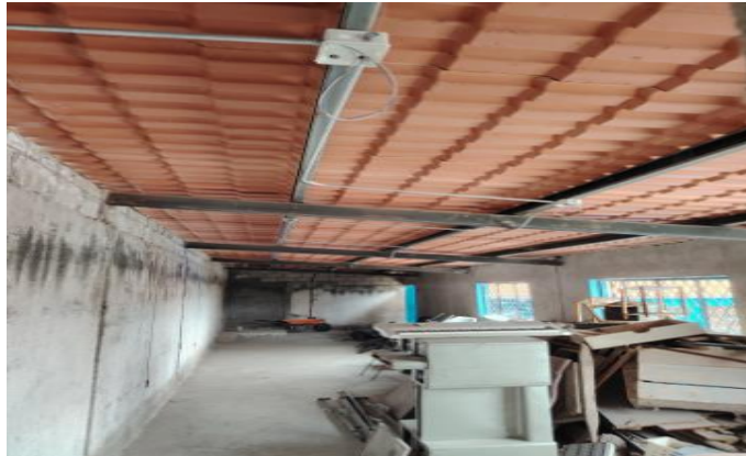
Figura 33. Revisión de cableado para Iluminación. Información tomada de Andagana. E. (2025) Elaboración propia. Quito.
