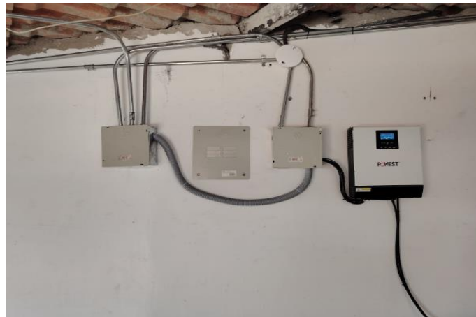
Figura 36. Verificación de centros de carga. Información tomada de Andagana. E. (2025) Elaboración propia. Quito
