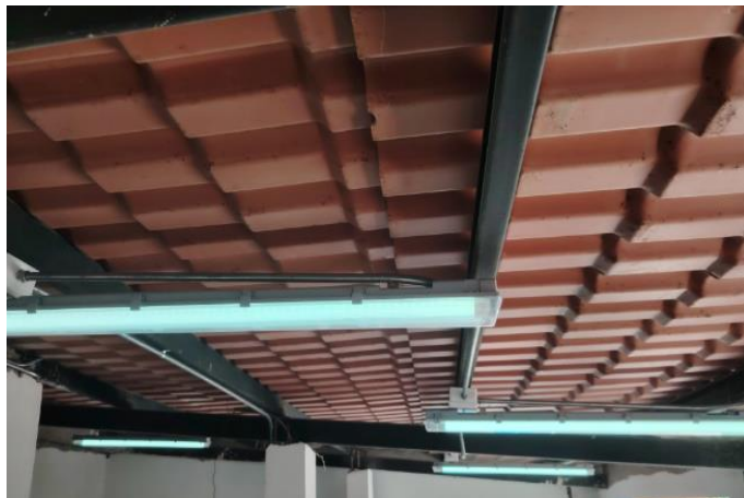
Figura 38. Adecuado funcionamiento de las luminarias. Información tomada de Andagana, E. (2025) Elaboración propia. Quito
