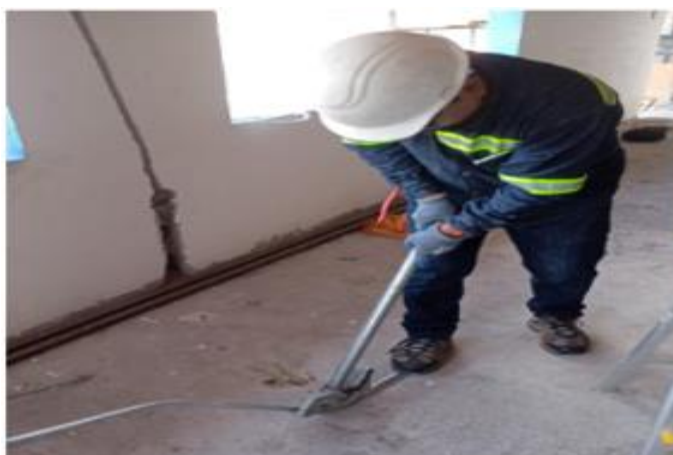
Figura 26. Dobles de tubería para el sistema eléctrico Información tomada de Andagana. E. & Oña. J. (2025). Elaboración propia. Quito.
