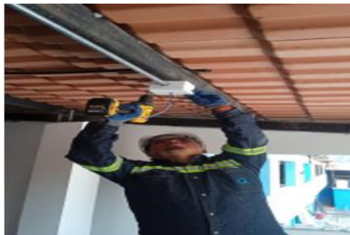
Figura 28. Instalación de cajetines para el sistema eléctrico Información tomada de Andagana, E. & Oña, J. (2025). Elaboración propia. Quito.
