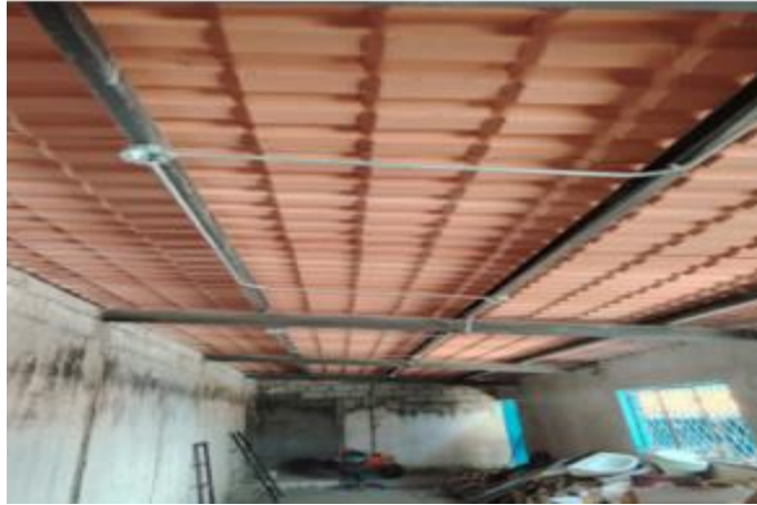
Figura 27. Instalación de tubería para el sistema eléctrico Información tomada de Andagana, E. & Oña, J. (2025). Elaboración propia. Quito.
