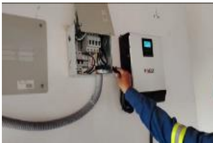
Figura 31. Colocación del centro de carga. Información tomada de Andagana, E. & Oña, J. (2025). Elaboración propia. Quito.
