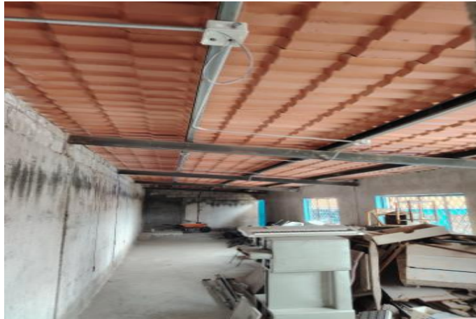
Figura 29. Instalación del cable eléctrico. Información tomada de Andagana. E. & Oña. J. (2025). Elaboración propia. Quito.
