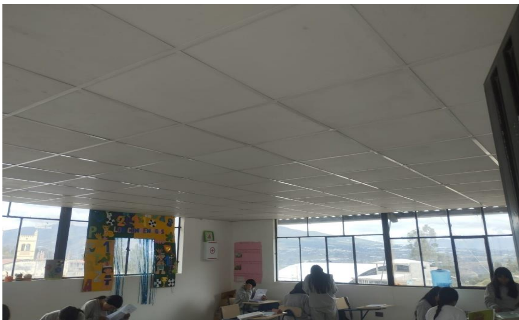
Figura 3.79. Instalación lámparas aula 7
