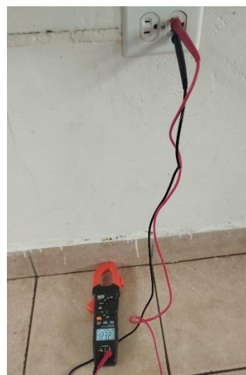
Figura 4.15. medición de voltaje con pinza amperimétrica 123 VAC
