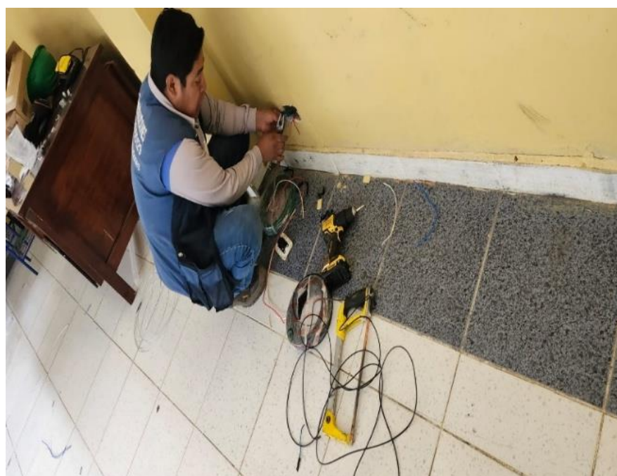
Figura 3.50. Instalación de nuevos tomas aula 1
