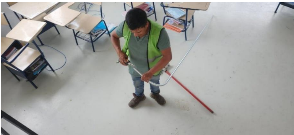
Figura 3.80. Doblado de tubería para luminaria aula 7
