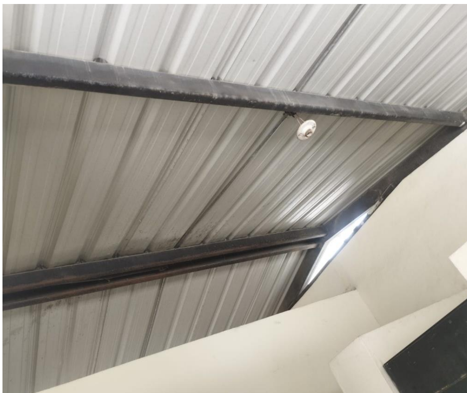
Figura 3.88. Antes de la instalación baños
