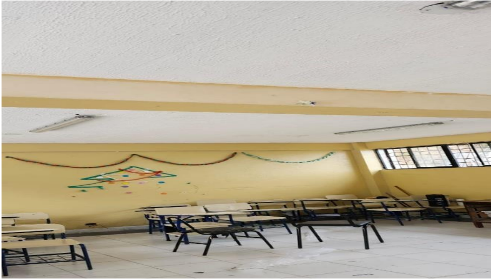
Figura 3.58. Cambio luminarias aula 3
