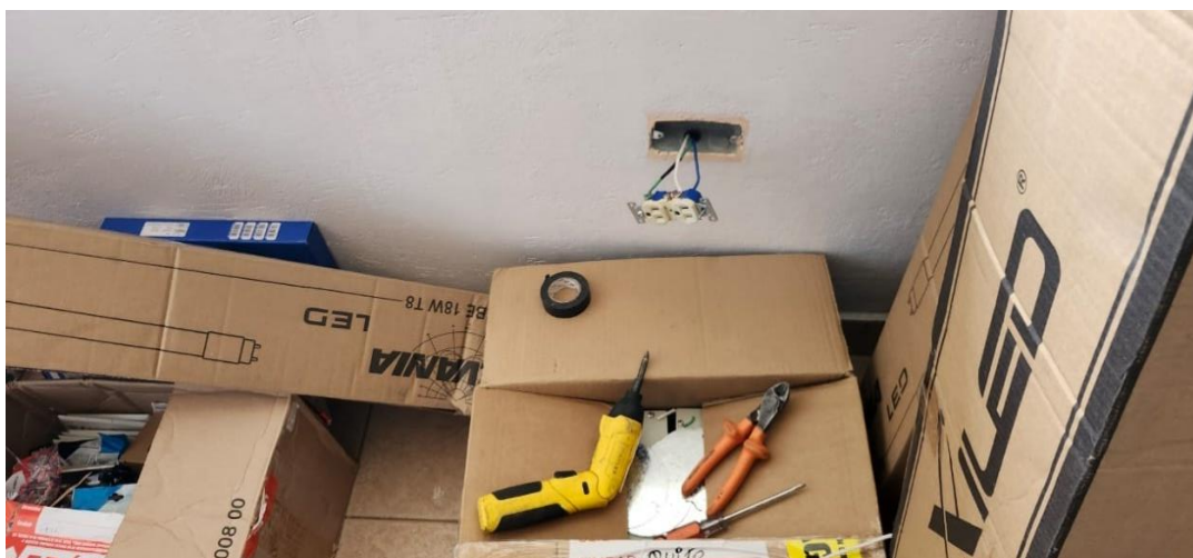
Figura 3.65. Instalación de tomacorrientes aula 4
