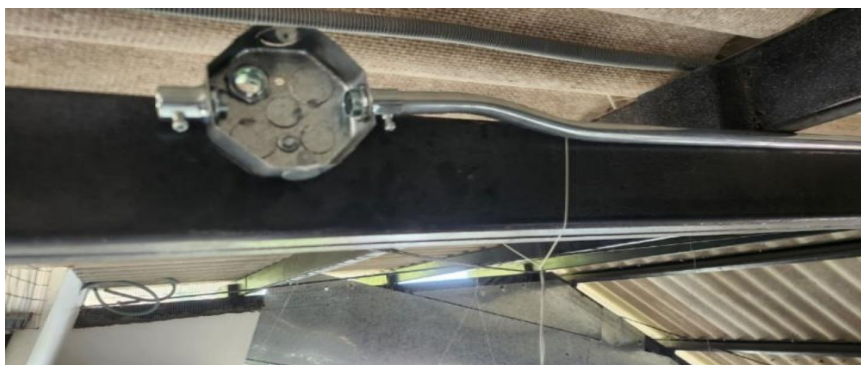
Figura 3.81. Doblado de tubería para luminaria aula 7
