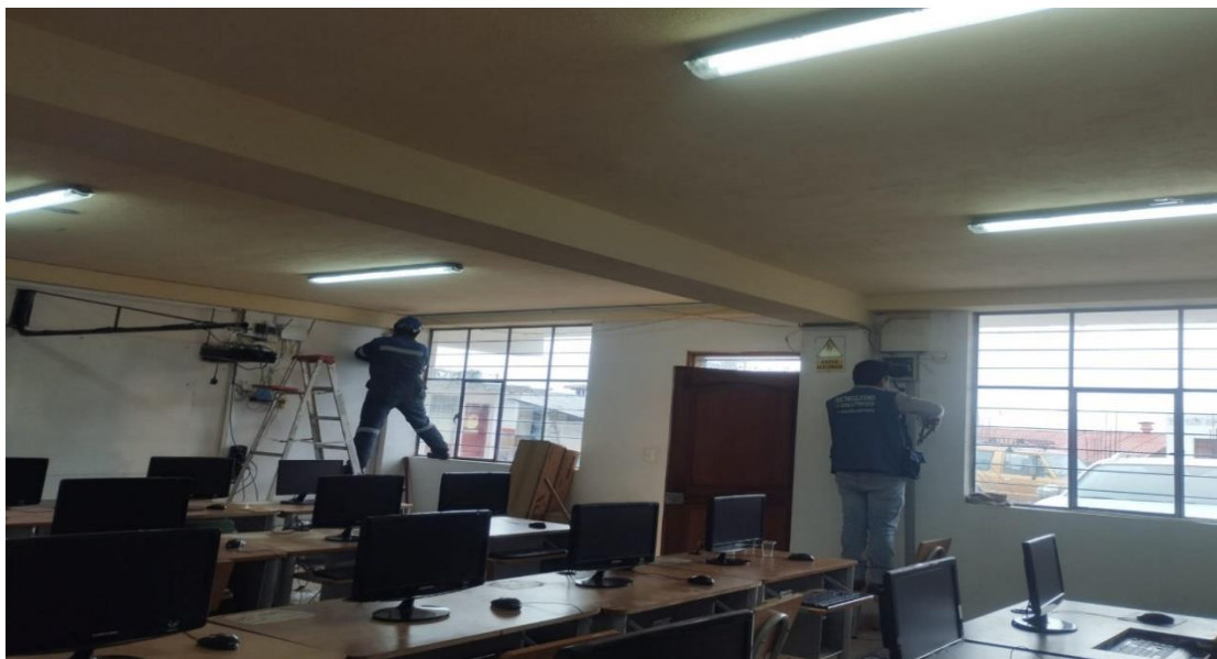
Figura 3.72. Instalación de luminarias Centro de computo
