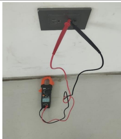
Figura 4.31. Medición de voltaje con pinza amperimétrica en puntos de fuerza Fuente: propia
