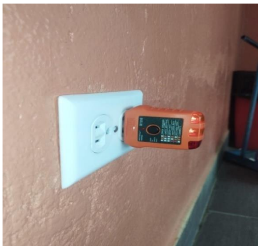
Figura 4.22. comprobación de puntos de fuerza
