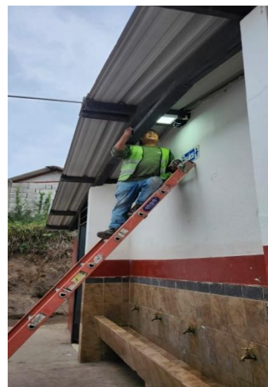
Figura 3.92. Instalación luminarias baños
