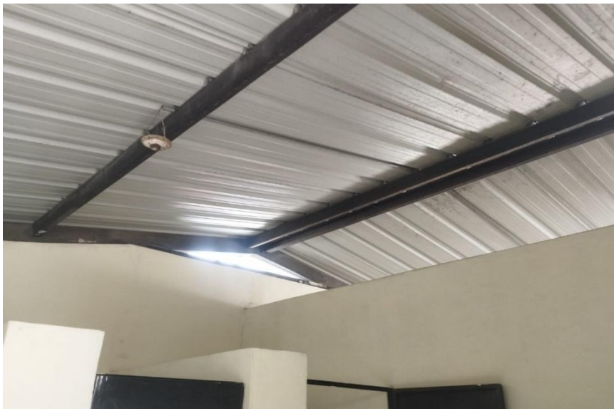
Figura 3.87. Antes de la implementación Baños
