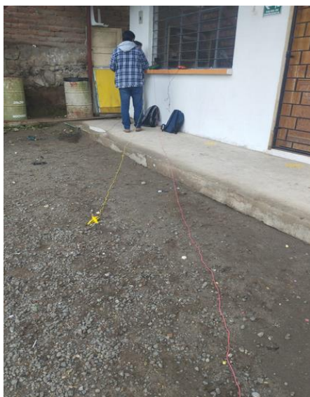
Figura 4.38. Instalación de picas
