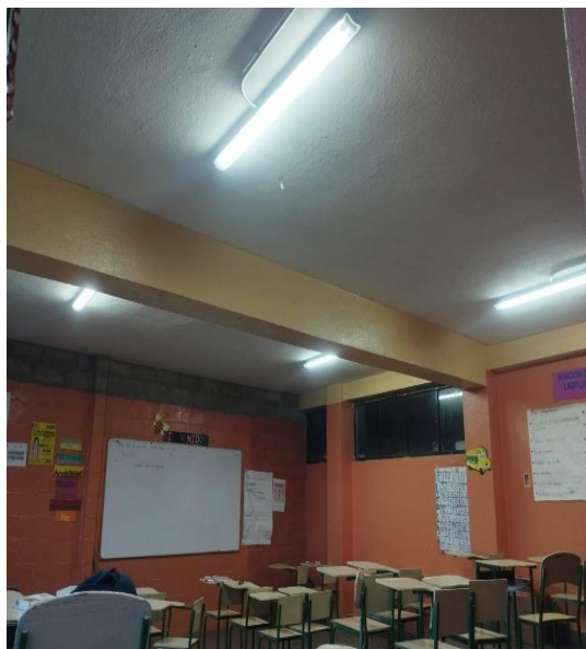
Figura 3.77. Instalación lámparas aula 6
