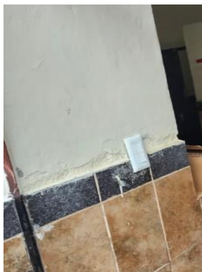
Figura 3.94. Instalación interruptor baño
