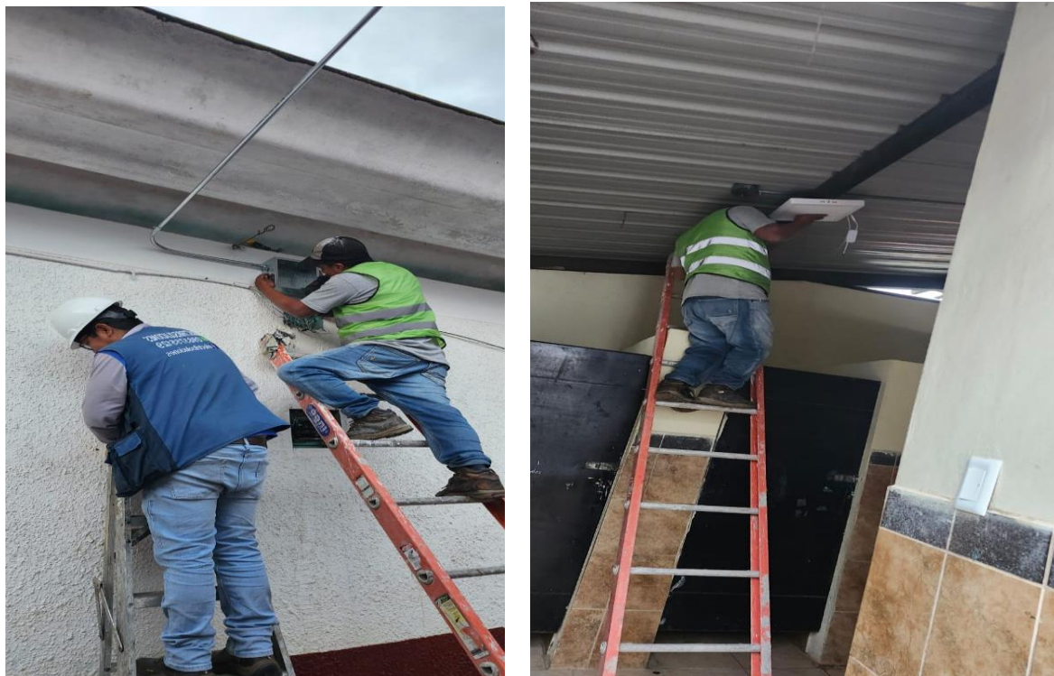
Figura 3.89. Instalación luminarias baños
