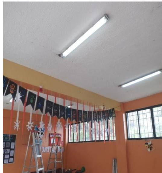
Figura 3.56. Instalación Luminarias aula 2
