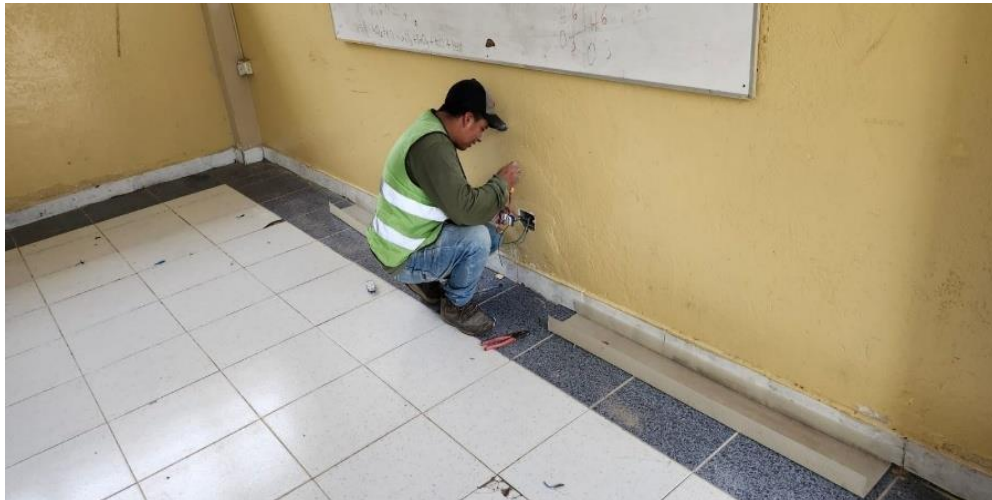
Figura 3.59. Cambio Tomacorrientes aula 3
