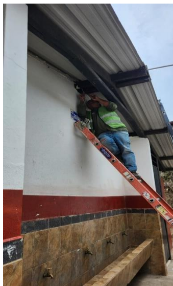
Figura 3.91. Instalación acometida baños
