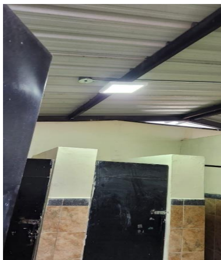
Figura 3.93. Instalación luminarias baños
