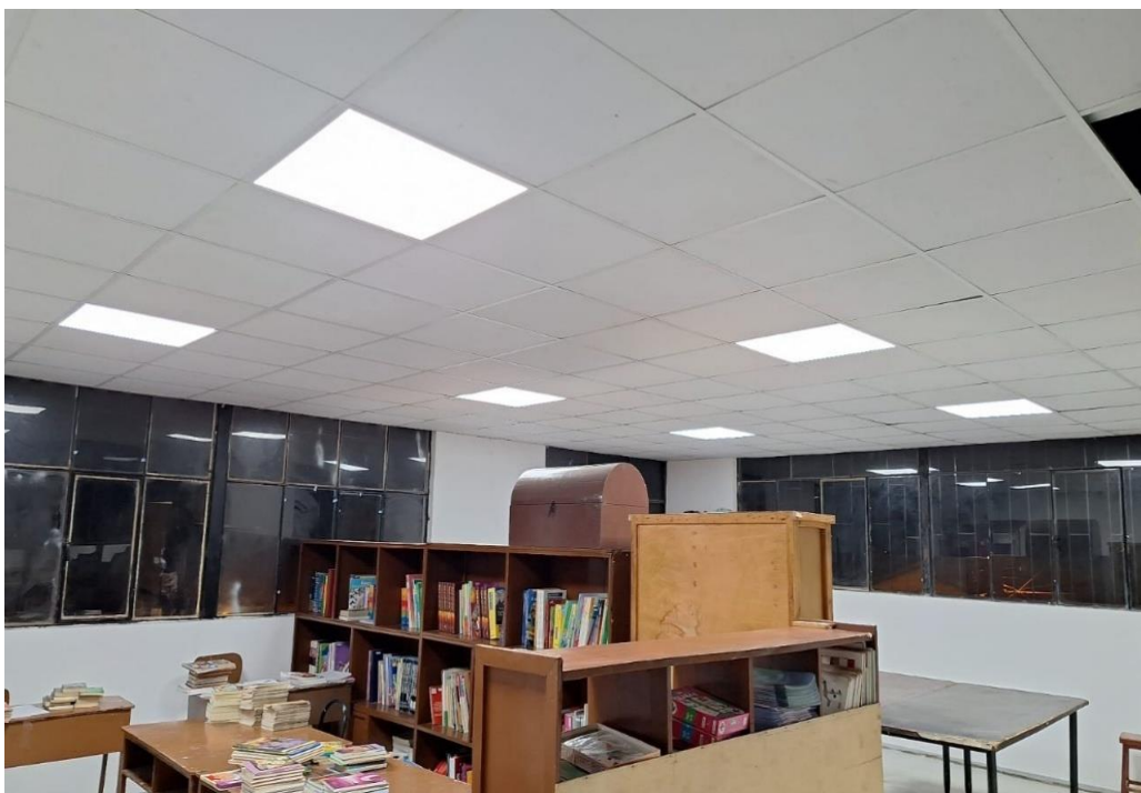
Figura 3.86. Instalación de luminarias aula 8
