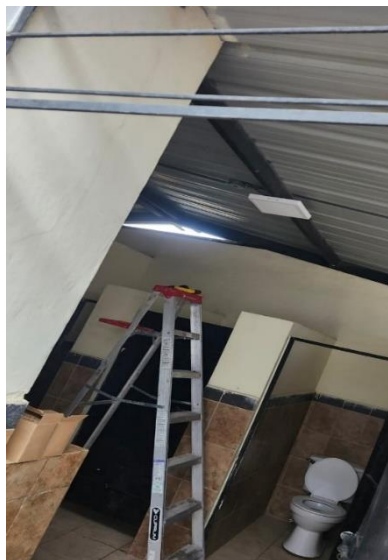
Figura 3.90. Instalación luminarias baños
