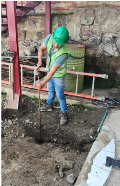
Figura 3.95. Instalación varilla cooperwell
