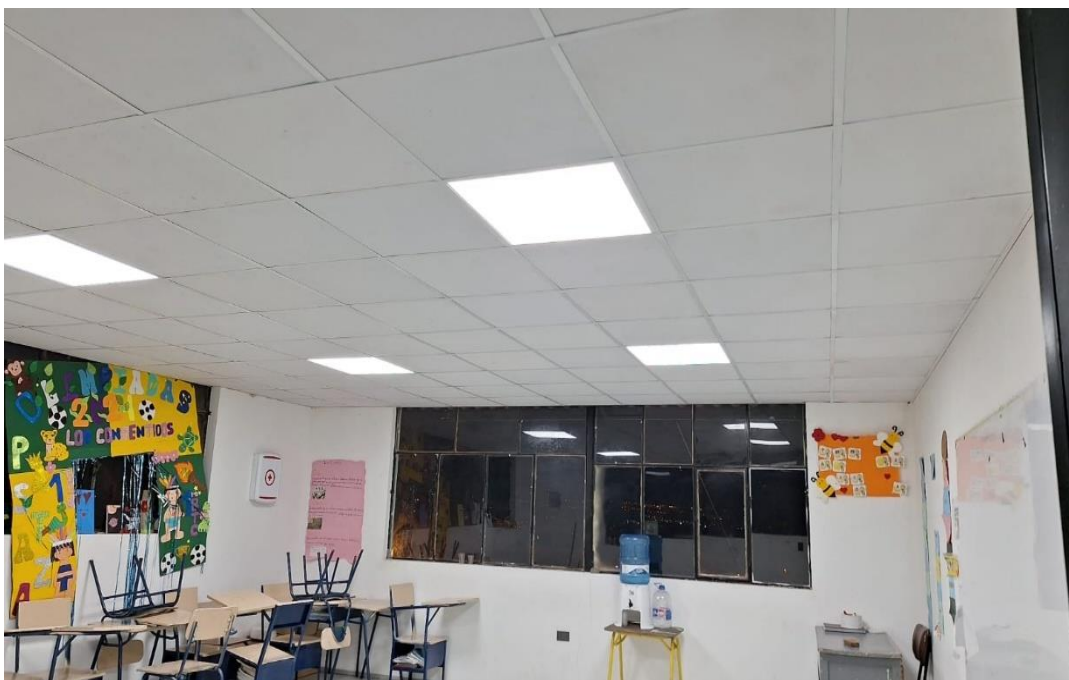
Figura 3.83. Instalación luminaria aula 7
