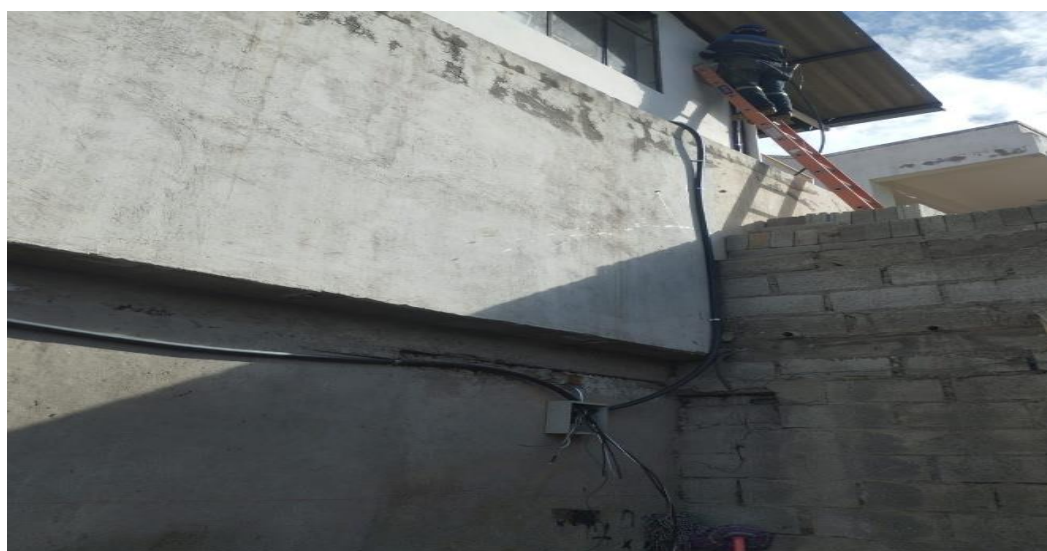
Figura 3.76. Instalación nueva acometida aula 6
