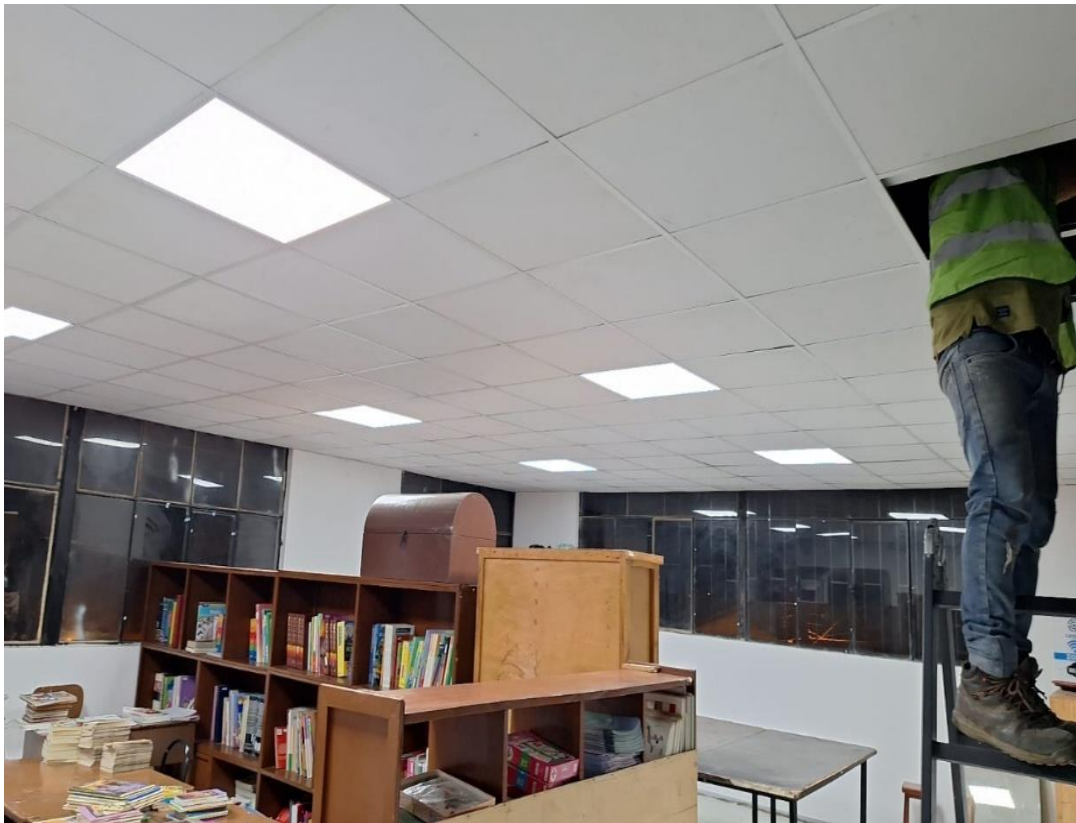
Figura 3.85. Instalación de luminarias aula 8
