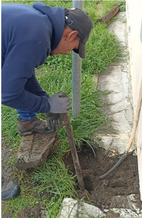
Figura 18 Inspección del suelo
