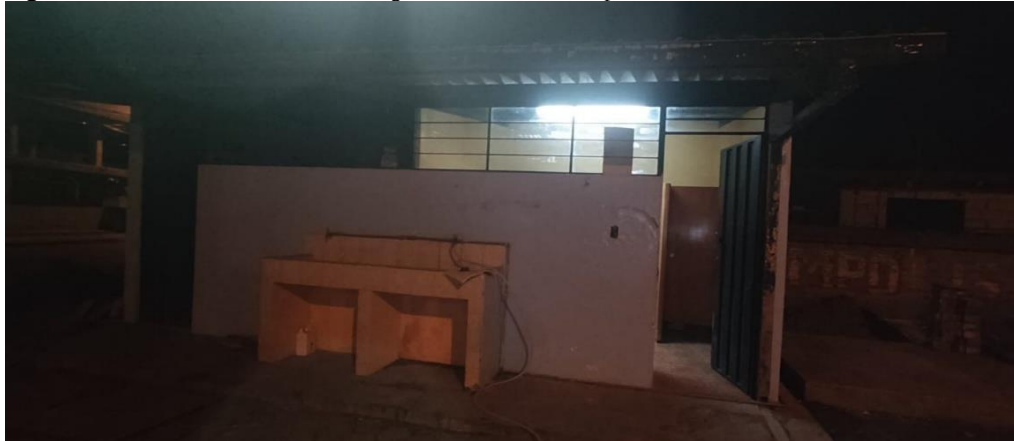
Figura 6 Iluminación en los servicios higiénicos antes de la implementación.
