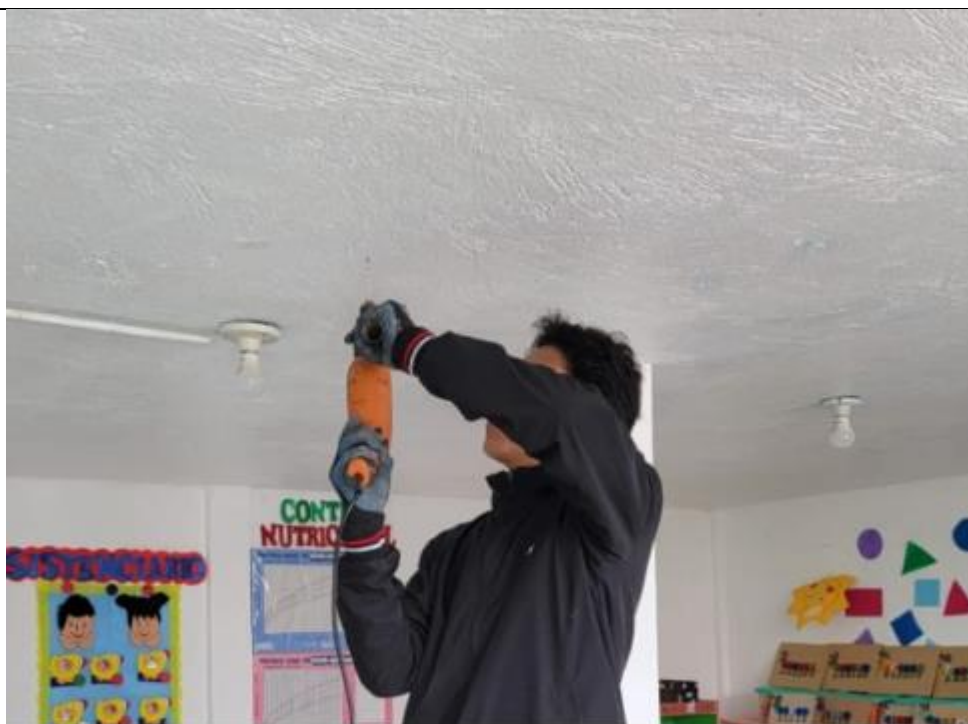
Figura 12.9 Señalización de donde van la ubicación de las nuevas luminarias
