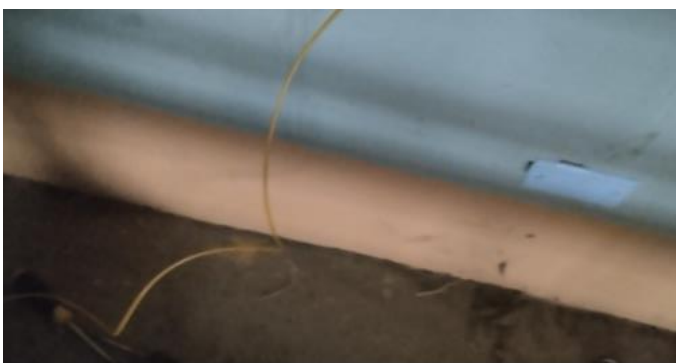
Figura 13.7 instalacion de la puesta a tierra
