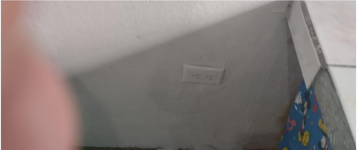
Figura 11.6 implementación del circuito de los tomacorrientes
