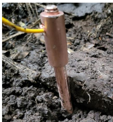
Figura 15.7 colocación del calibre al conector de golpe
