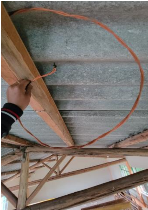
Figura 13.9 Se retiró el cableado de iluminarias
