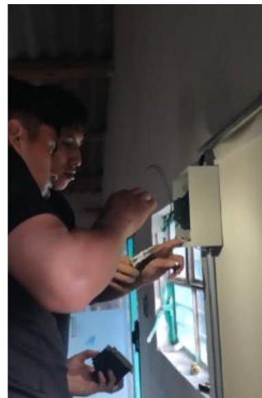
figura 14.3 Ubicación de la caja térmica
