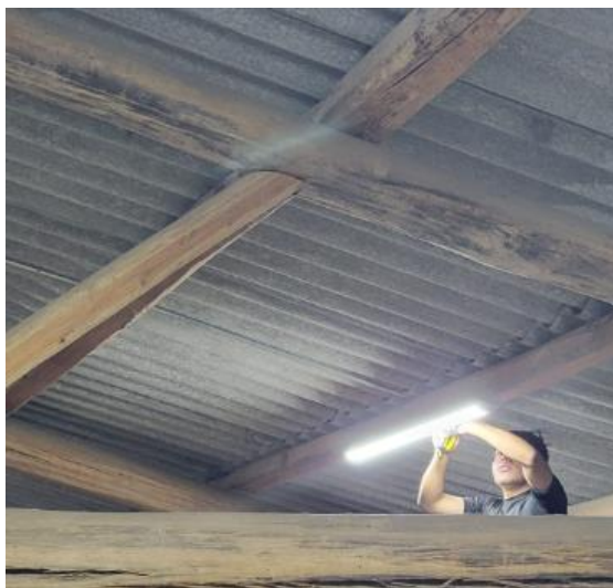
Figura 14.2 Colocación de las nuevas luminarias
