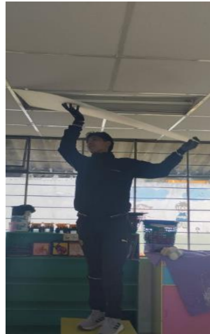
Figura 9.1 Revisión de luminarias
