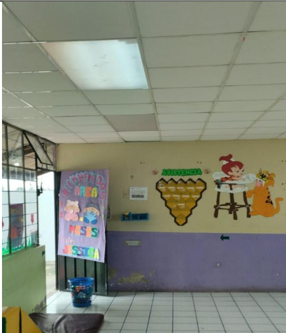
Figura 8.9 Inspección del aula 1
