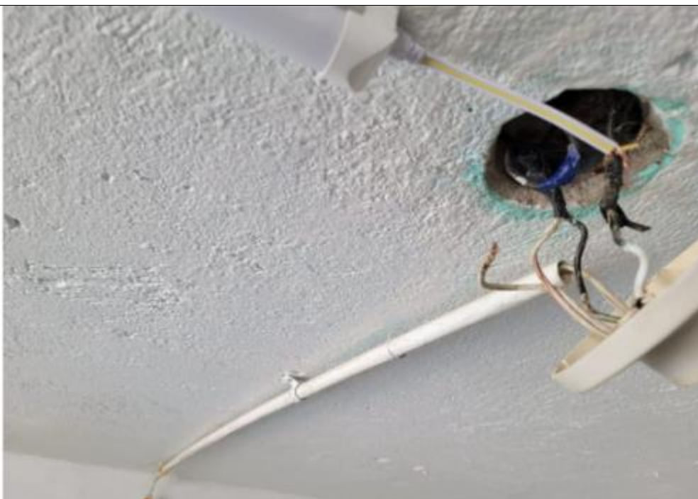
Figura 12.8 Separación del circuito de iluminación
