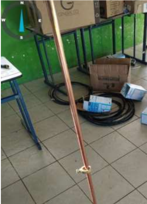
Figura 45 Varilla de tierra
