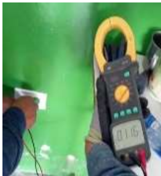
Figura 67 Prueba de voltaje en tomacorrientes
