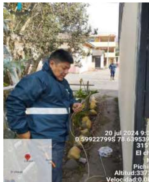
Figura 54 Cambio de acometidas
