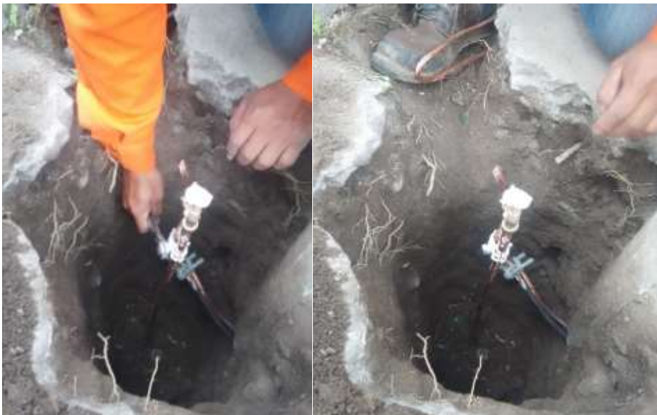
Figura 35 Instalación de varilla de tierra
