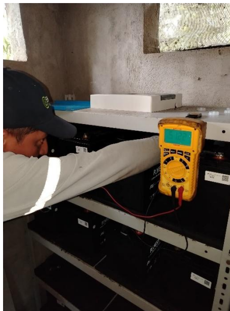
Figura 93: Prueba de tensión en banco de baterías
