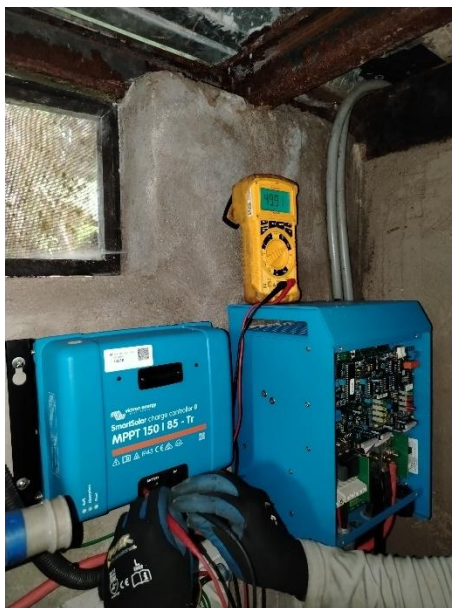
Figura 95: Prueba de tensión en controlador sección banco de baterías
