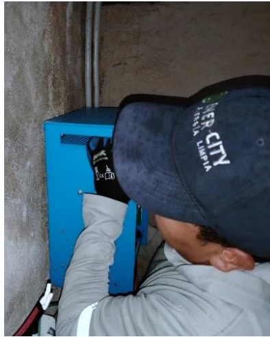
Figura 43: fijación del inversor
