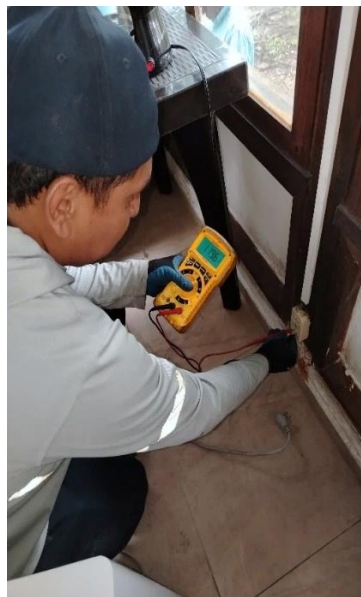
Figura 88: Prueba de voltaje en habitación 1
