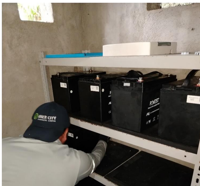
Figura 55: Colocación del cuarto y quinto ramal de baterías en serie
