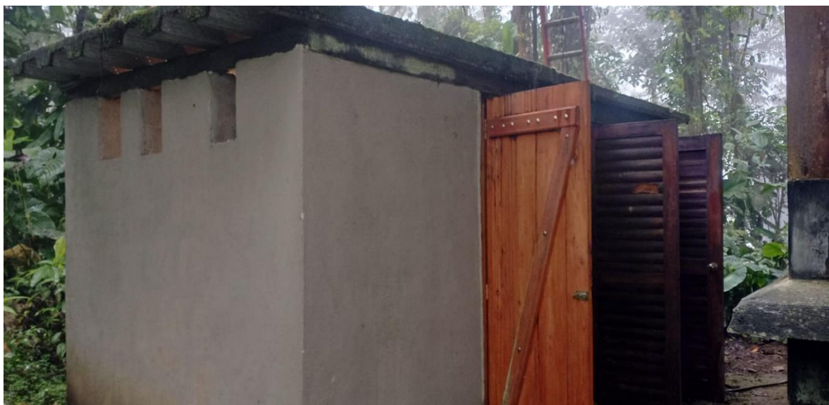
Figura 38: Cuarto de máquinas
