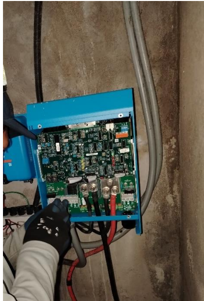
Figura 49: Conexión AC OUT
