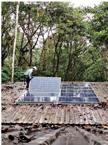
Figura 61: Colocación de paneles sobre estructura
