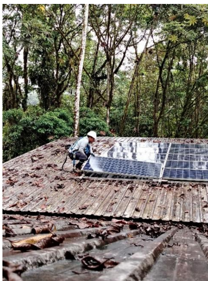
Figura 64: Colocación de paneles
