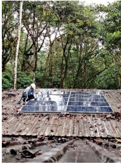
Figura 67: Fijación de anclaje end clamps
