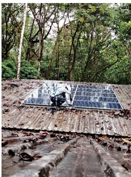
Figura 62: Sujeción de clamps
