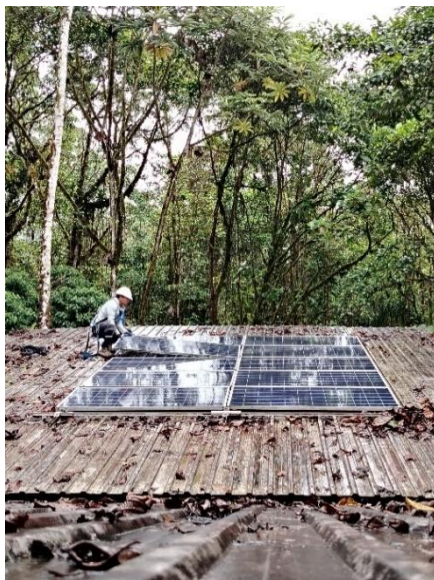
Figura 63: Colocación de paneles
