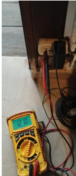
Figura 89: Prueba de tensión en habitación 3
