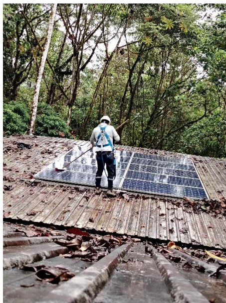
Figura 70: Limpieza de techo y paneles
