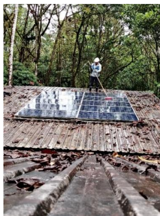
Figura 68: Limpieza de techo y paneles
