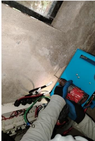
Figura 45: Perforación para fijar controlador de carga
