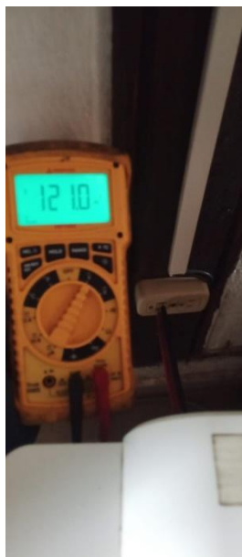
Figura 92: Prueba de tensión en habitación 2
