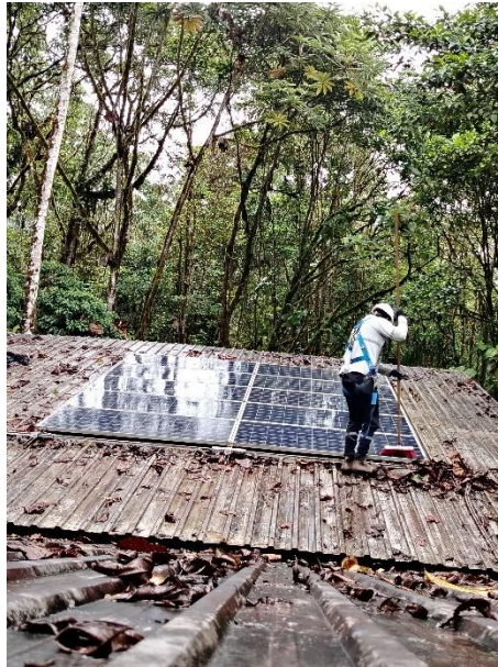
Figura 69: Limpieza de techo y paneles
