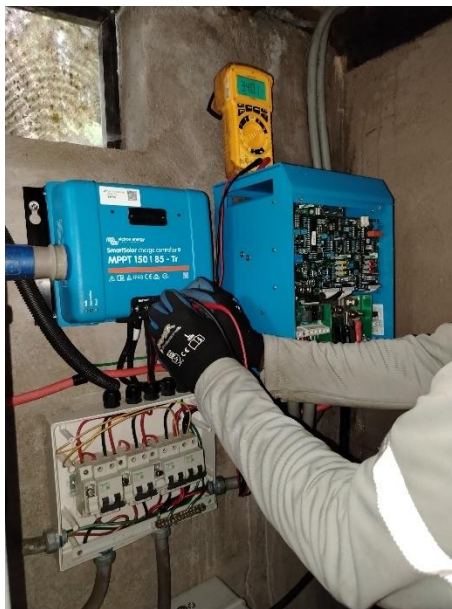
Figura 94: Prueba de tensión en controlador sección paneles
