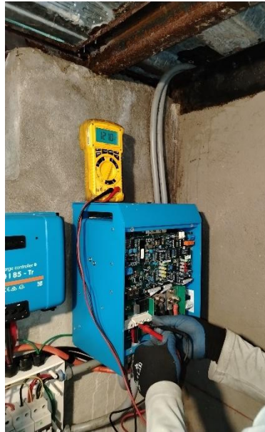
Figura 97: Prueba de tensión en inversor AC OUT
