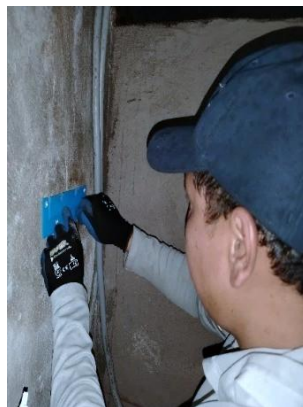
Figura 42: Anclaje de soporte de inversor
