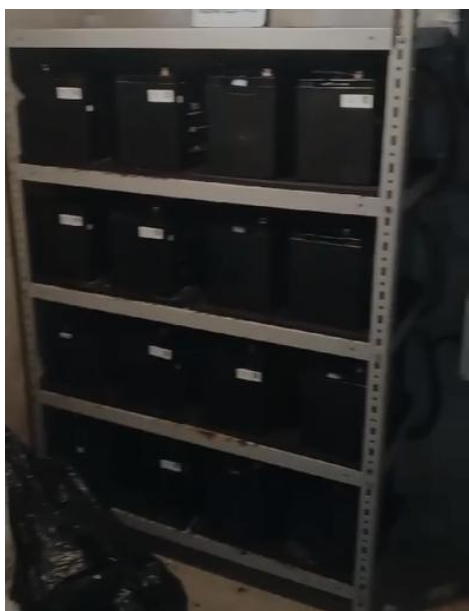
Figura 103: Banco de baterías implementado
