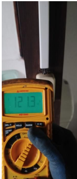
Figura 90: Prueba de tensión en baño 1
