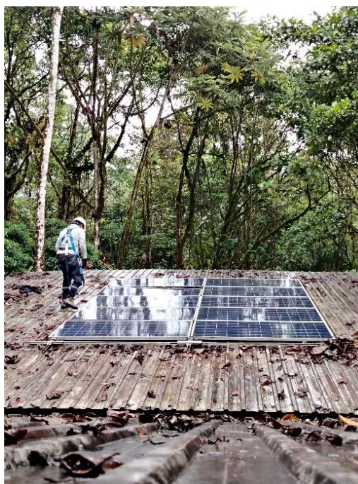
Figura 66: Fijación de anclaje end clamps
