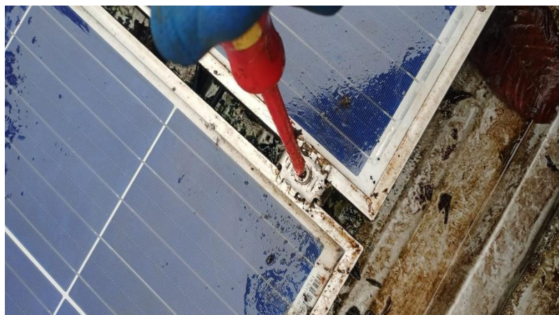
Figura 65: Sujeción de middle clamps
