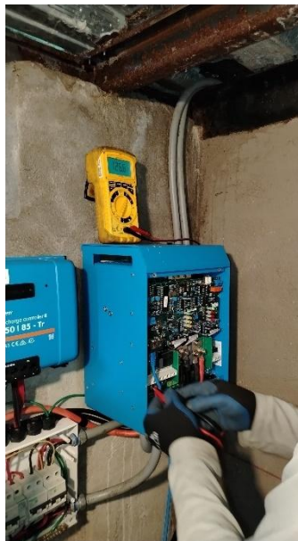
Figura 96: Prueba de tensión en inversor AC IN
