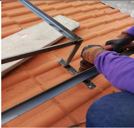
Figura 36 Montaje de la estructura Autor: Propia
