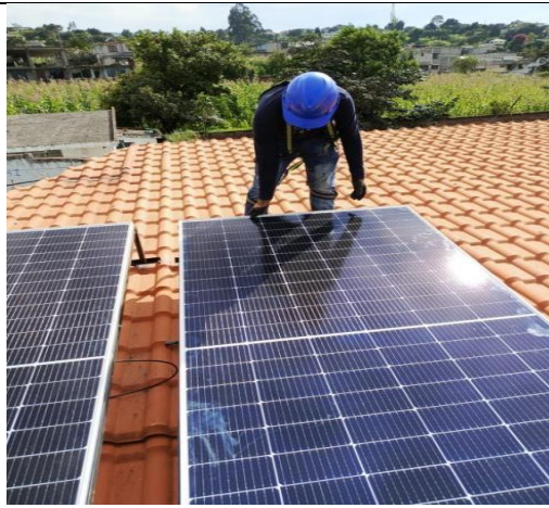
Figura 40 Colocacion de paneles Autor: Propia
