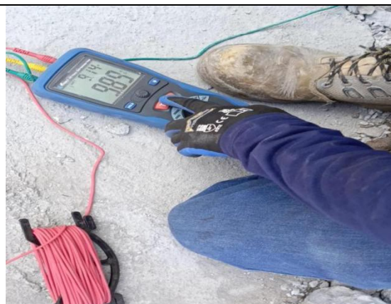
Figura 29 Medición de resistencia a 2 metro Autor: Propia
