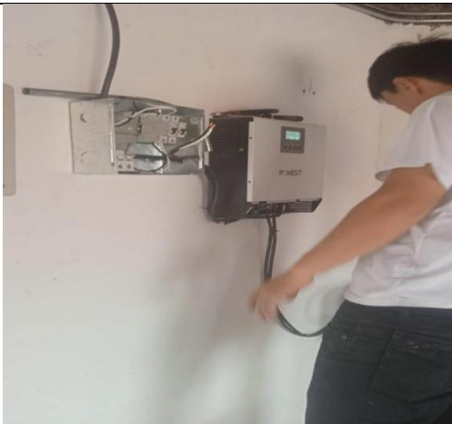
Figura 51 Armado del tablero de control Autor: Propia
