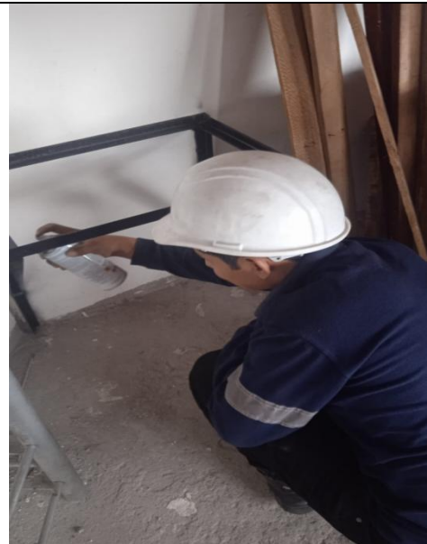
Figura 46 base de baterías Autor: Propia
