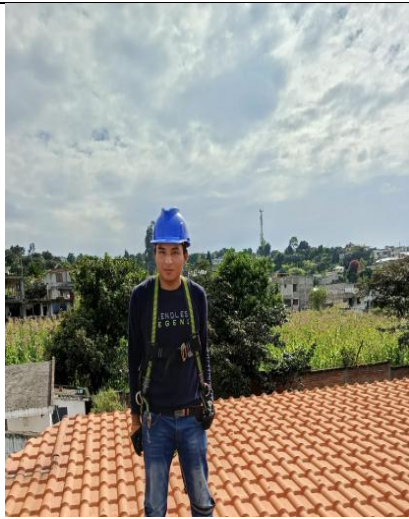
Figura 38 Evidencia de seguridad Autor: Propia
