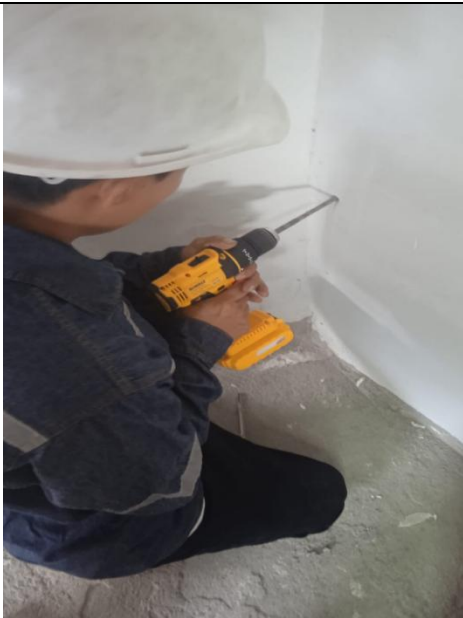
Figura 45 Base para las baterías Autor: Propia
