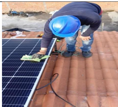
Figura 42 Limpieza de paneles Autor: Propia
