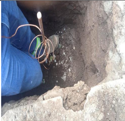
Figura 31 Colocacion de la varilla copperweld Autor: Propia
