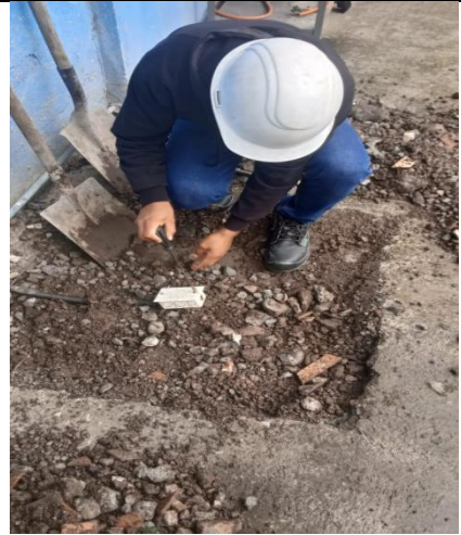
Figura 34 colocacion de una caja para volver a fundir Autor: Propia
