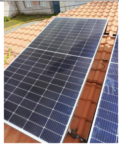
Figura 41 colocacion de paneles Autor: Propia
