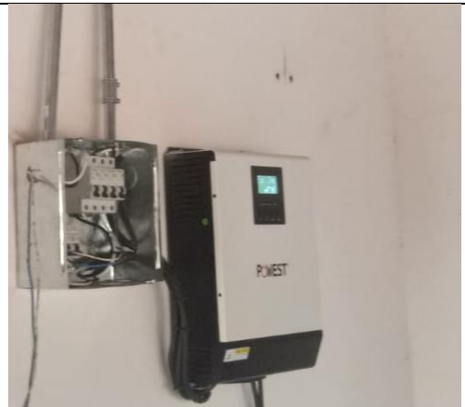
Figura 52 Armado del tablero de control Autor: Propia
