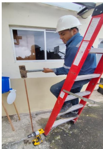
Figura 31: Instalación de Puesta a tierra
