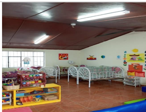
Figura 21: Instalación de tubos led en el área de cuneros.
