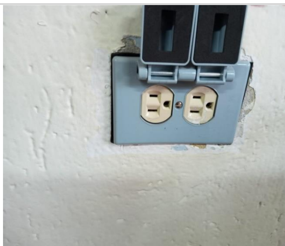
Figura 23: Instalación de protección en tomacorrientes.
