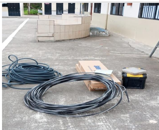
Figura 18: Materiales y herramientas para la instalación.
