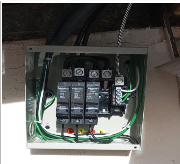
Figura 24: Nueva instalación de centro de carga.
