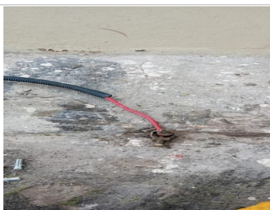
Figura 27: Instalación de puesta a tierra.
