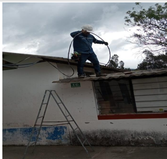
Figura 25: Instalación de acometida.
