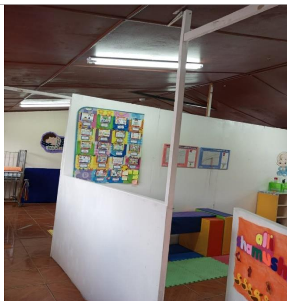
Figura 29: Instalación de luminarias en aulas.
