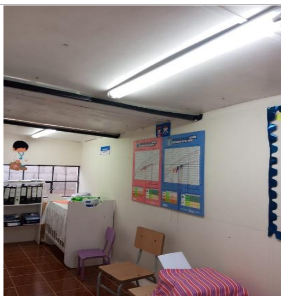
Figura 28: Instalación de luminarias del CDI.
