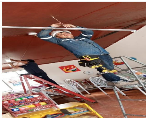
Figura 20: Instalación de tubos led en las aulas.
