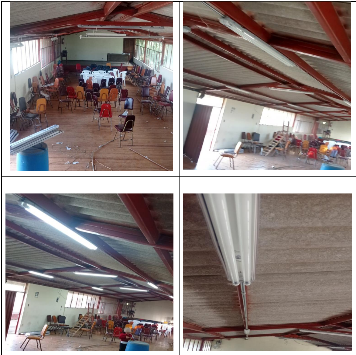
Fig. 48 implementación de luminarias
