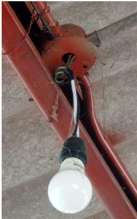
Fig. 22 boquillas eléctricas
