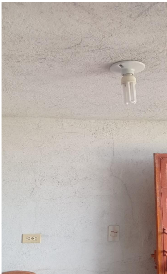
Fig. 30 iluminación de sala de locución
