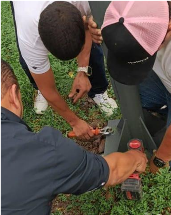
Figura 27. Instalación de postes metálicos
