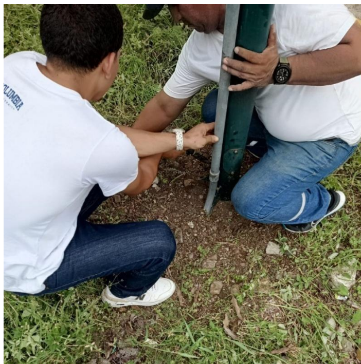
Figura 24. Colocación de tubo galvanizado
