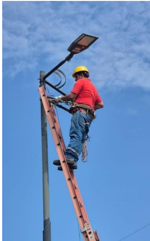
Figura 32. Colocación de lámparas en poste 4
