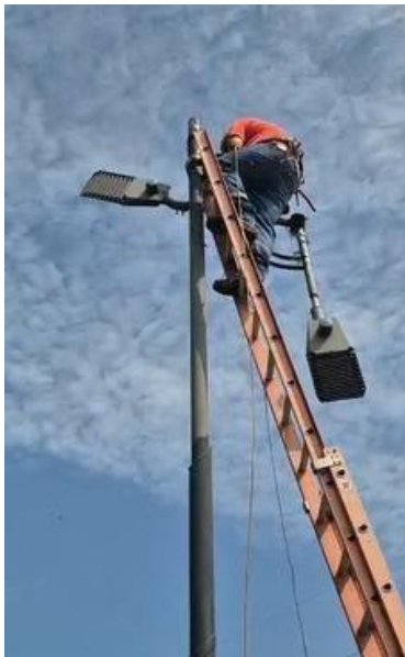
Figura 29. Colocación de lámparas en poste 1
