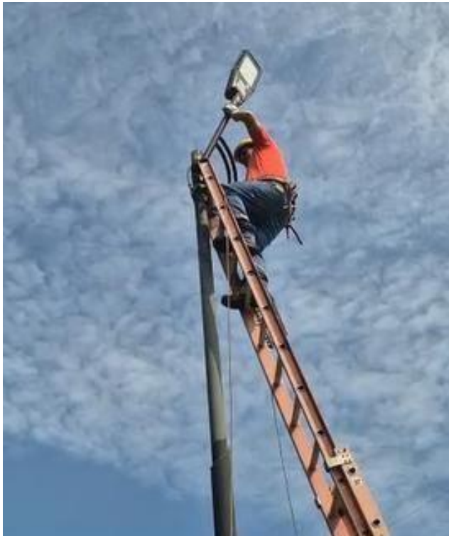
Figura 31. Colocación de lámparas en poste 3
