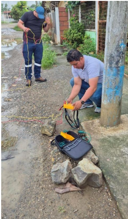
Figura 20. Prueba con telurómetro
