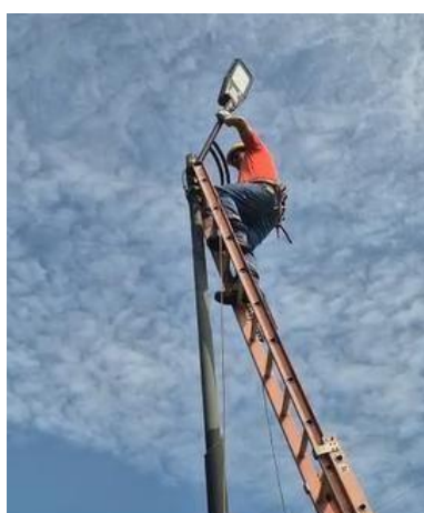
Instalación de lamparas en los postes
