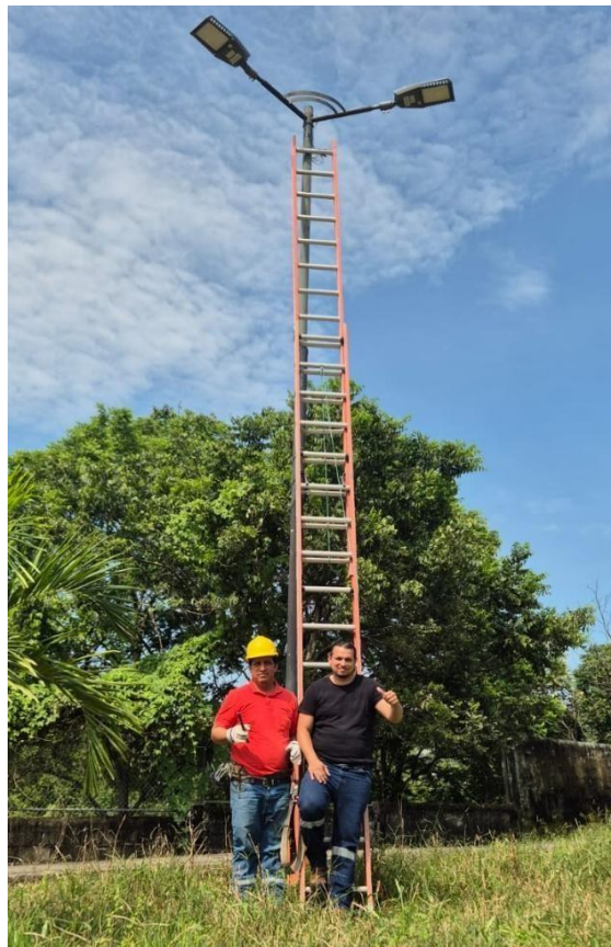
Figura 33. Colocación de lámparas en poste 5
