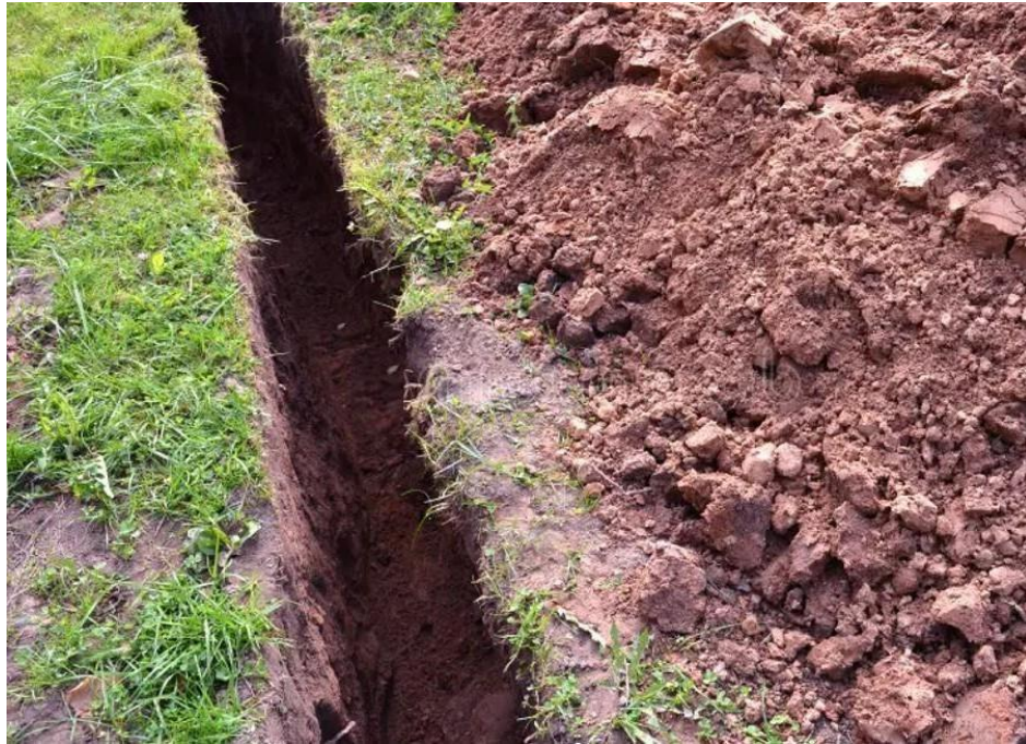
Figura 23. Por estética se realiza zanja para dejar soterrado el circuito eléctrico
