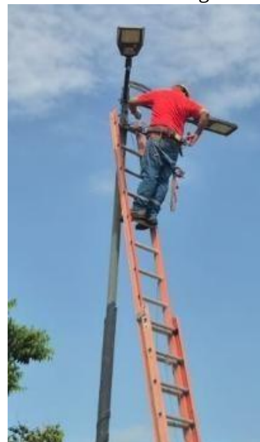
Figura 30. Colocación de lámparas en poste 2
