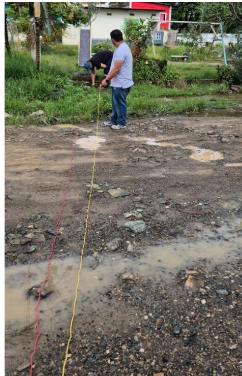
Figura 21. Prueba con telurómetro
