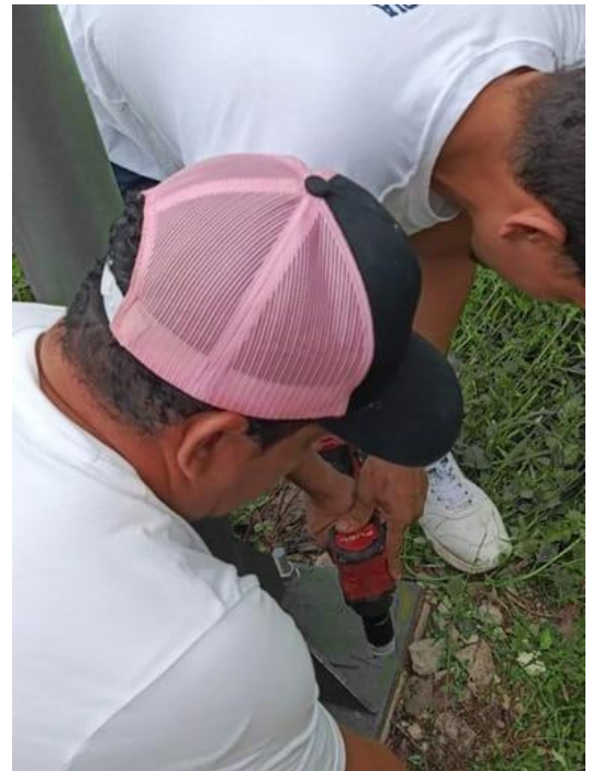
Figura 28. Instalación de postes
