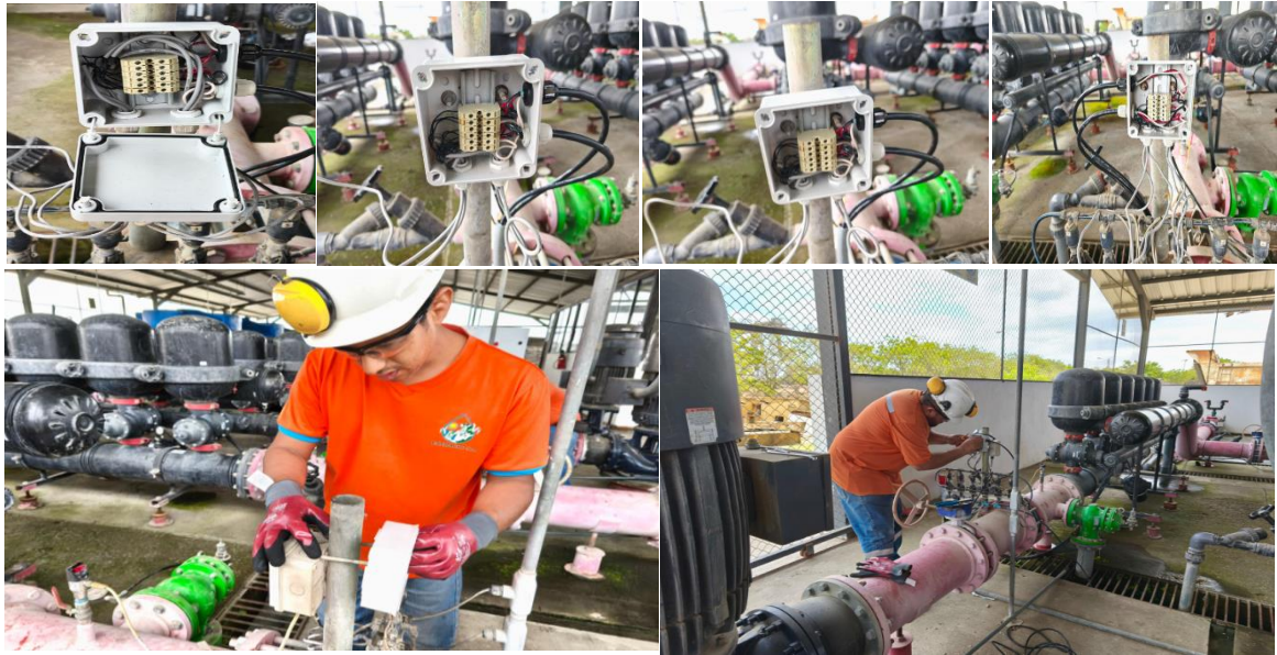
Figura 29: montaje de cajas de conexiones de solenoides
