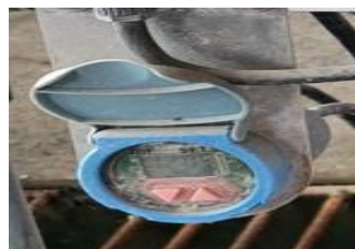
Figura 10: Interruptor de presión diferencial Baccara
