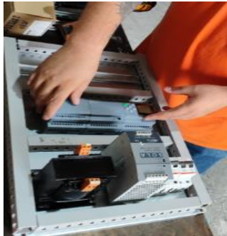
Figura 25: construcción del tablero
