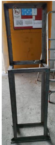
Figura 24: Base del tablero
