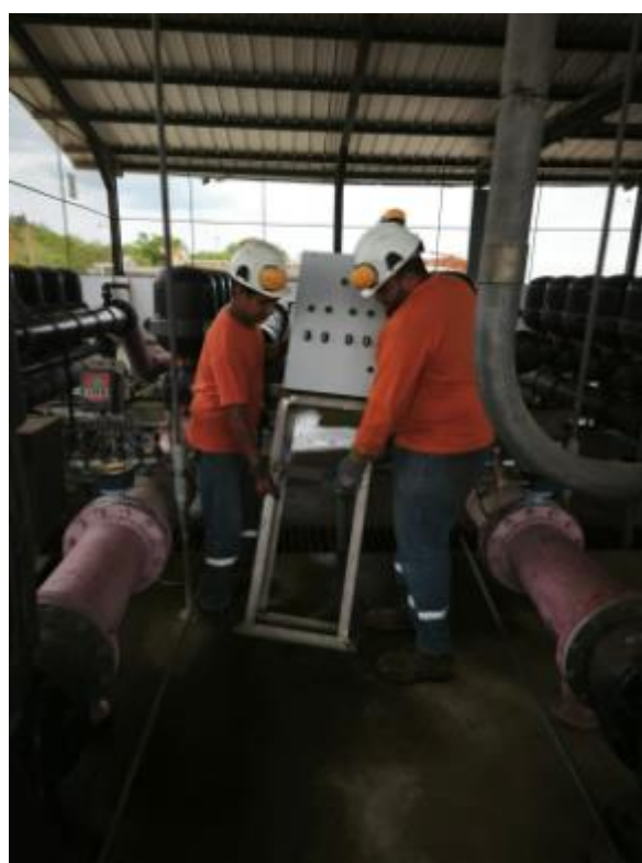
Montaje de tablero en el sitio donde va a ir ubicado
