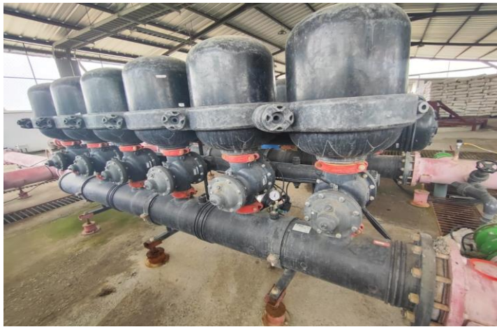
Figura 1: Baterías de filtrados ARKAL de anillas
