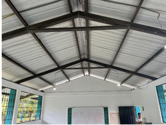
Figura 18. Aulas con boquillas colgantes Fuente: Autoría propia.
