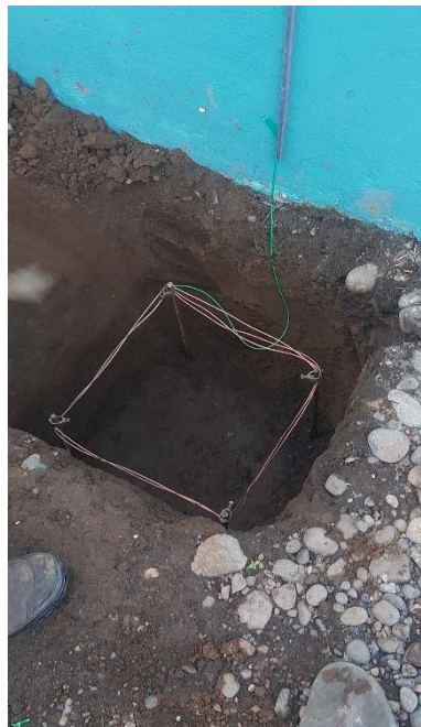
Figura 57. Realización de maya. Fuente: Fotografía propia
