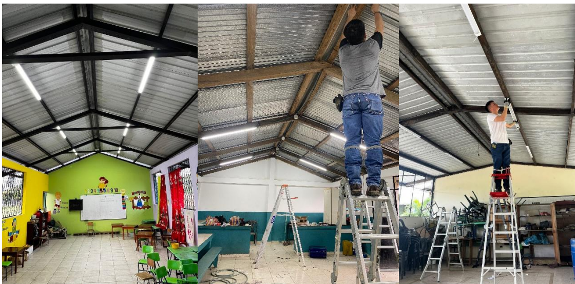
Figura 53. Luminarias actuales. Fuente: Fotografías propia.
