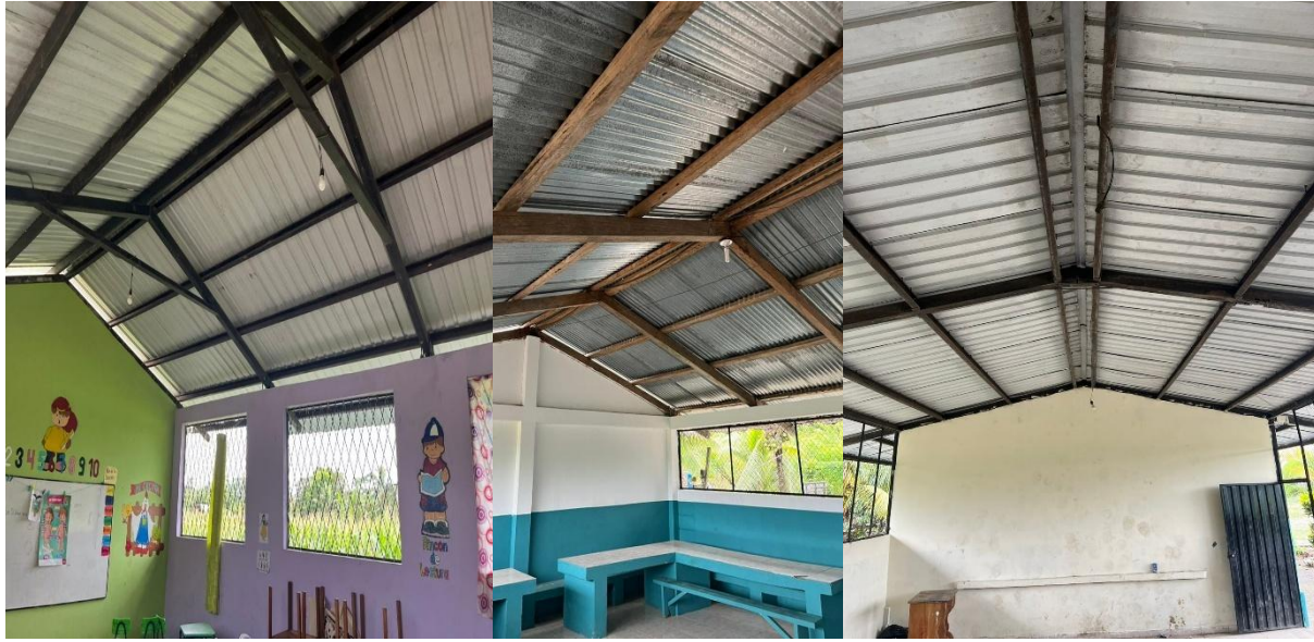
Figura 52. Luminaria inicial. Fuente: Fotografías propia.
