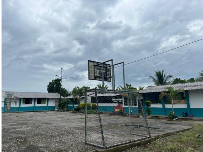
Figura 54. Luminaria del área recreativa Inicial. Fuente: Fotografía propia
