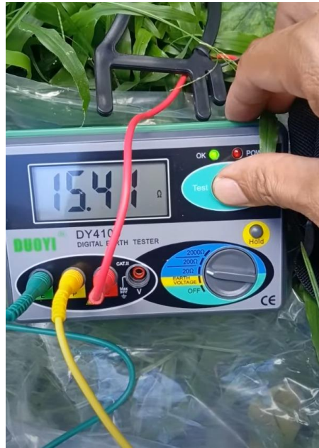
Figura 40. Medición con el telurómetro Fuente: fotografía propia.
