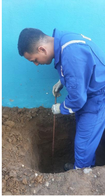
Figura 56. Instalación de las varillas Copperweld Fuente: Fotografía propia
