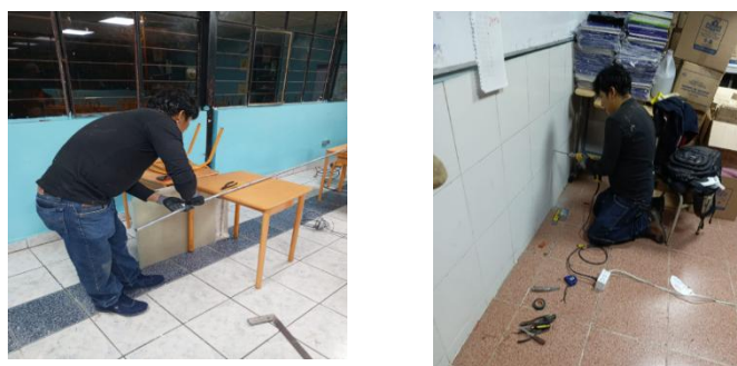
Figura 18. Medición de tubería cortado y doblado
