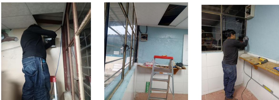
Figura 20. Instalación de tableros secundarios Fuente: Propia
