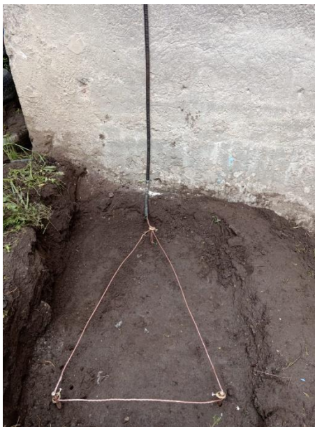
Figura 86. Realización de la puesta a tierra con sus materiales.
