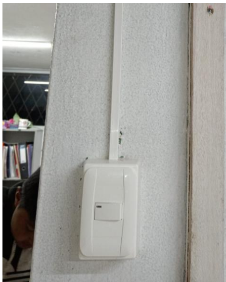
Figura 85. Interruptores después de la intervención
