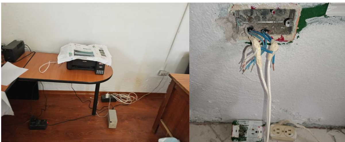
Figura 82. Tomacorrientes antes de la intervención. Fuente: Fotografía propia.
