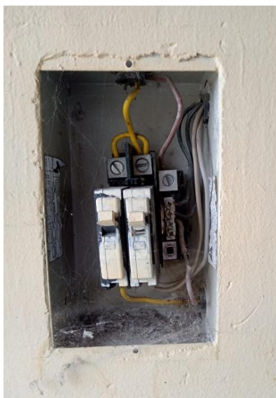
Figura 78. Tablero secundario antes de la intervención. Fuente: Fotografía propia.
