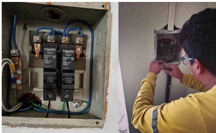
Figura 77. Tablero de 4 puntos después de la intervención. Fuente: Fotografía propia.
