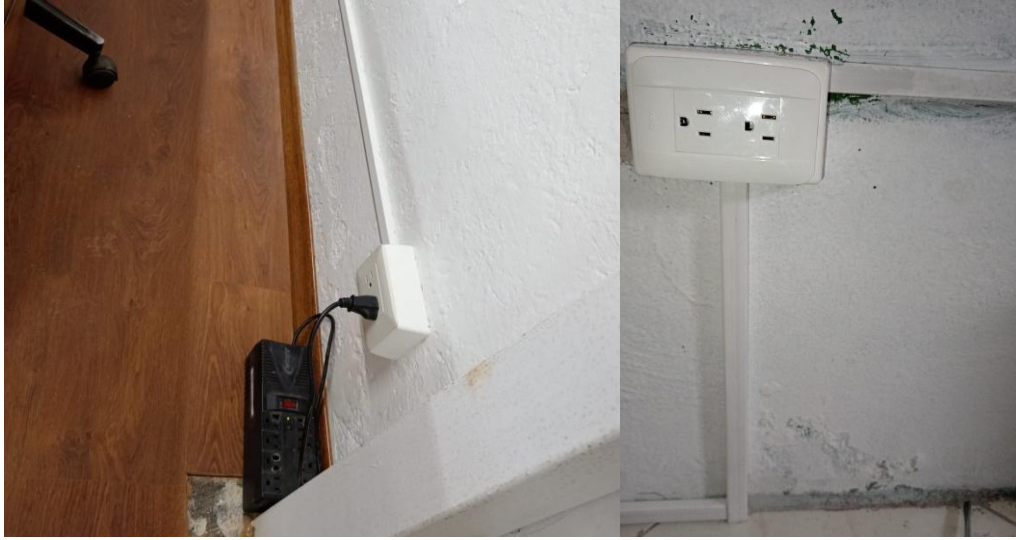
Figura 83. Tomacorrientes después de la intervención. Fuente: Fotografía propia.
