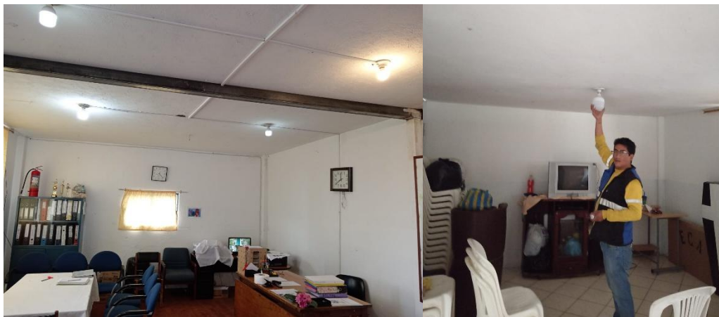
Figura 80. Luminarias antes de la intervención Fuente: Fotografía propia.
