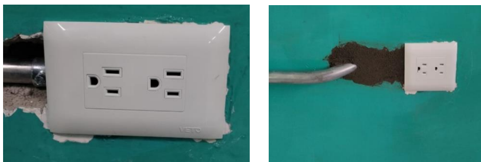
figura 30. Adaptación de la tubería conduit en las aulas del 2do básica al 7mo básica
