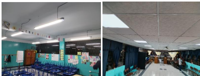
figura 39. Colocación de las nuevas luminarias con los lúmenes requeridos
