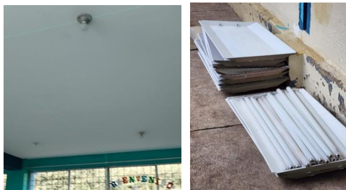
figura 38. Retiro de las luminarias antiguas
