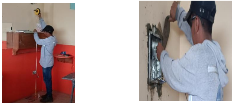
Figura 50. Instalación del nuevo subtablero TS4.
