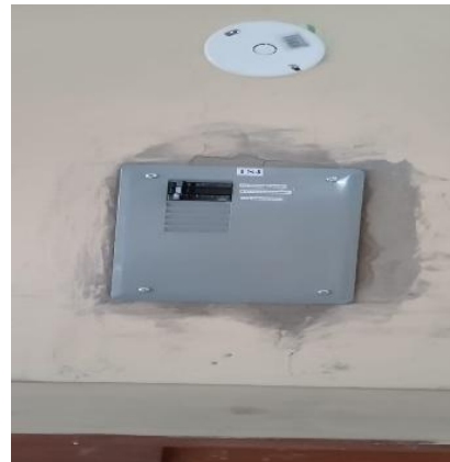
Figura 58. Tablero secundario nuevo TS4
