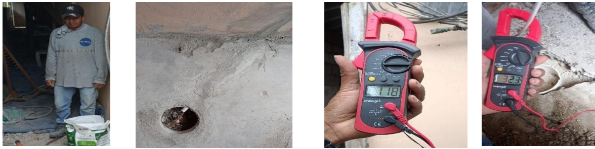
Figura 64. Puesta a tierra actual
