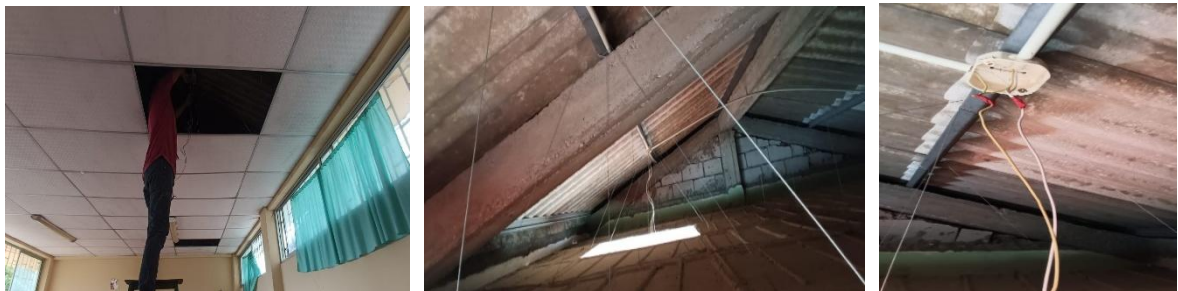
Figura 41. Desmontaje de luminarias y conductores planta alta.
