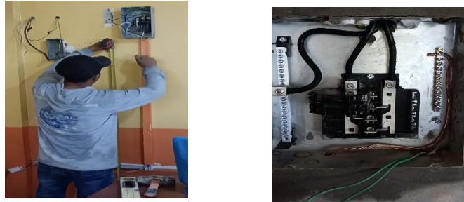
Figura 48. Instalación del nuevo tablero principal
