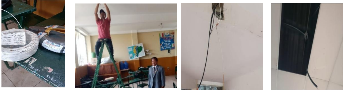
Figura 42. Instalación del nuevo sistema de iluminación
