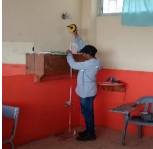
Figura 57. Fotografía de medición para el tablero TS4.
