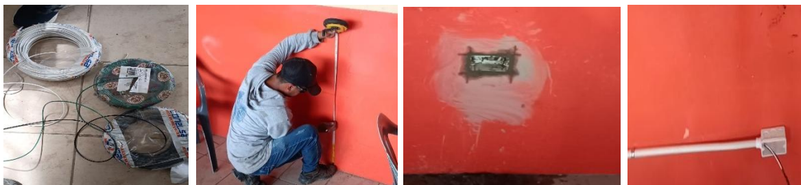
Figura 45. Instalación del nuevo circuito de tomacorriente
