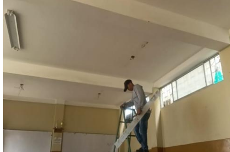
Figura 40. Desmontaje de circuito de luminarias planta baja.
