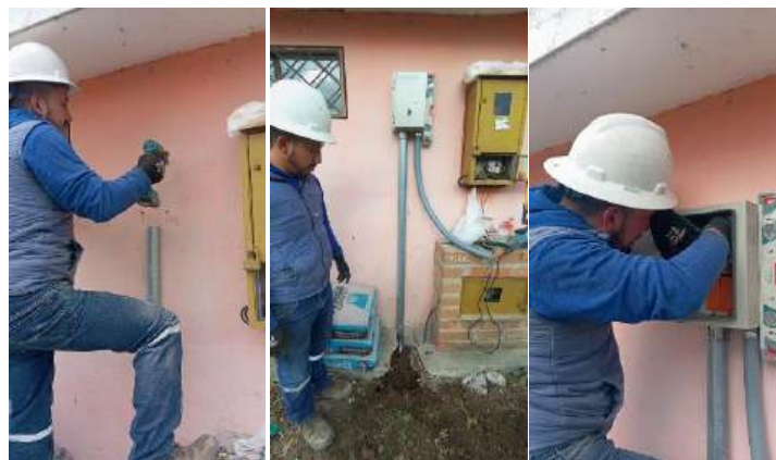
Figura 41. Montaje de tablero de control
