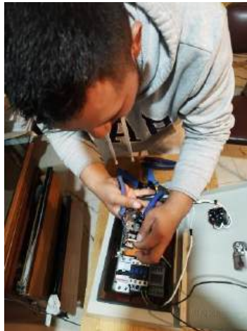
Figura 40. Armado de gabinete metálico
