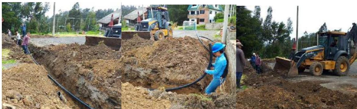
Figura 38. Colocación de tubería y relleno de zanjas.
