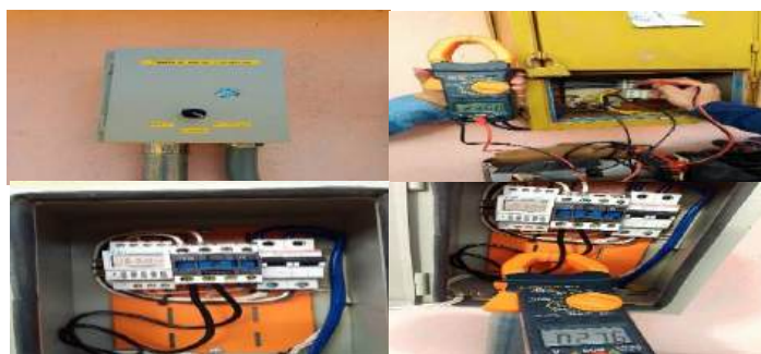
Figura 7. Montaje y conexión de tablero de control.
