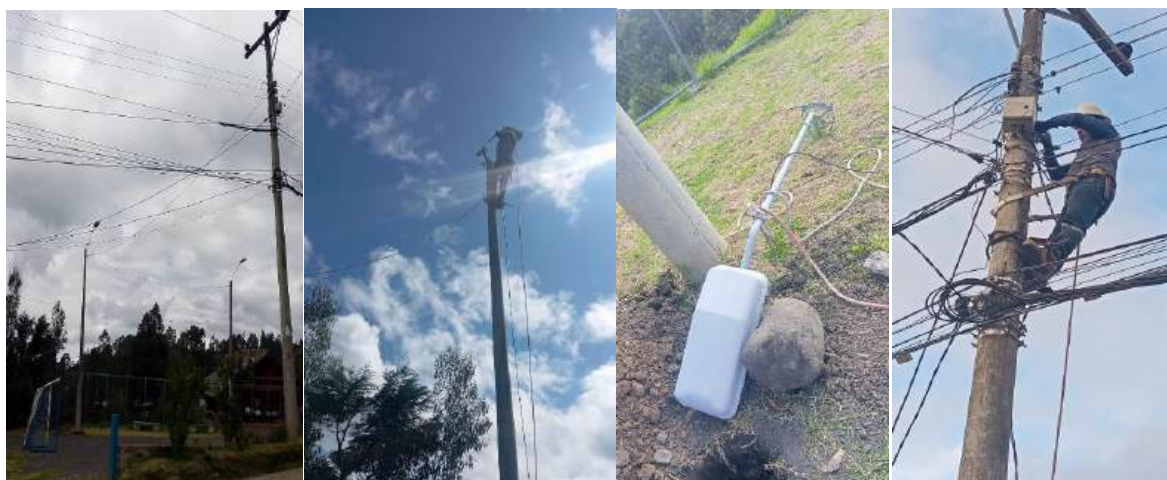
Figura 33. Desmontaje de luminarias de sodio y cableado.
