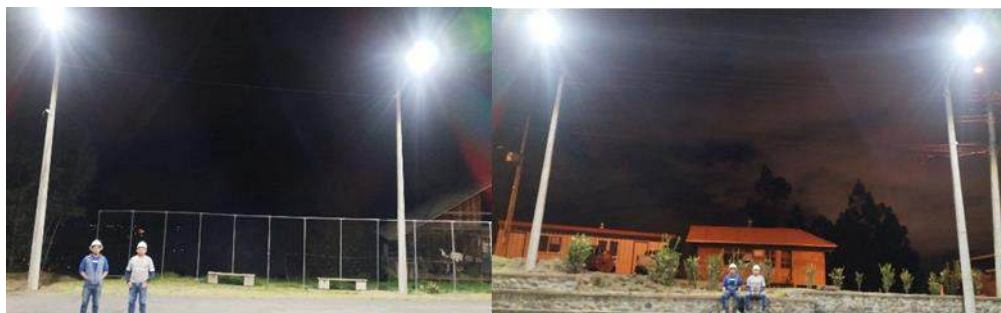
Figura 53. Encendido del sistema de iluminación.
