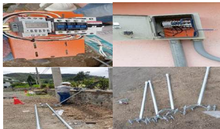
Figura 5. Armado de tablero de control y luminarias.
