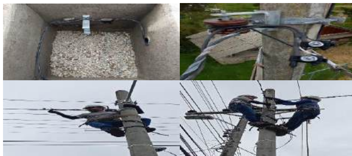
Figura 6. Montaje de estructuras, conductor y luminarias.
