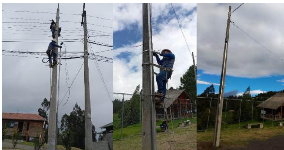
Figura 45. Montaje de transición subterránea-aéreo.
