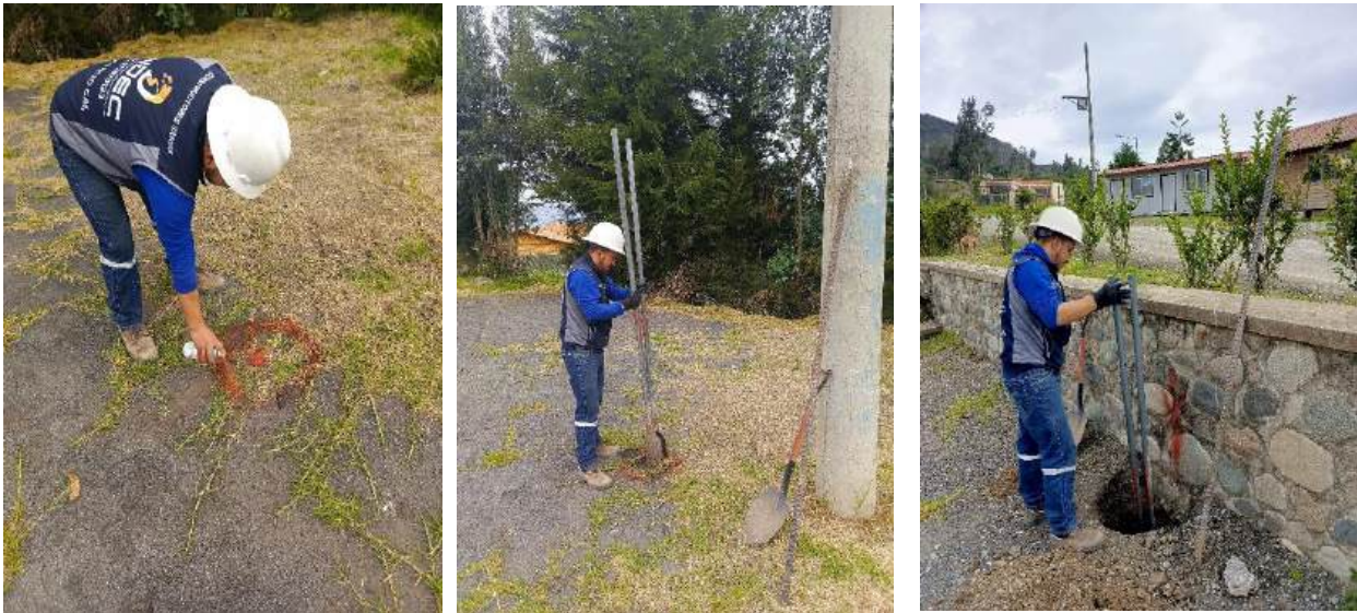
Figura 31. Señalización y excavaciones para postes de 12m.
