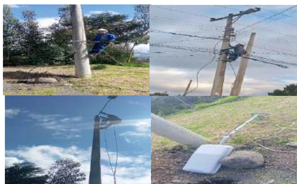
Figura 2. Desmontaje de red y luminarias no funcionales.
