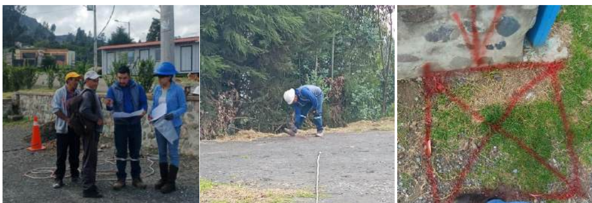
Figura 36. Asesoramiento y señalización para obra civil.
