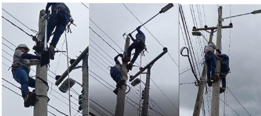
Figura 49. Montaje de luminaria de 150W.
