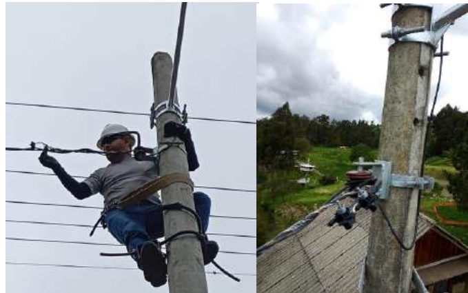
Figura 50. Conexión de luminaria.
