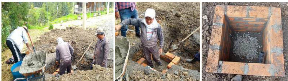
Figura 39. Construcción de pozos de revisión tipo A60x60x75 cm.
