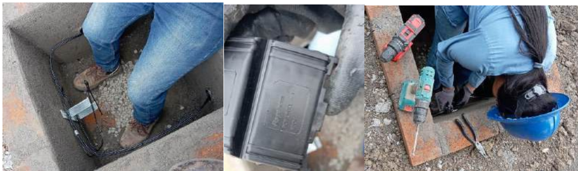
Figura 44. Empalme de derivación en gel.
