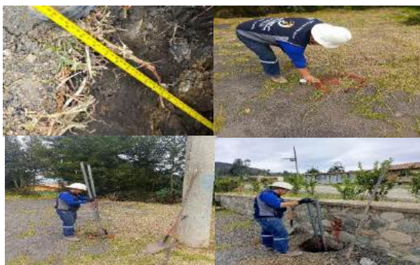
Figura 1. Excavación para postes de hormigón.
