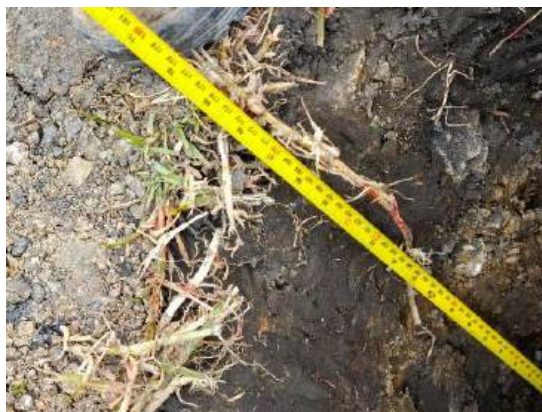
Figura 32. Profundidad de excavación para poste de 12m.
