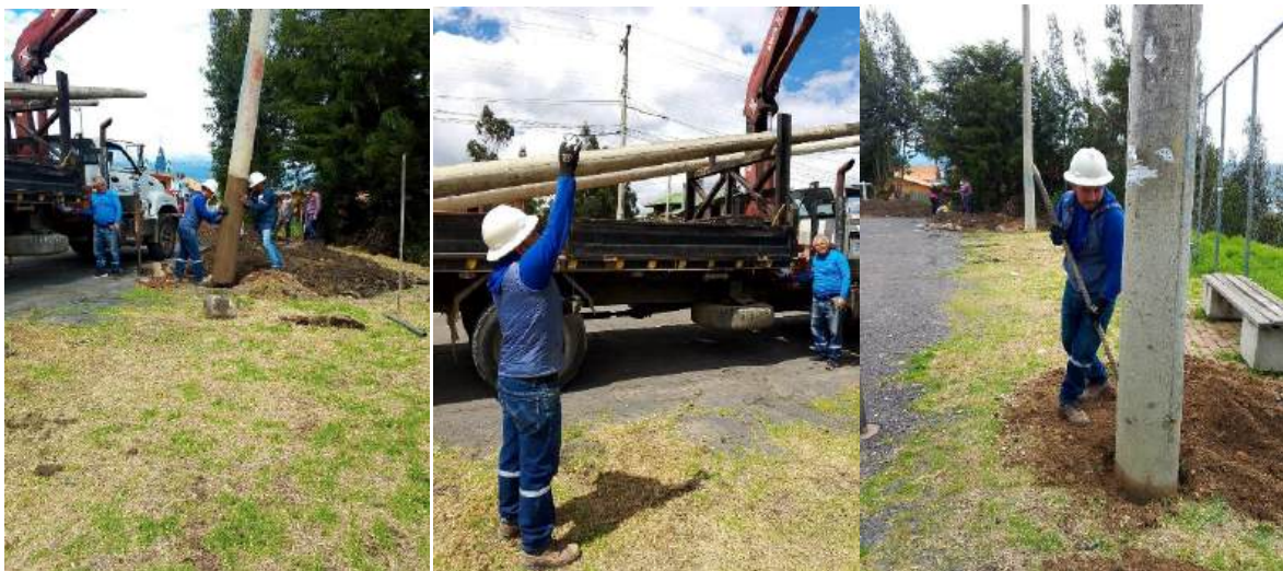
Figura 35. Reubicación e izado de postes de hormigón armado.
