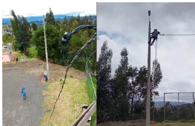
Figura 47. Calibrado de cable dúplex J2x6.
