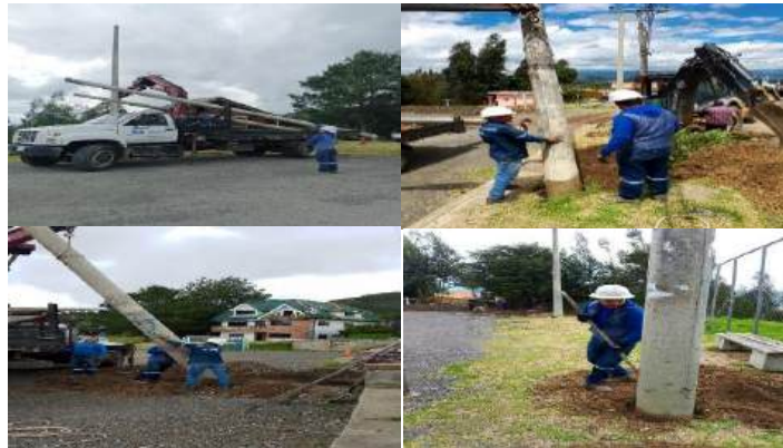
Figura 3. Izado de postes de hormigón de 12m.
