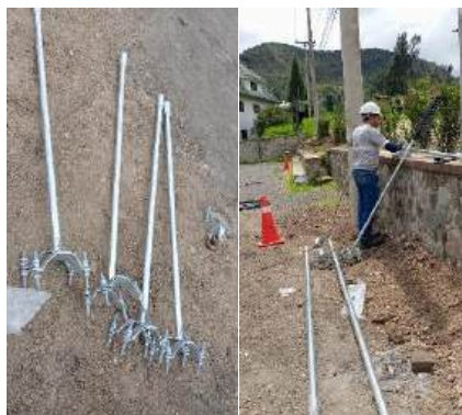
Figura 48. Armado de luminarias de 150W.
