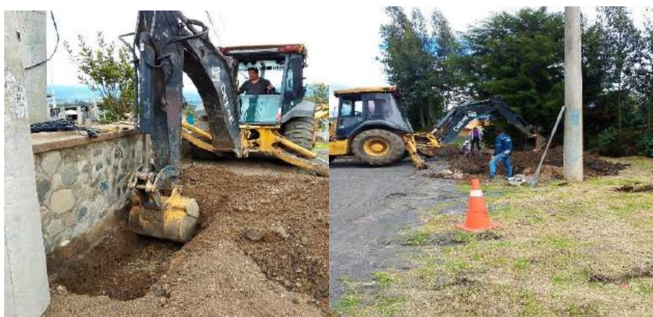
Figura 37. Excavación de zanjas para ductos y pozos de revisión.
