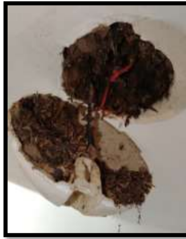
Figura 25. Cajetines con acumulación de suciedad
