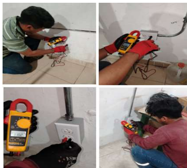
Figura 46. verificación de voltaje en los nuevos tomacorrientes.
