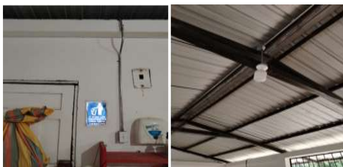
Figura 47. Canalizaciones sobrepuestas
