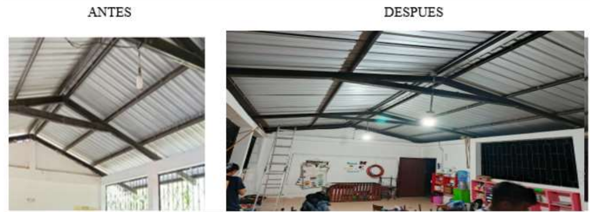
Figura 42. Comparación sistema de iluminación sobrepuesto.
