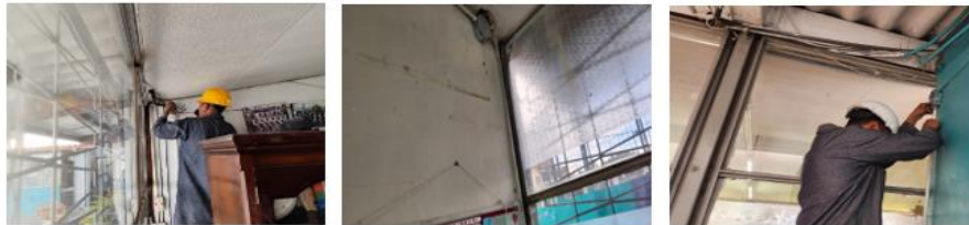
Figura 41. Circuitos de iluminación y fuerza
