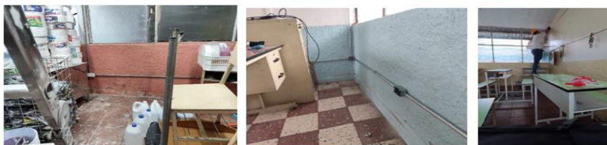
Figura 38. Instalación de tubería MT de ½”
