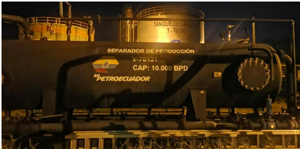
Figura 4. Separador de Producción V-70131
