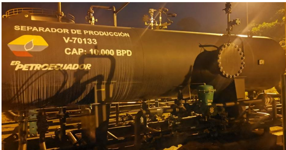
Figura 3. Separador de Producción V-70133
