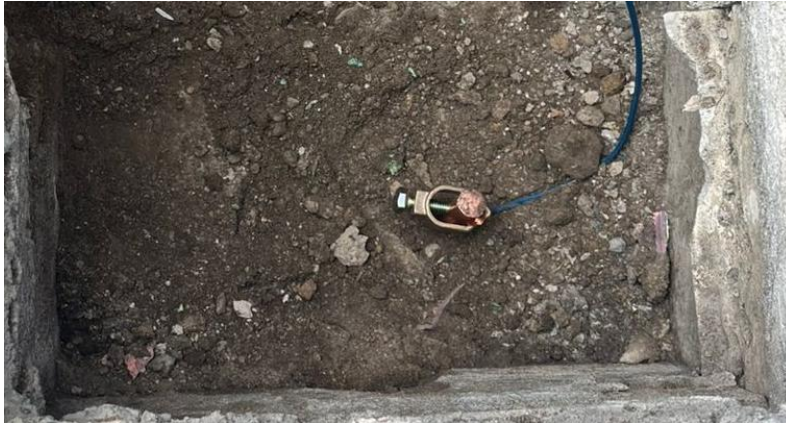
Figura 45 Implementación de varilla puesta a tierra
