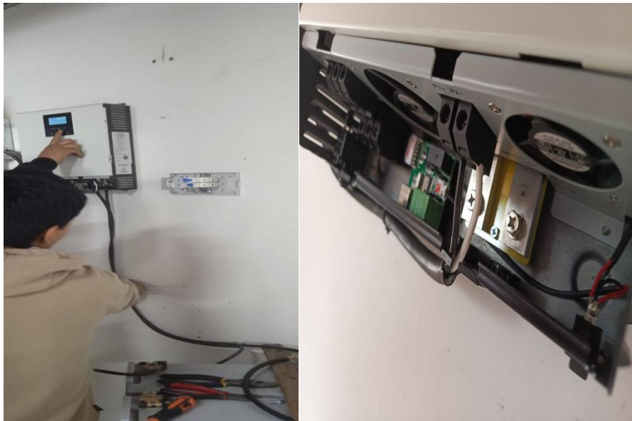
Figura 20 Desmontaje del inversor
