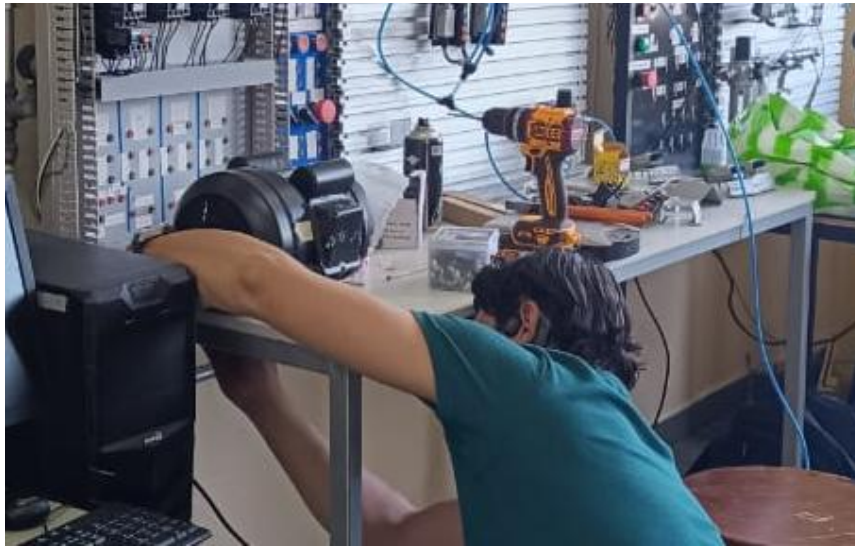
Figura 44. Instalación de motor 1/2 HP
