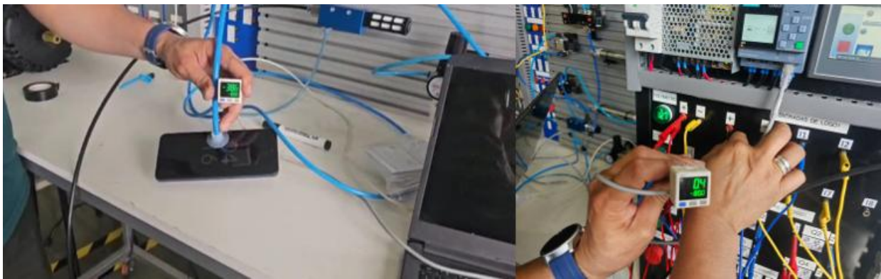
Figura 43. Pruebas de funcionamiento de Generador y Sensor de vacío
