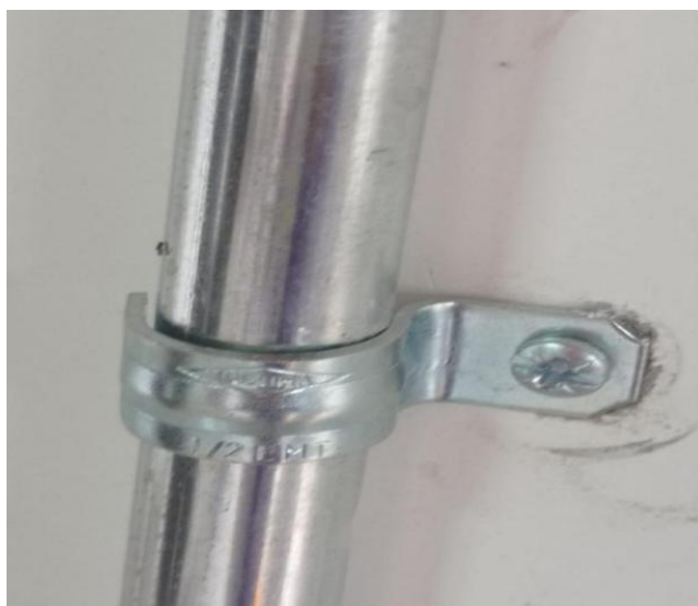
Figura 29 Instalación de tuberías EMT 1/2
