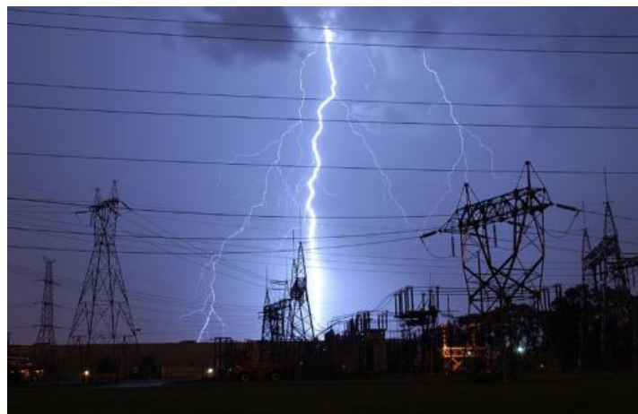
Figura 2 Descargas eléctricas por rayos
