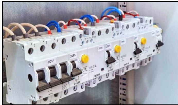
Figura 16: Disyuntores Diferencial
