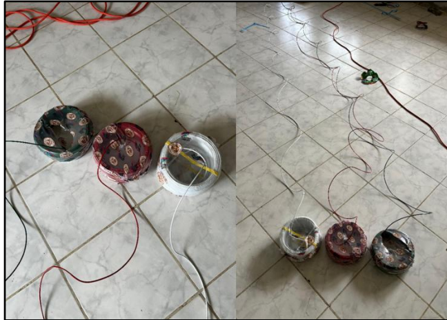
Figura 39: Instalación del Cableado Nuevo
