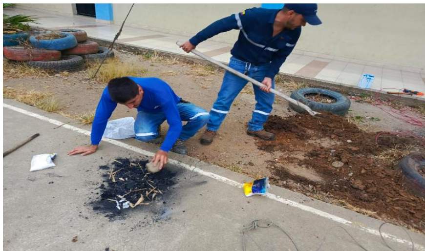
Figura 107 Rellenado de hueco con carbón y sal para mejorar la resistividad del suelo
