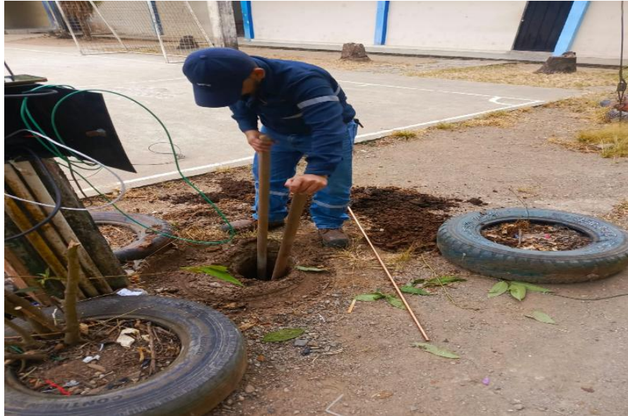
Figura 106 Realización de hueco para colocación de varilla de puesta a tierra
