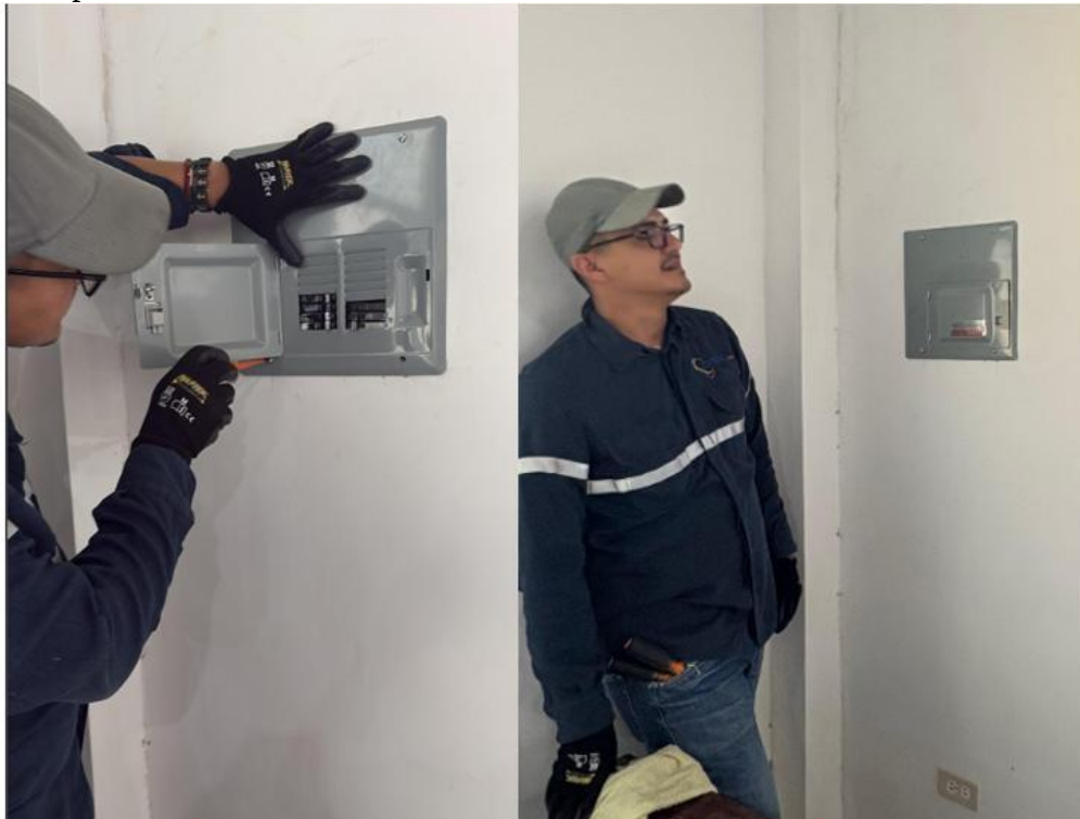
Figura 36. Instalación de panel de distribución PD-IGLESIA
