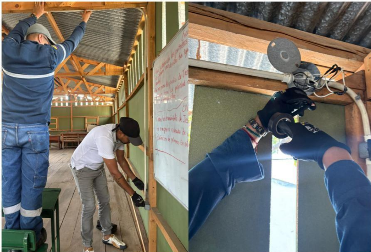
Figura 30. Instalación de tuberías PVC en CNH
