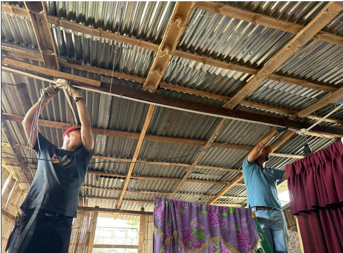
Figura 25. Instalación de tuberías PVC
