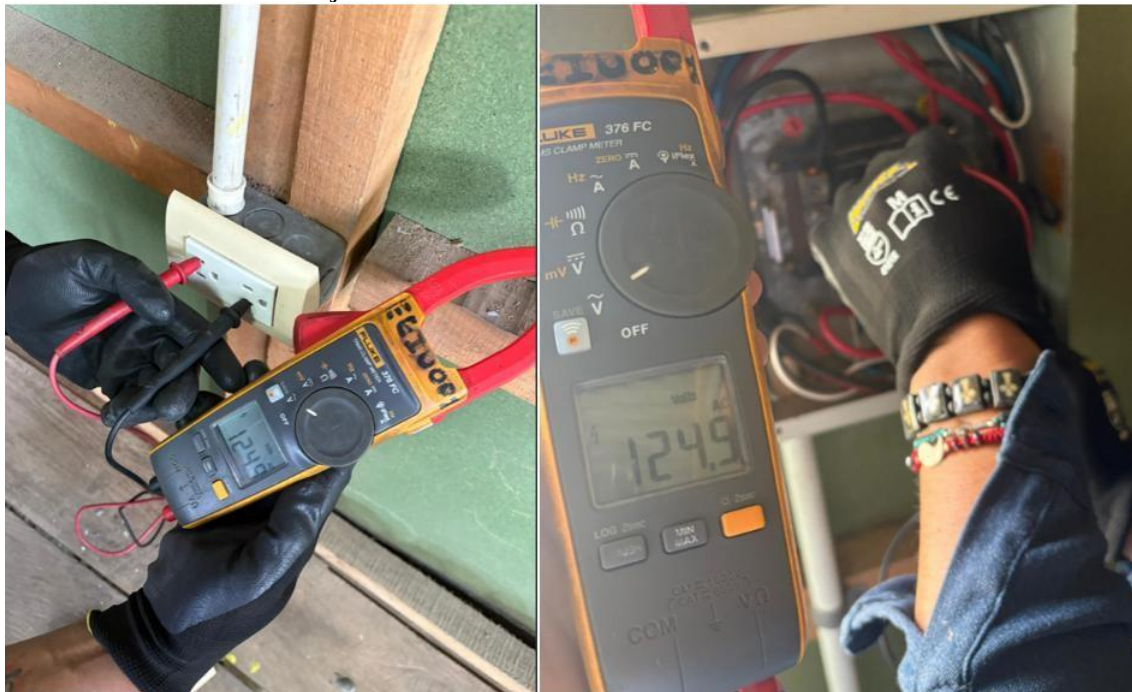
Figura 39. Verificación de caída de voltaje en tomacorrientes
