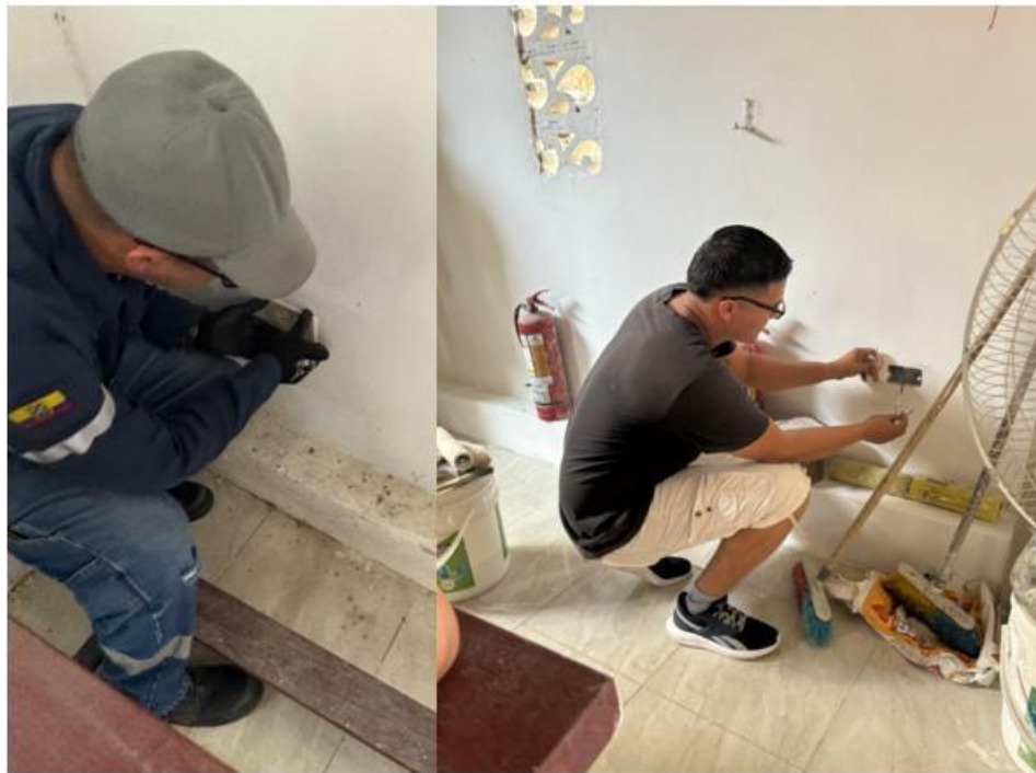
Figura 35. Instalación de tomacorrientes en iglesia
