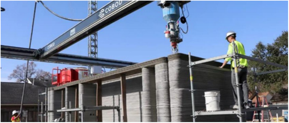
Figura 28. Casa construida con el proceso de impresión 3D.
