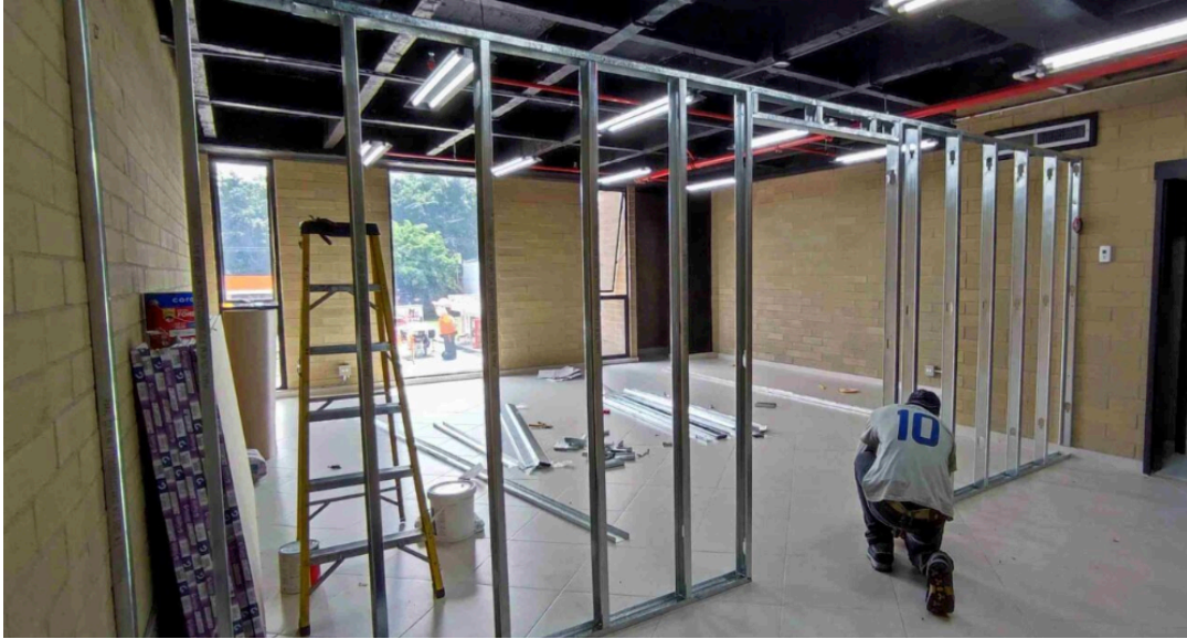
Ilustración 3: Instalación de muros drywall
