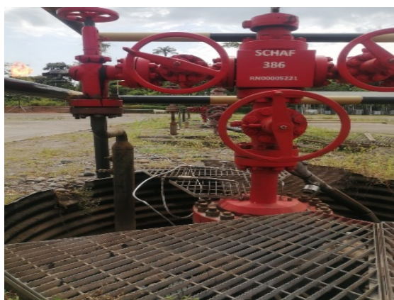
Figura 4 Facilidades de inyección
