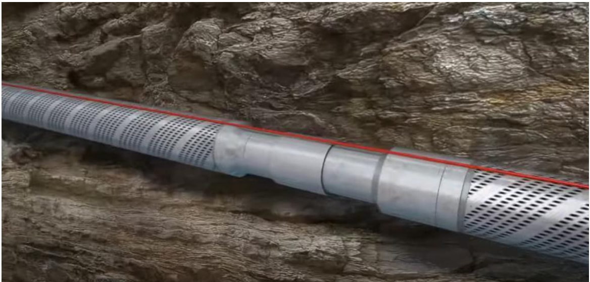
Fig.17.- Fibra óptica instalada en el pozo inferior.
